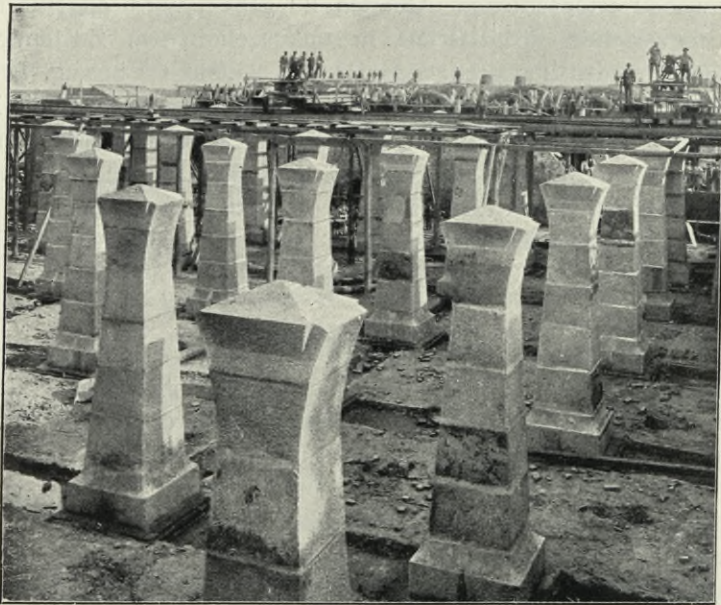
Bau des Wasserbehälters in Breitensee.
