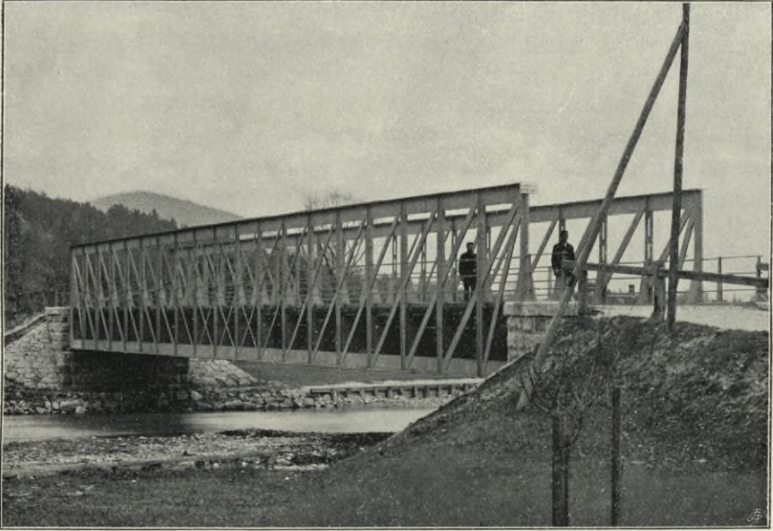
Strassenbrücke über die Schwarza.
