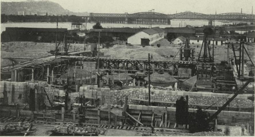
52. Ansicht des Kammerschleusen-Oberhauptes und des Bauplatzes der Wasserkraftanlage von Süden. (Mit dem bereits vollständig verseichten Caissonsperrdamm. Im Hintergrunde die im Umbau begriffene Eisenbahnbrücke.)
