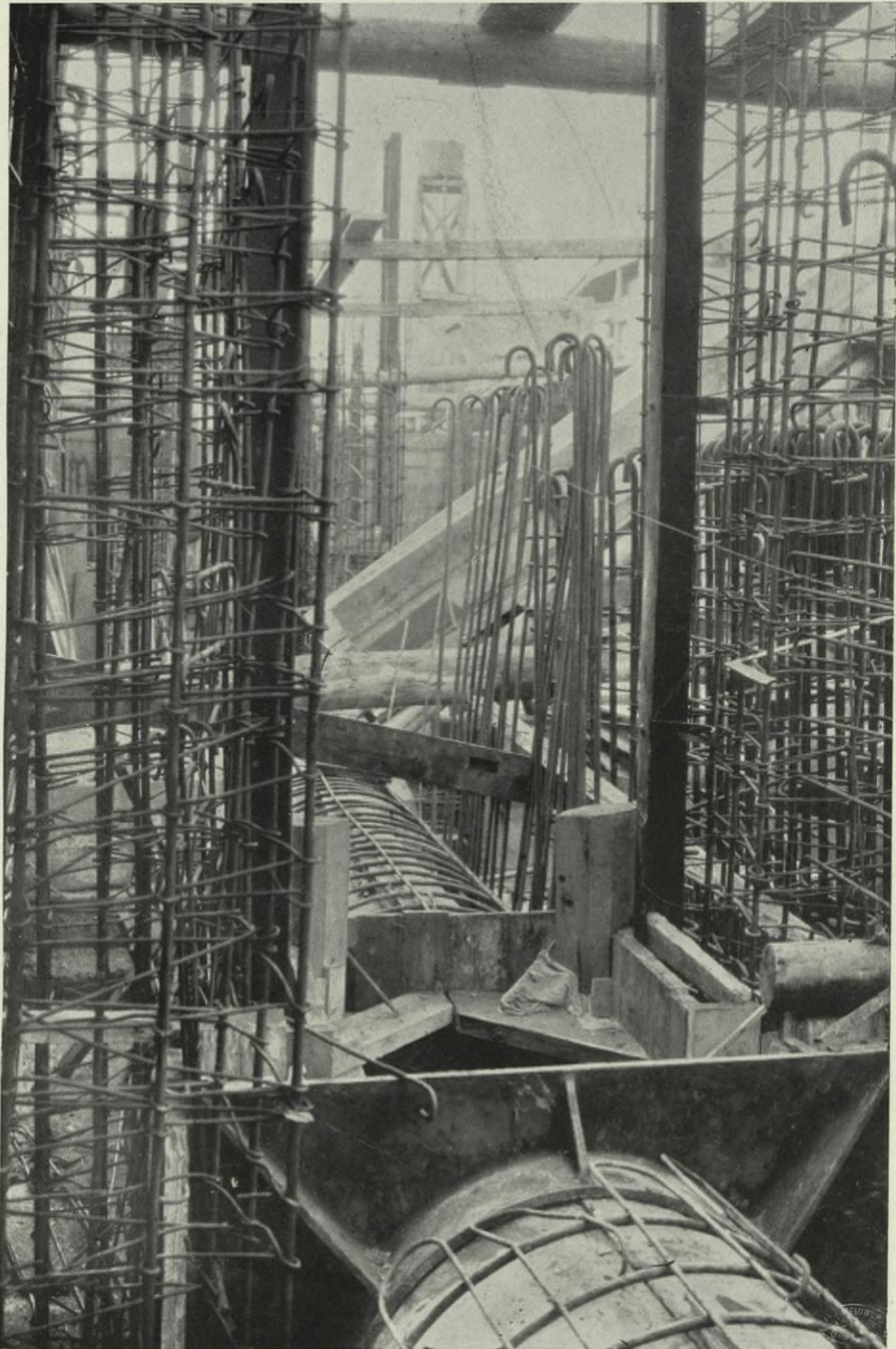
37. Kammerschleuse. Eiseneinlagen bei dem Schüttenschacht.
