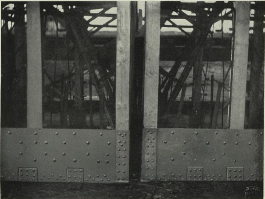
59. Eisenkonstruktion der Caissonencken vor der Verschalung (beim Wasserkraftwerk).
