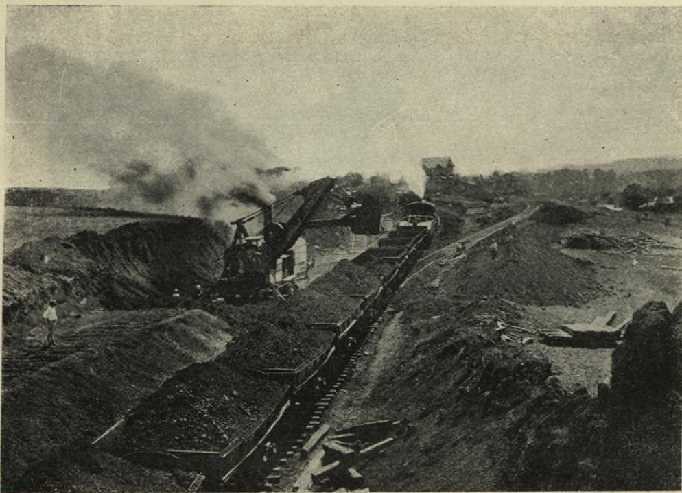
Отрывка грунта паровой лопатой и нагрузка его на поѣздъ. (Къ стр. 45, 46 и 49).
