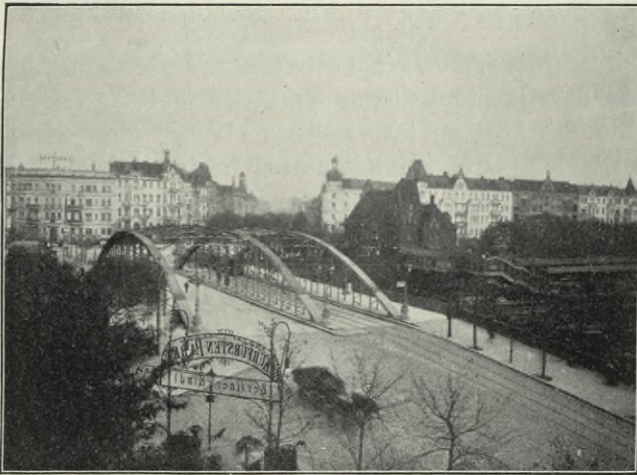
Ringbahnhof und Brücke in Halensee.
