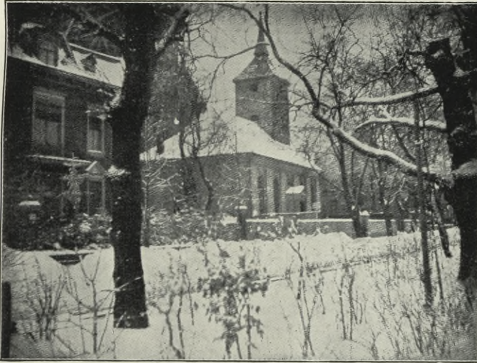
Alte Dorfkirche in der Wilhelmsau in den Jahren 1895—1897 durch einen Neubau' ersetzt.
