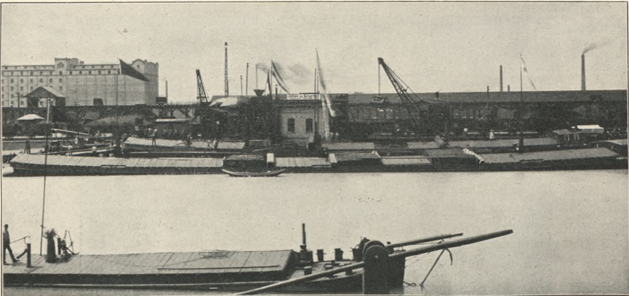
Anlagen mit Hochbahn in Mannheim.
