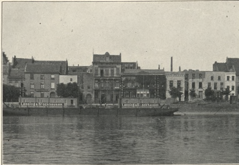
Bureaux und Brückenschiffe der Firma Lensing & Brockhausen in Emmerich.
