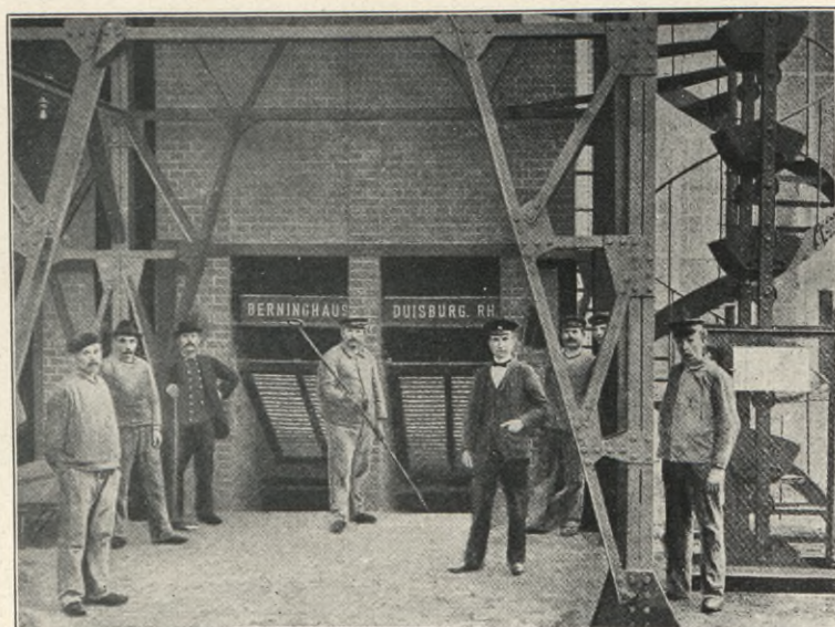
Treppenrostfeuerung für Braunkohle, System Berninghaus, erzielte auf der Ausstellung Düsseldorf 1902 bei den officiellen Versuchen von den konkurrierenden Systemen die besten Resultate.
