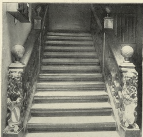
Straßburg. Treppenanfänger im Hof Barbaragasse 15. 18. Jahrh.
