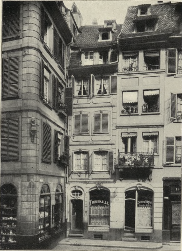
Straßburg. Domplatz 11/12. Ansicht der Fassaden
