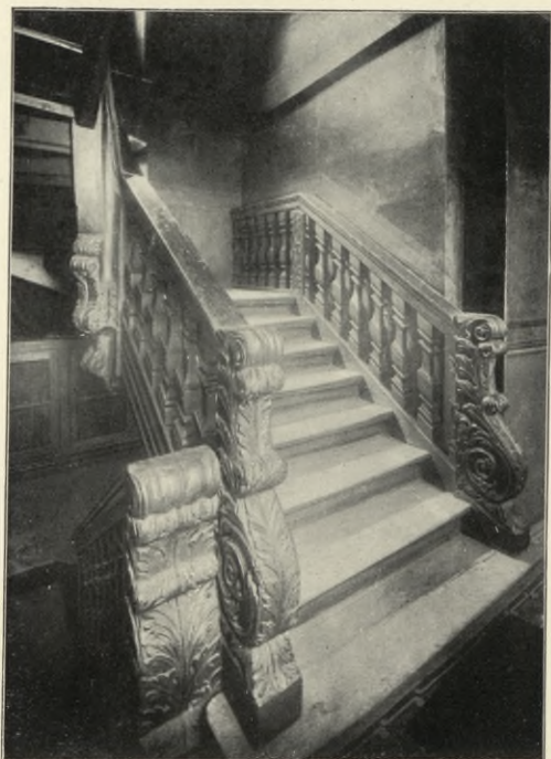
Straßburg. Treppenaufgang im Hofe Bruderhofgasse 19
