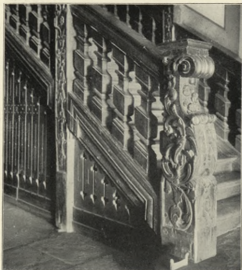
Straßburg. Treppengeländer vom Jahre 1711
