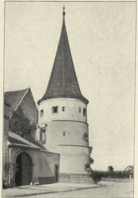
Ammerschweier. Turm der Ortsbefestigung
