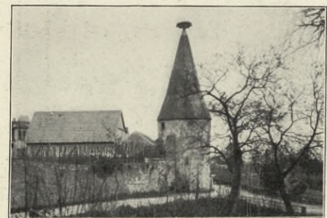
Rappoltsweiler. Turm der Stadtbefestigung
