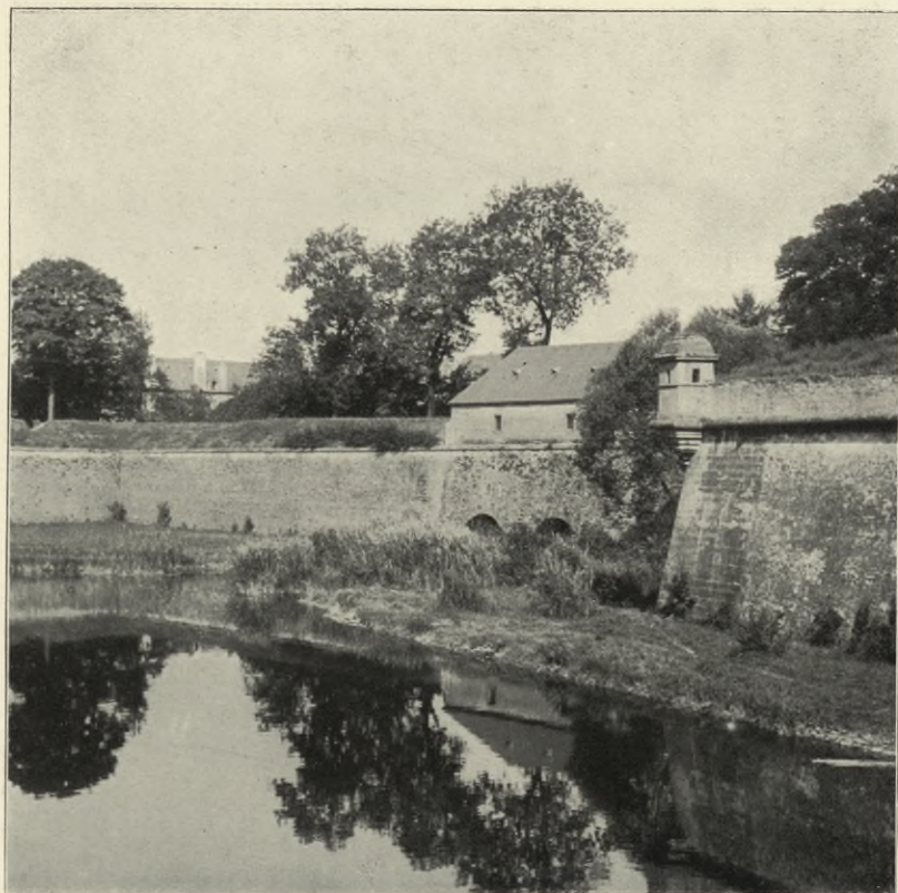
Metz. Graben am Mazellentor. Früherer Zustand Phot. Prillot, Metz
