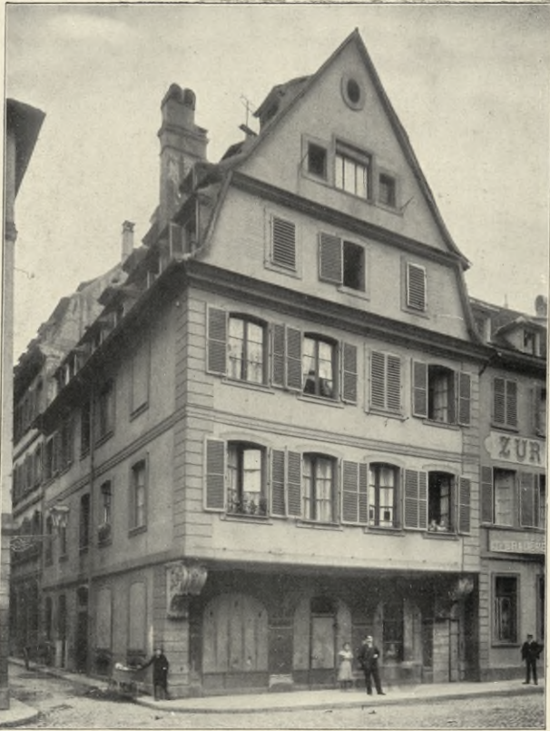
Straßburg. Haus in der Kaufhausgasse. Ende des 17. Jahrhunderts
