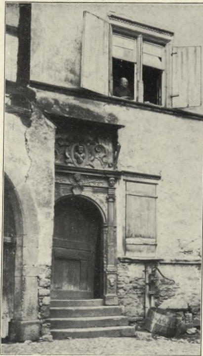
Egisheim. Portal des 17. Jahrhunderts
