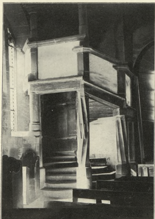
Ammerschweier. Kirche. Treppenaufgang zur Orgel
