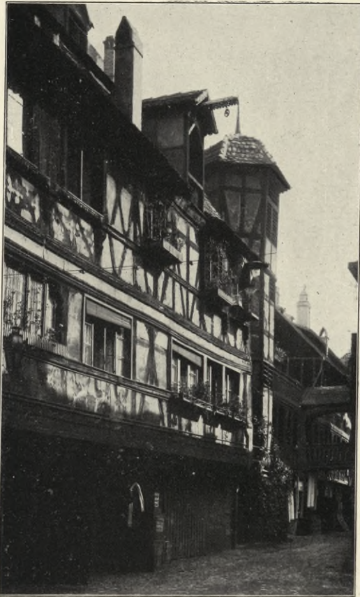
Straßburg. Holzfachwerkhäuser im Rabenhof von 1580 u. 1632
