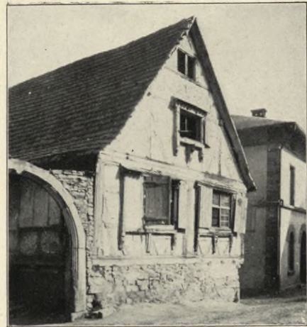
Dangolsheim. Holzfachwerkhaus. 16. Jahrh.
