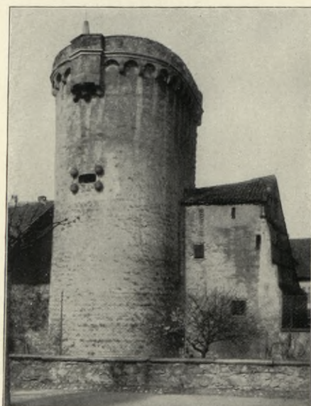
Oberehnheim. Turm der Stadtbefestigung
