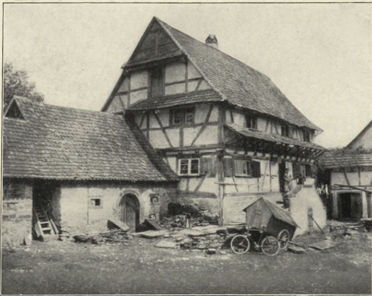
Zutzendorf. Holzfachwerkhaus. Zehnthof. Um 1530
