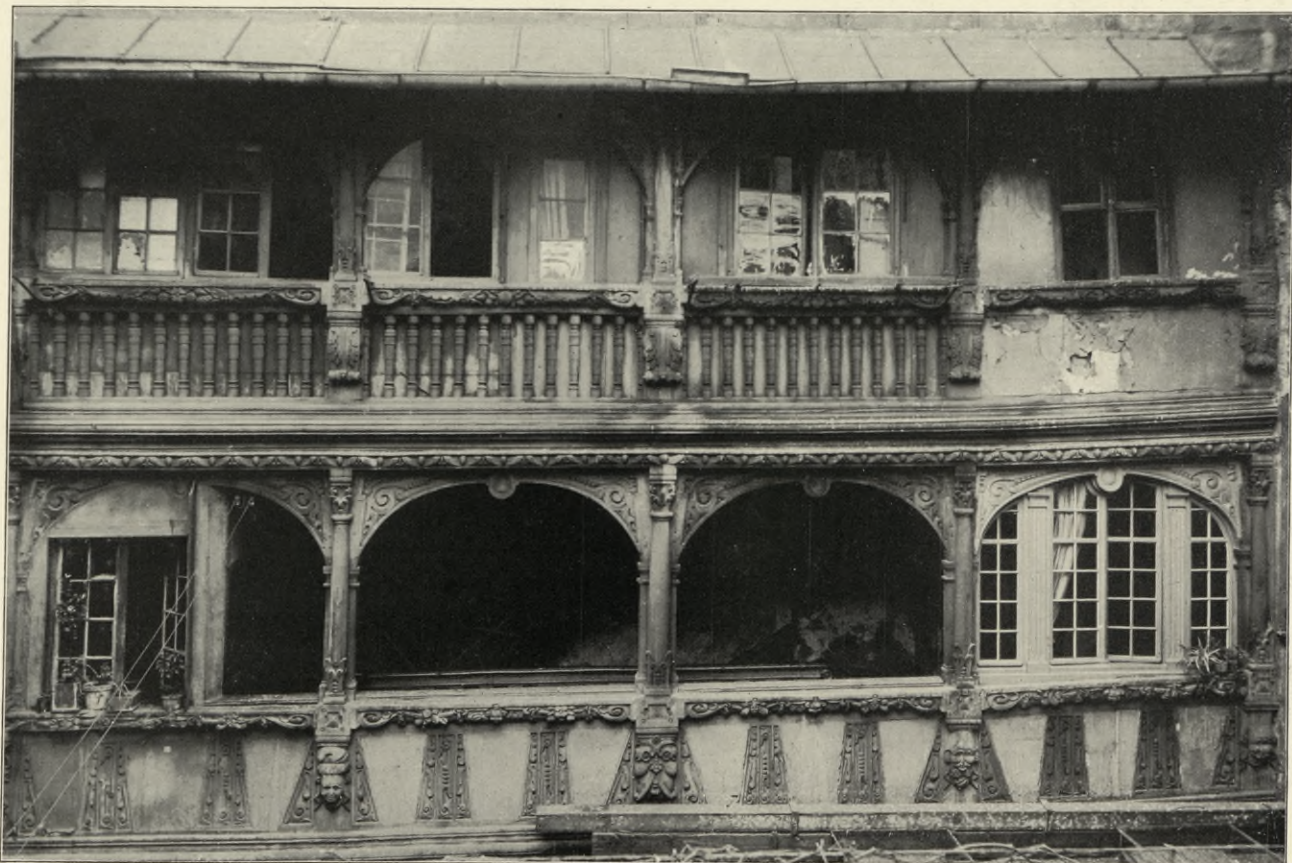
Straßburg. Galerie im Hofe der ehemaligen Schmiede-Trinkstube. Erbaut 1657.
