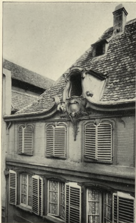
Straßburg. Haus Kalbsgasse 20. Um 1750
