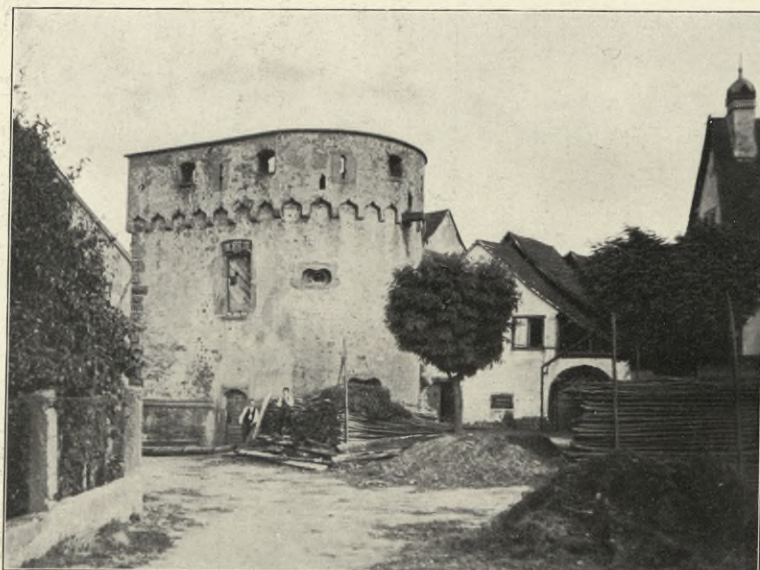
Ammerschweier. Turm der Stadtbefestigung. 15. Jahrh.
