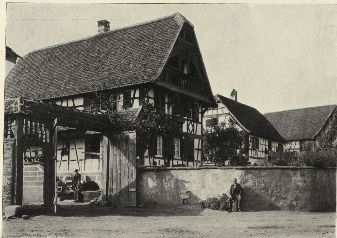
Zutzendorf. Holzfachwerkhaus mit Giebelgalerie. Erbaut um 1800
