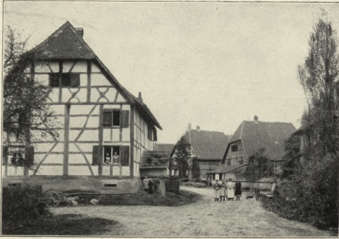
Altenach. Altes Ständerfachwerkhaus. 17. Jahrh.
