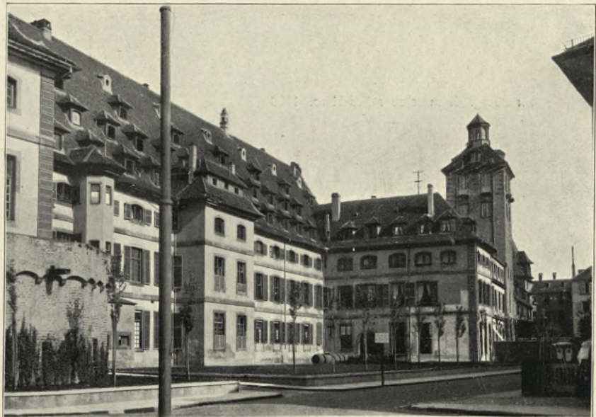
Straßburg. Bürgerspital. Ansicht von außen
