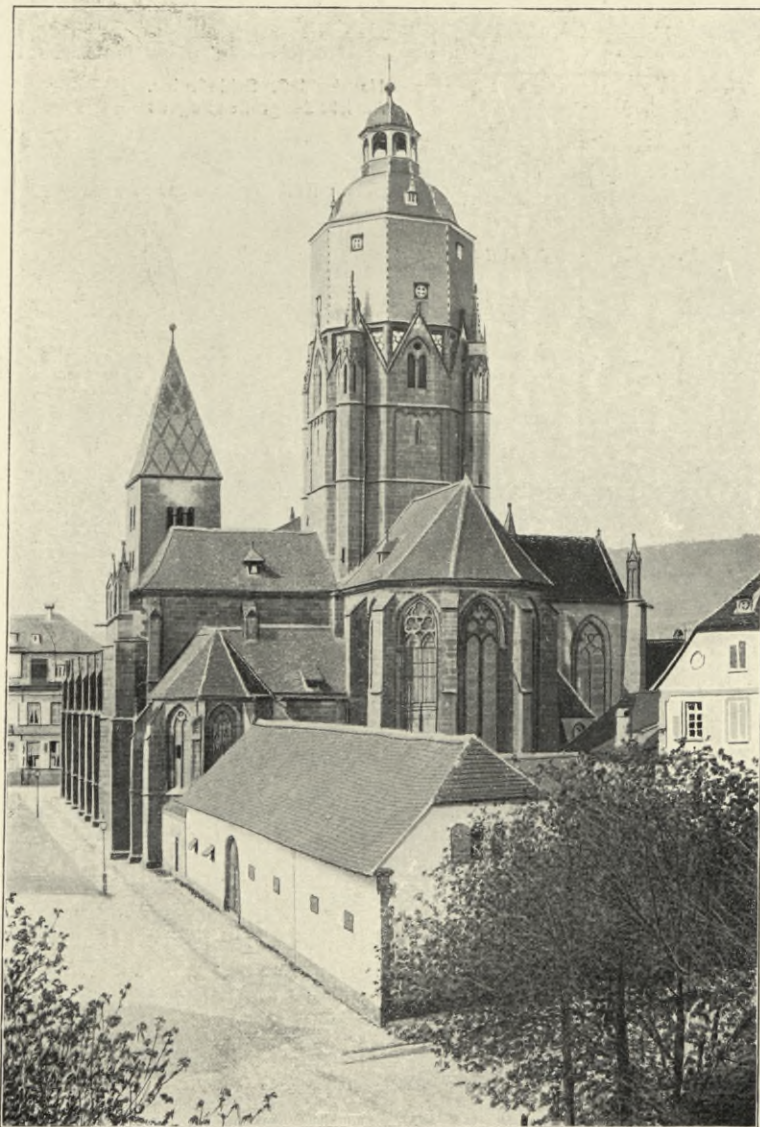
Weissenburg. St. Peter- und Pauls-Kirche. Vor Erneuerung des Vierungsturmhelms
