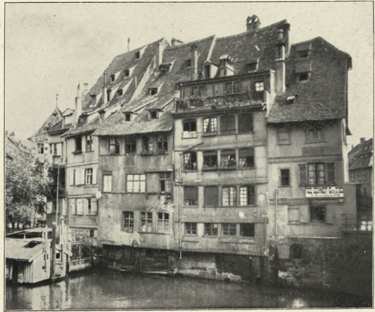
Straßburg. Häusergruppe an der Rabenbrücke. 16. Jahrh.
