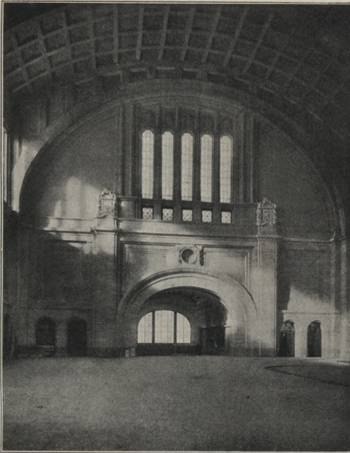
Abb. 37. Querbahnsteighalle Hauptbahnhof Leipzig.
