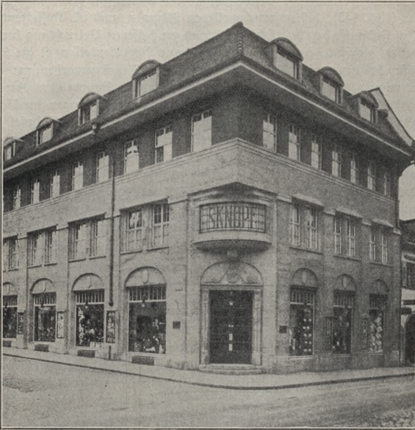
Abb. 147. Warenhaus Knopf, Lörrach i. W.
