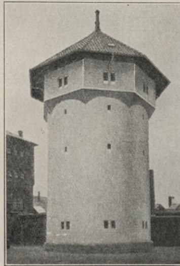
Abb. 98. Wasserturm in Gedser.
