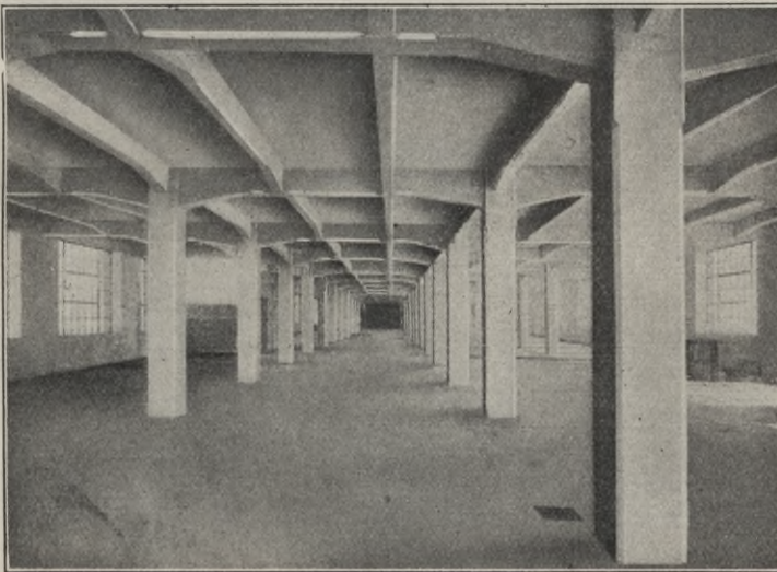
Abb. 31. Lagerhaus der Chem. Fabriken A. G. Merdingen a. Rh.
