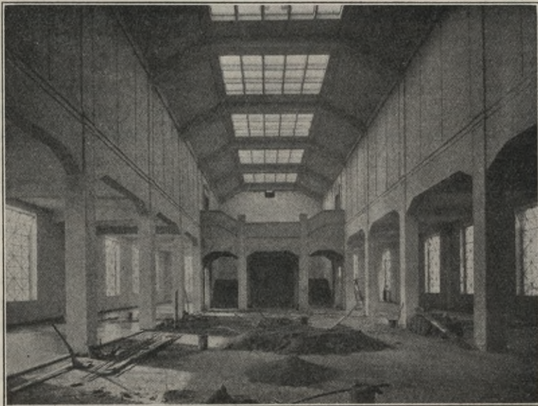
Abb. 193. Betonhalle Leipzig, westliche Seitenhalle.
