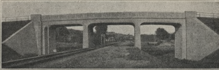
Abb. 80. Straßenüberführung über eine viergleisige Strecke.
