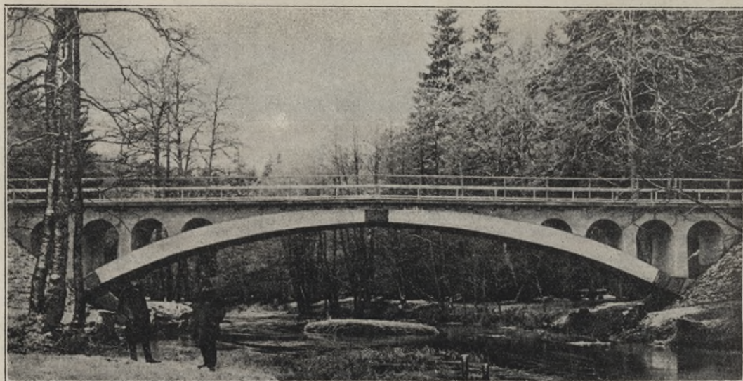
Abb. 62. Heydenbrücke im Kaiserl. Jagdrevier Rominten. Spannweite 25,00 m. Stampfbeton mit drei Gelenken aus Betonquardern.
