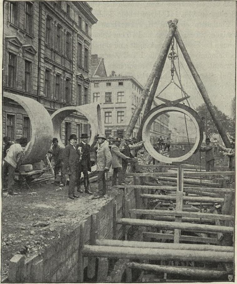
Abb. 142. Das Verlegen von Monierrohren. (Aktien-Gesellschaft für Beton- und Monierbau.)
