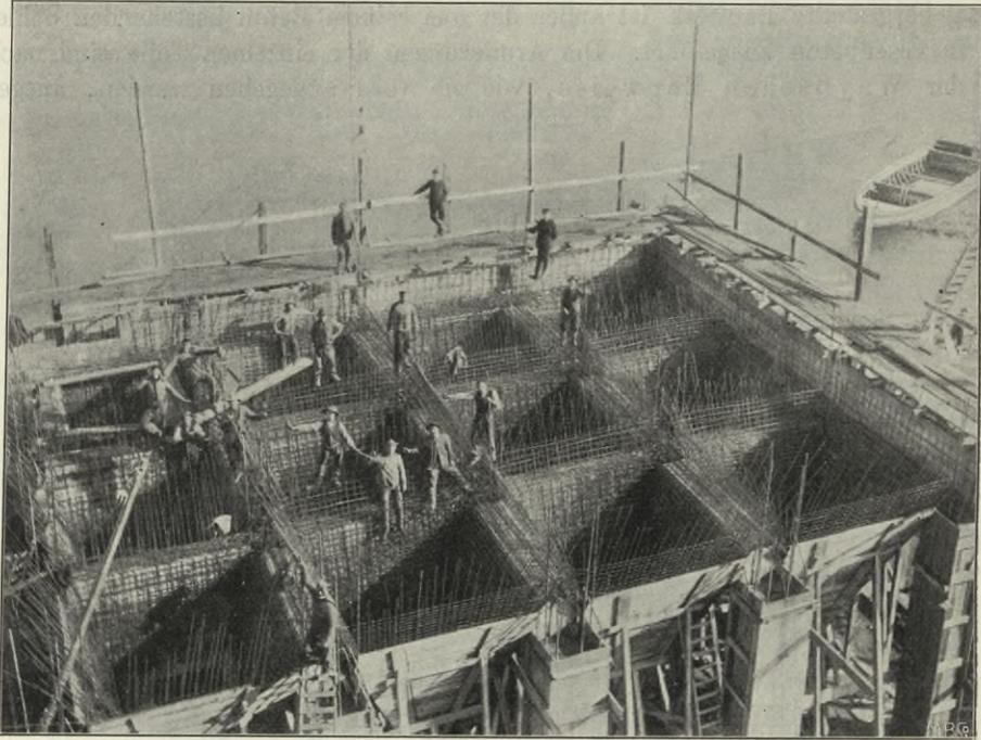
Abb. 161. Ausführung eines Silobaues (Wayß & Freytag).
