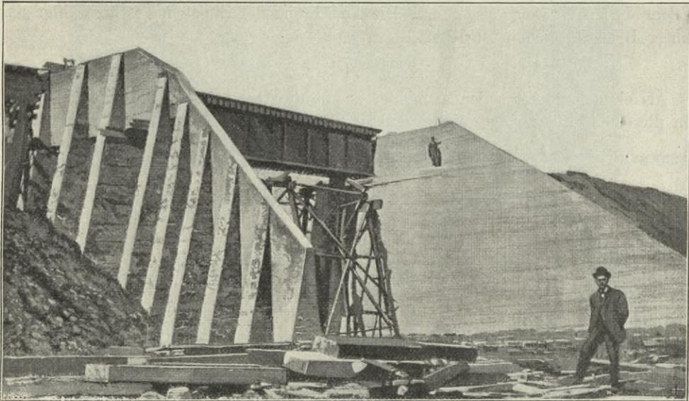
Abb. 108. Brückenwiderlager in Eisenbeton.
