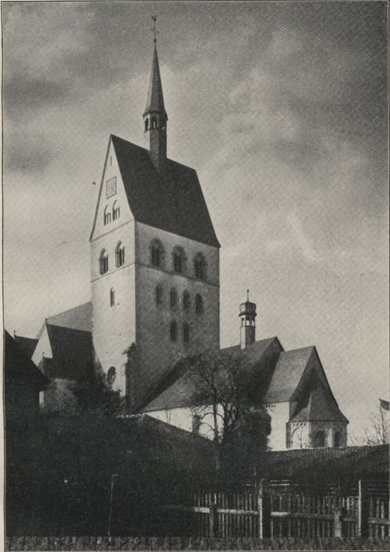
Abb. 323. Katholische Kirche in Kirchlinde bei Dortmund. Südostansicht.
