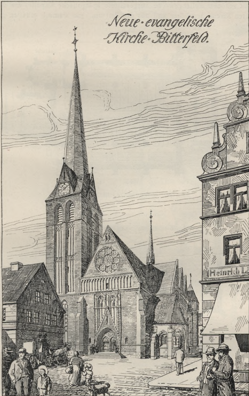
Abb. 196. Evangelische Kirche in Bitterfeld. Ansicht von Süden.
