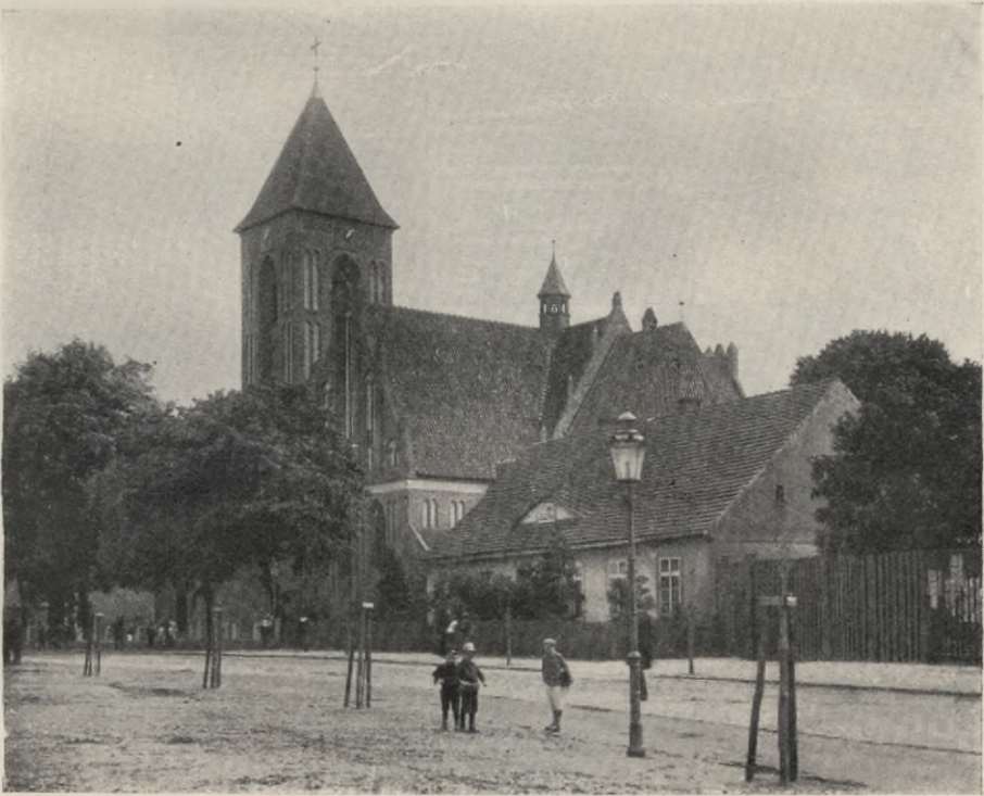
Abb. 313. Katholische Kirche in Czersk mit (altem) Pfarrhaus. Ansicht von Nordwesten.
