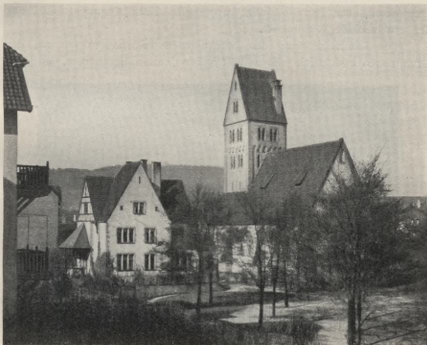
Abb. 265. Ansicht von Osten.
