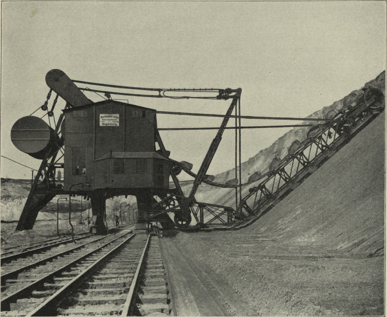
Abbildung 12. M. F. B.-Trockenbagger, Hochbagger.
