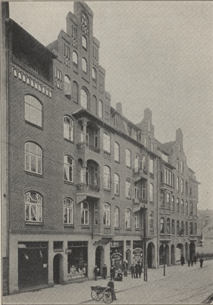
Bild 67. Wohn- und Geschäftshaus in Kiel.
