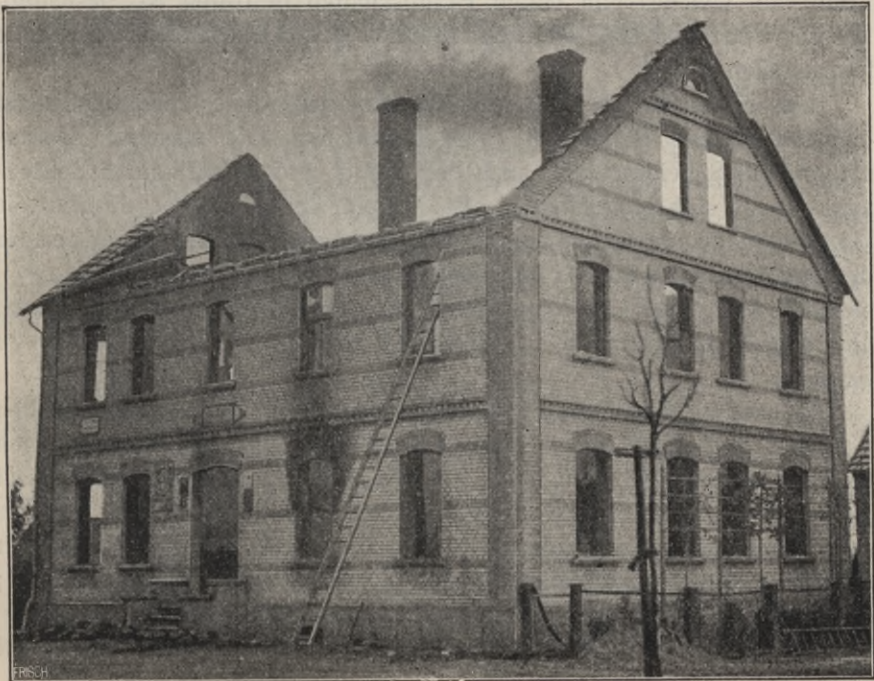
Bild 57. Brandstätte in Holzhausen.
