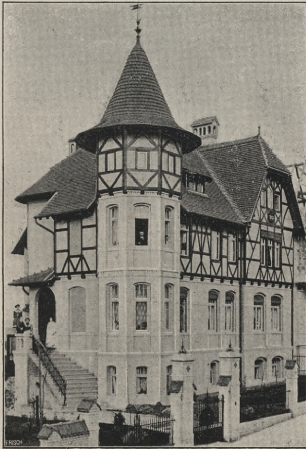
Bild 18. Kalksandsteingebäude in Halle a. S., Tiergartenstraße.
