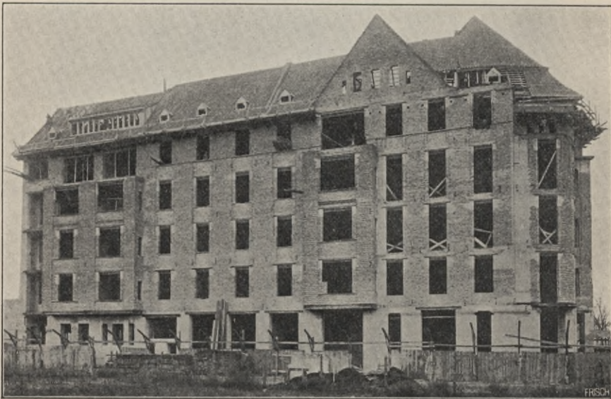
Bild 68. Berliner Ziegelrohbau mit in Kalksandsteinen verlegten T-Trägern usw.
