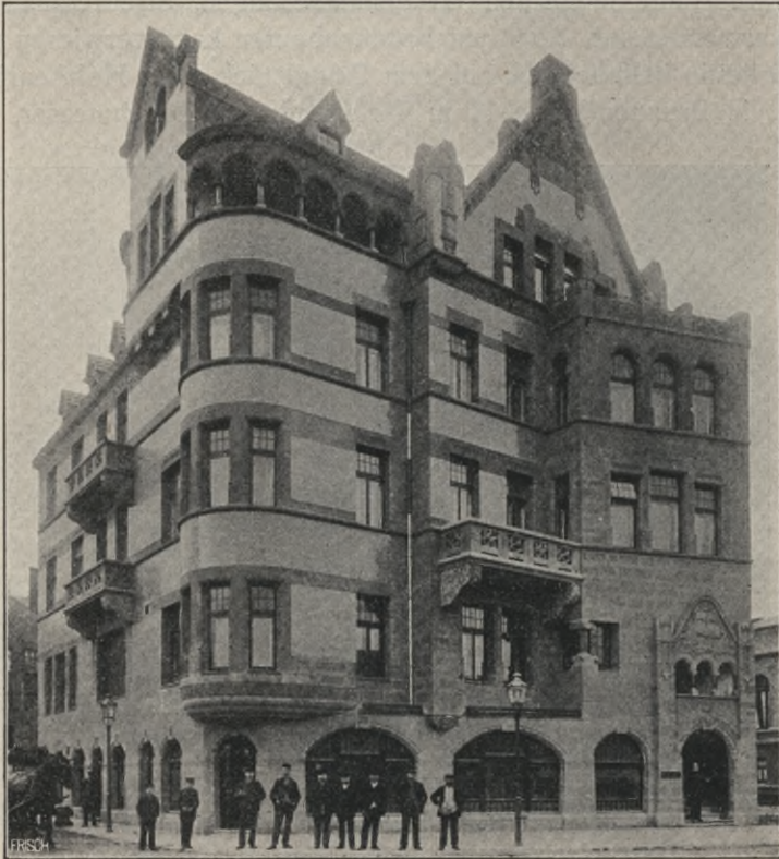
Bild 66. Wohn- und Geschäftshaus in Kiel.
