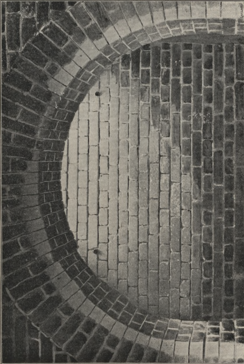
Bild 49. Gurtbogen und Zwischenwand des Versuchshäuschens nach dem Ablöschen.
