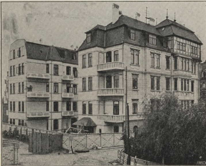
Bild 37. Kalksandsteinrohbau in Lehe.
