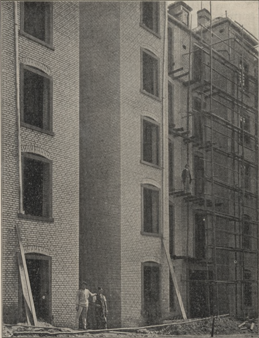
Bild 15. Rohbau aus Kalksandsteinen.
