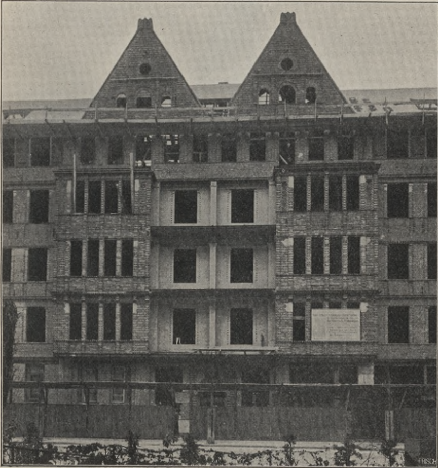
Bild 69. Berliner Ziegelbau mit in Kalksandsteinen verlegten T-Trägern usw.
