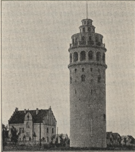
Bild 62. Wasserturm in Niederlehme.
