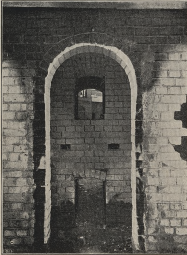
Bild 46. Versuchshäuschen in Kiel nach dem Brande.
