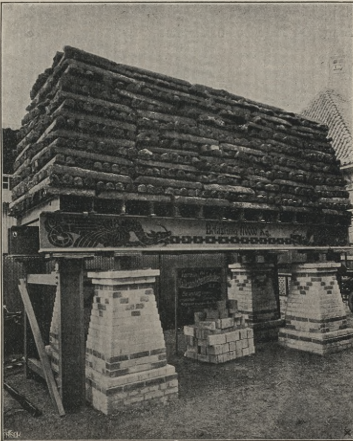
Bild 28. Belastungsprobe mit Kalksandsteinen.
