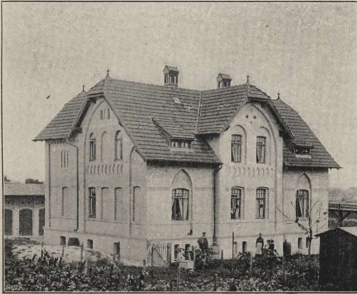
Bild 25. Beamtenwohnhaus der Dölauer Hartsteinfabrik in Döläu, die Kalksandsteinflächen ungeputzt zeigt.
