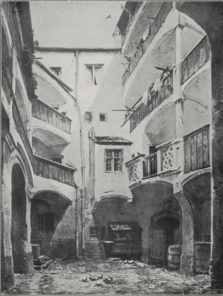
Abb. 7. Ehemaliger Hof im Hause Tal Nr. 2, abgebrochen 1861. Nach einem Gemälde bezeichnet: „F. Kirchner, d. 16. Juni 1860“ (früher im Besitz des Herrn Pfister, dann des Herrn Örtel, jetzt in unbekanntem Besitz.)
