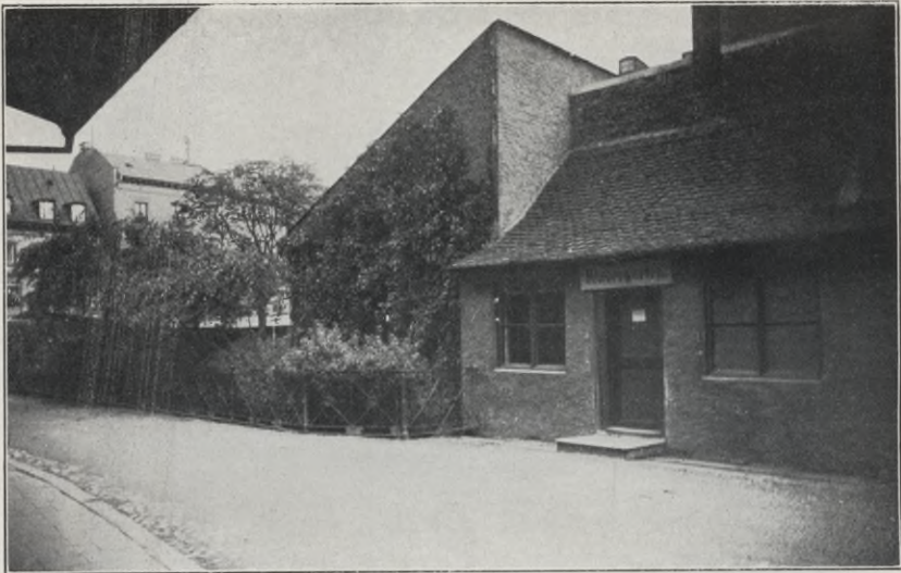
Abb. 14. Das Nebengebäude von Ledererstraße Nr. 2 vor dem Abbruch im Jahre 1898.
