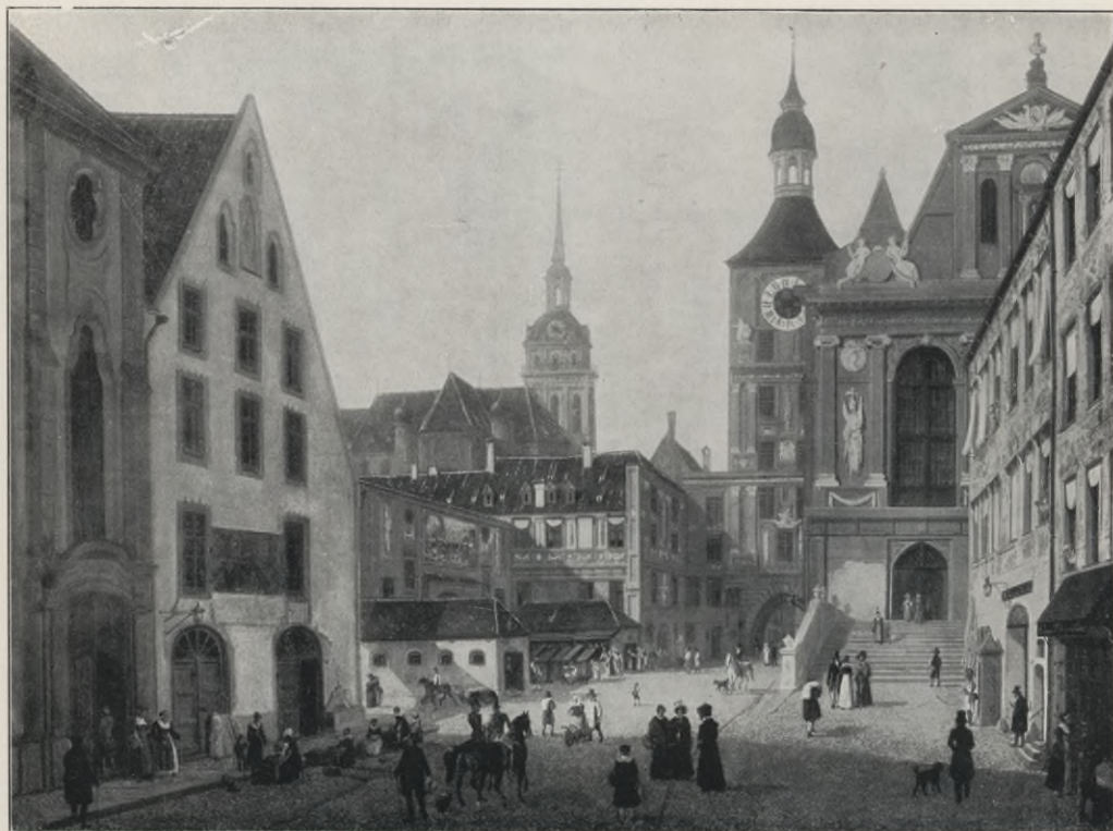
Abb. 8. Ansicht der Gebäude Tal Nr. 1 und Nr. 2 im Jahre 1808. Nach dem in städtischen Besitz befindlichen Oelgemälde von Dominikus Quaglio.
