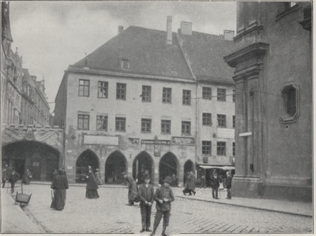
Abb. 27. Ansicht der Gebäude Tal Nr. 1 und Nr. 2 und der Verkaufsläden über dem Pfisterbach vor dem Abbruch im Jahre 1906.
