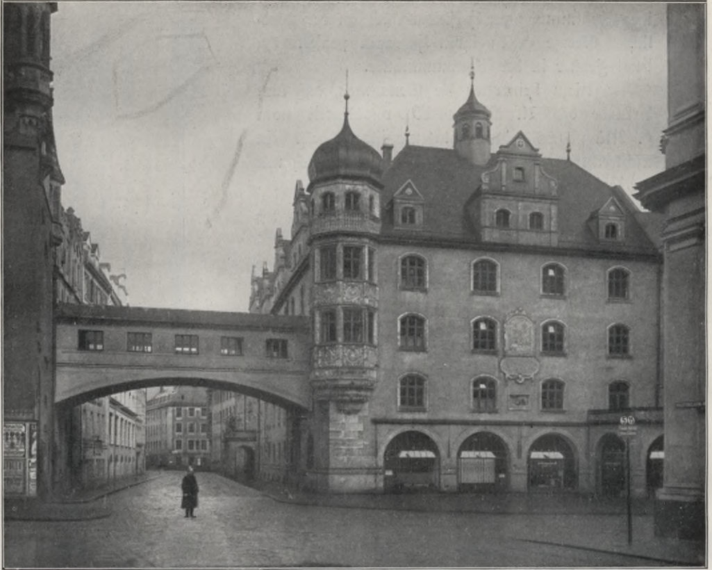
Abb. 42. Die neue Sparkassenstraße vom Tal her gesehen, mit dem neuen Stadtbauamts- und Sparkasse-Gebäude und dem Uebergang zum alten Rathaus.
