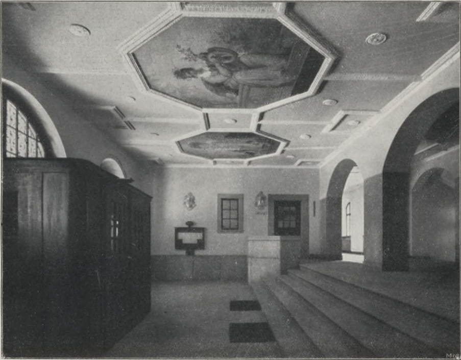
Abb. 48. Der Haupteingang zum Stadtbanamt.
