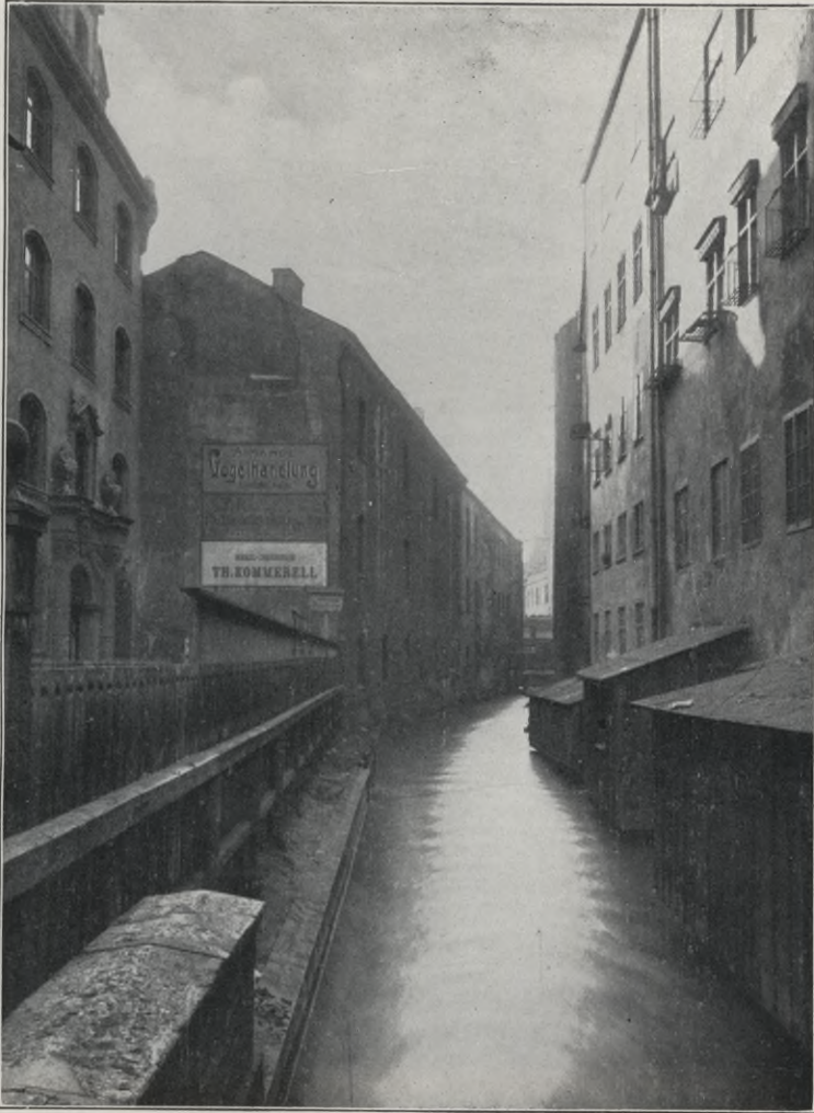
Abb. 25. Ansicht zum Lageplan Abb. 15. (Links das neue Sparkassegebäude, dahinter der Rest des alten Administrationsgebäudes.
