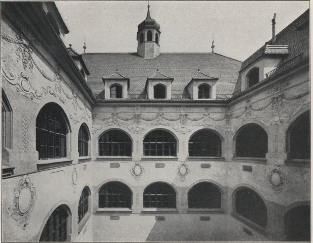
Abb. 20. Licht Hof der oberen Geschosse des Sparkassegebäudes.
