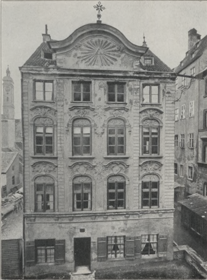
Abb. 15. Ansicht des Gebäudes Ledererstraße Nr. 2 seit Mitte des 18. Jahrhunderts. Abgebrochen im Jahre 1898.
