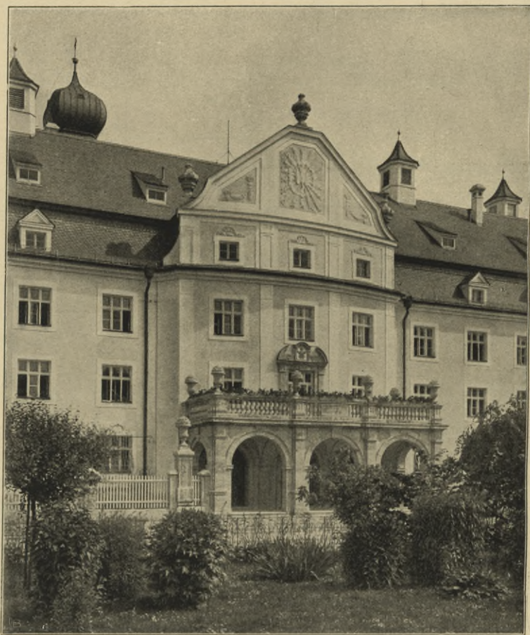
Abb. 36. Haupteingang am Dom Pedro-Platz.
