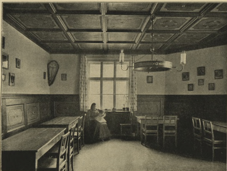
Abb. 48. Unterhaltungsraum im I. Obergeschoß gegen den Dom Pedroplatz.
