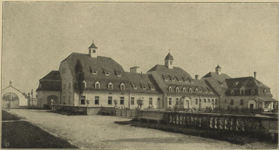
Abb. 38. Ansicht des Nebengebäudes.
