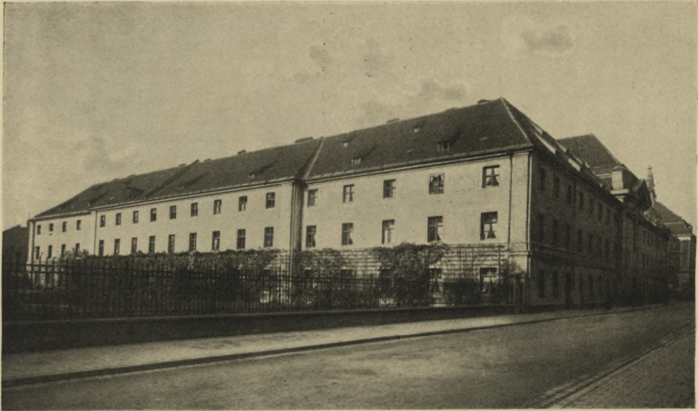
Abb. 20. Das ehem. Heiliggeistspital an der Mathildenstraße im Jahre 1907. Ansicht des Hauptgebäudes von Süd-Osten.
