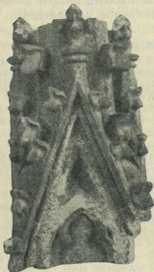
Fig. 194. Durch Rauchgase zerstörter Sandstein am Kölner Dom. Nach E. Kaiser.
