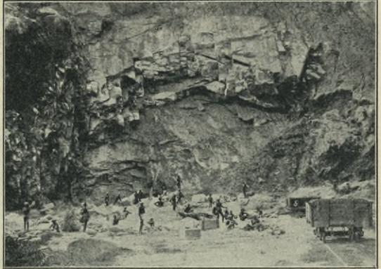
Fig. 235. Steinbruch in zerklüftetem Granit.
