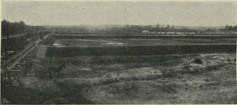
Filterbett von Worcester im Bau.
