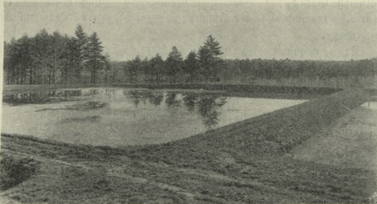
Filterbett in Clinton mit Abwasser beschickt.
