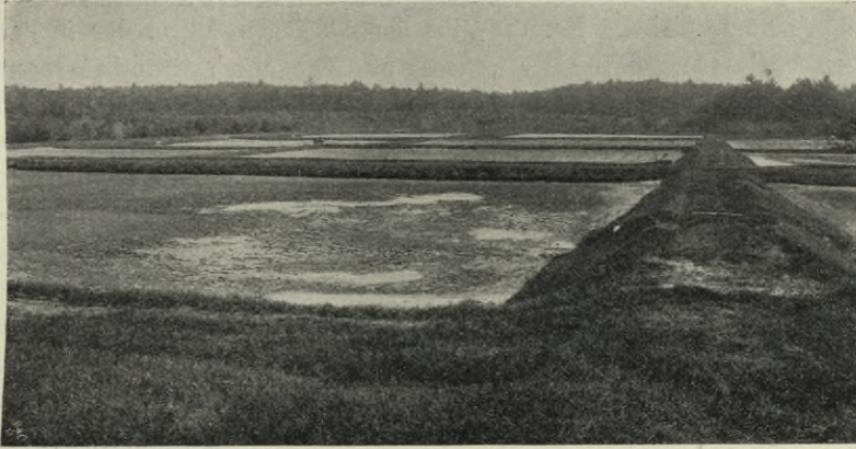
Filterbett von Marlborough mit Schlammansammlung.
