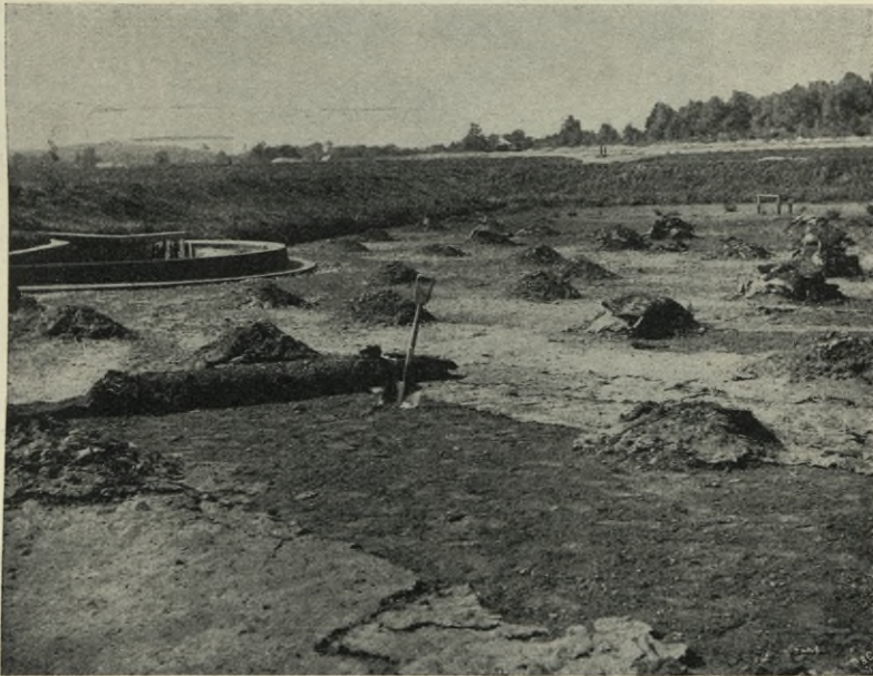
Filterbett von Worcester mit rohem Abwasser beschickt.
