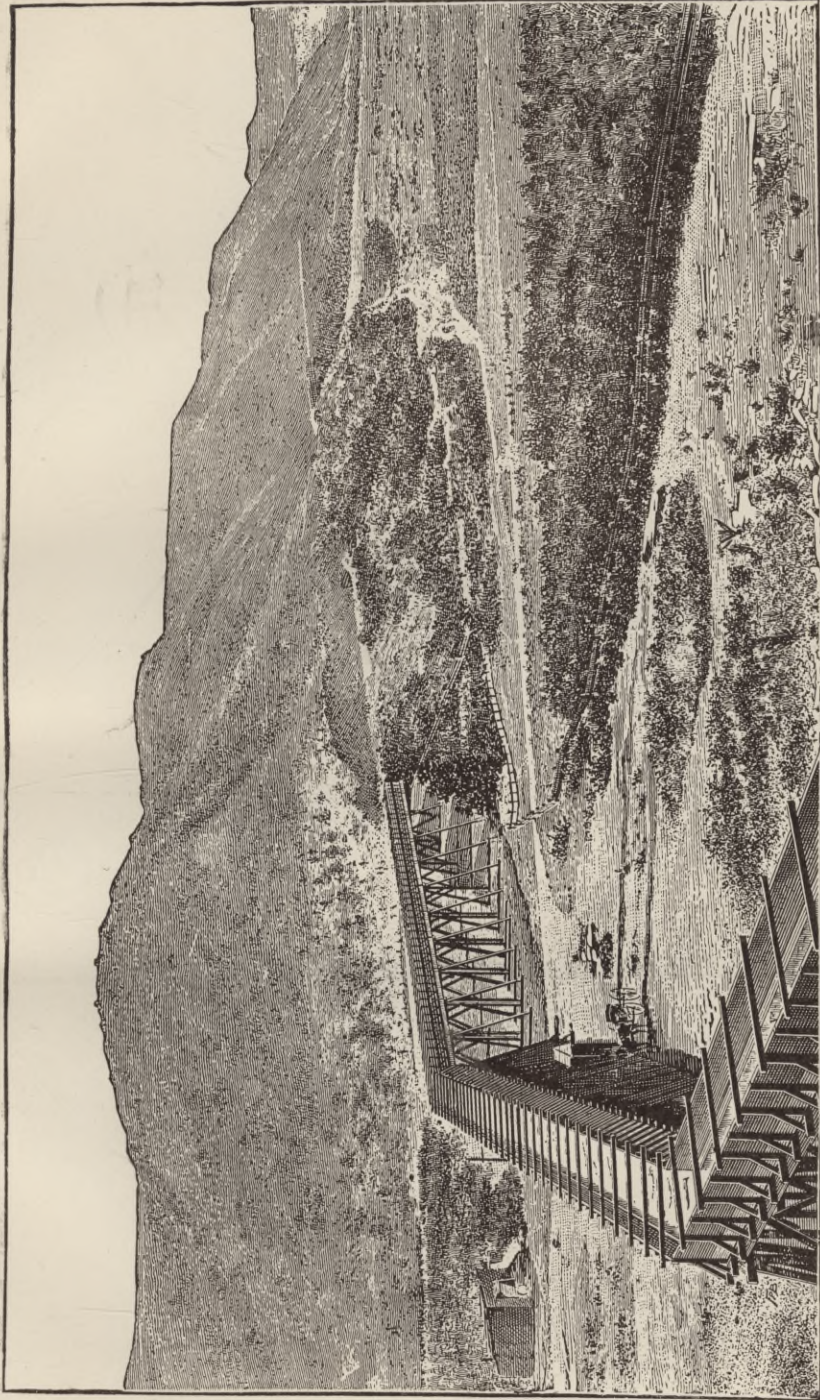
Riverside, Californien. Aquaduct aus Holz zur Ueberführung des Bewässerungscanals über ein Thal (Flume).
