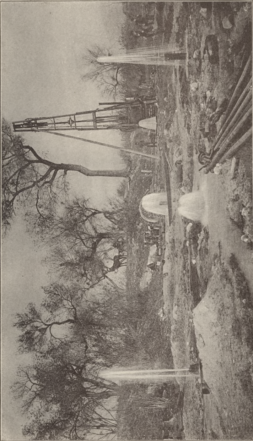
Riverside Californien. System artesischer Brunnen für Feldbewässerung.
