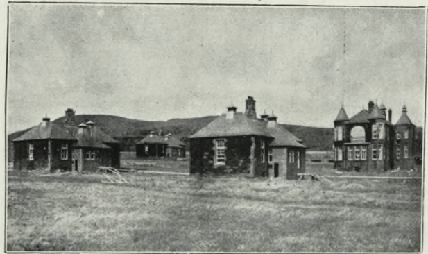
Figur 152. Ansicht des Isolier- und Beobachtungspavillons.
