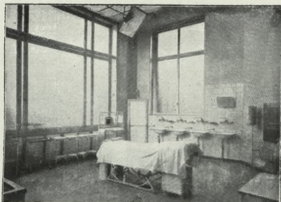
Figur 60. Innenansicht des aseptischen Operationssaales.
