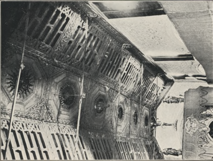
FIG. 49. CAMINHA. ROOF OF MATRIZ.
