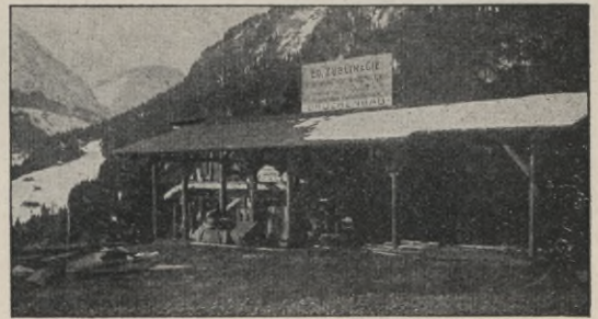
Fig. 28. Obere Bremsbergstation (Annahme auf der Poststraße).
