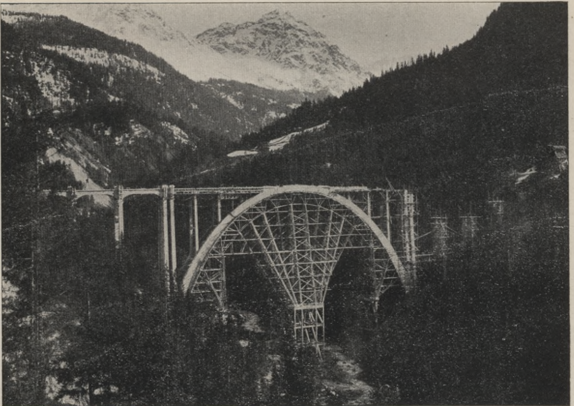
Fig. 77. Herstellung des Fahrbahnaufbaues über dem Bogen und den Pfeilern der Nebenöffnungen auf Aroser Seite. Blick taleinwärts (gegen Arosa). Bauzustand im Frühjahr 1914.
