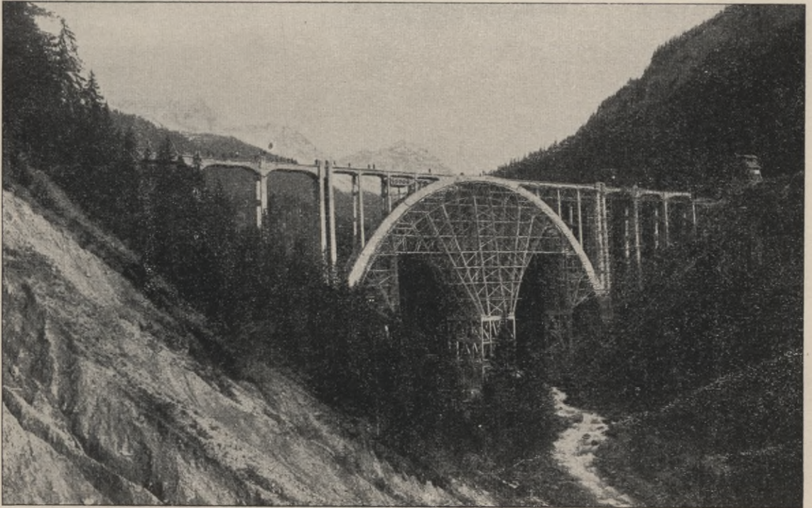
Fig. 78 a und b. Herstellung der Fahrbahn der Nebenöffnungen auf Aroser Seite. Blick taleinwärts (gegen Arosa). Bauzustand im Sommer 1914.
