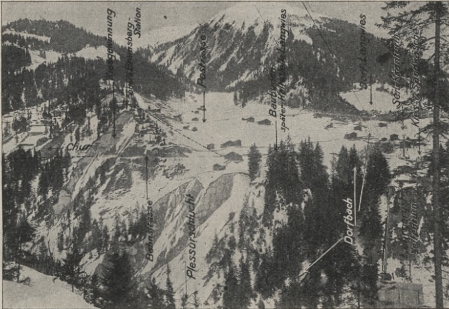
Fig. 26. Ansicht der rechten Talseite bei der Brückenstelle mit Anordnung der Baueinrichtungen. Bauzustand am 15. Februar 1913.
