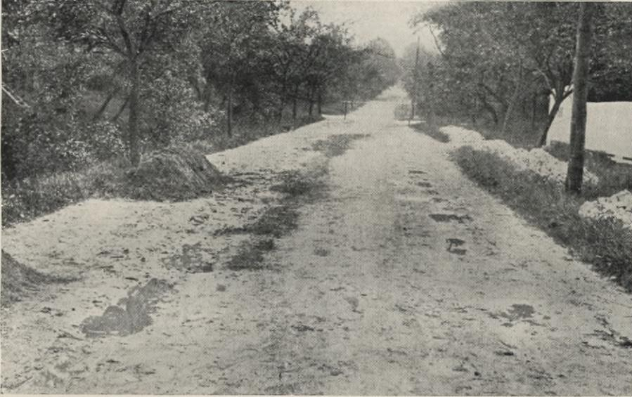
Abb. 7. Alte, abgeschlammte, noch nicht aufgelockerte und regulierte Steinschlagdecke.
