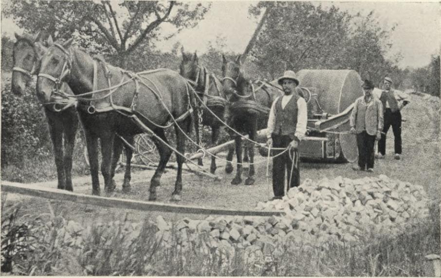
Abb. 9. Abwalzen der regulierten Steinschlagdecke vor Aufbringung der Zwischenlage.
