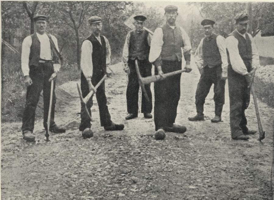
Abb. 8. Mittelfst Spitzhacke aufgelockerte Steinschlagdecke.
