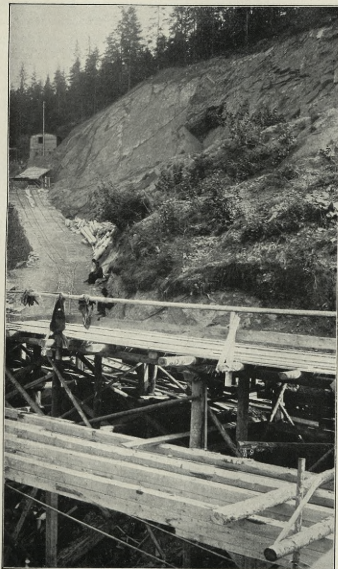
Fig. 104. Die Bremsberg-Steinförderung. 3. und 4. Bauabschnitt.
