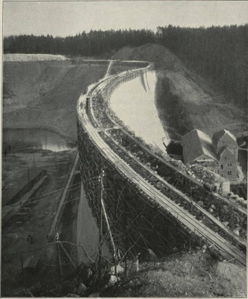
Fig. 124. Das Betriebsgerüst der Wasserseite.
