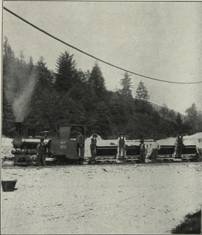
Fig. 150. Die Feldbahn für den Sandtransport.
