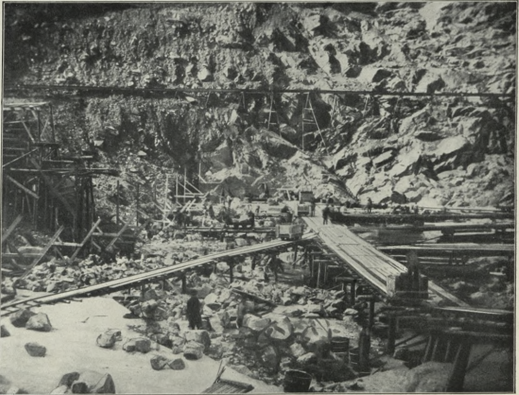
Fig. 20. Die Staumauer. Beginn der Maurerarbeiten am 5. April 1909.
