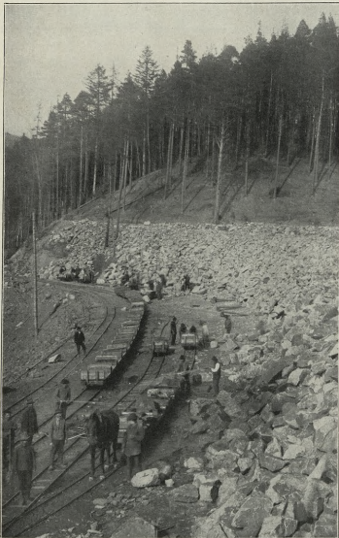
Fig. 100. Steinlagerplätze mit Wäschereien in Kronenhöhe der Staumauer, linke Lehne 1911/12.
