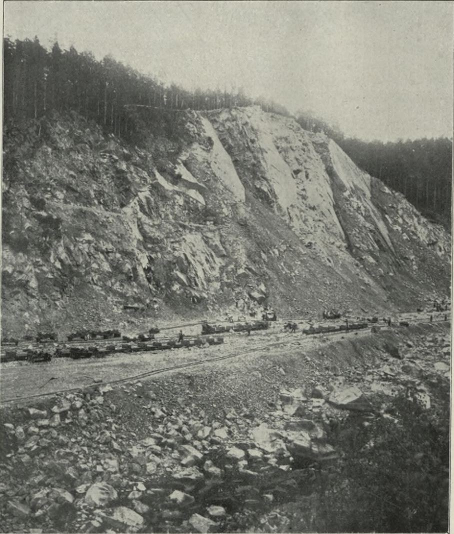
Fig. 90. Der Steinbruch am Rabenstein im Vollbetrieb. 1909/10.
