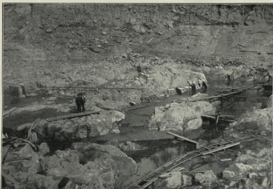
Fig. 15. Die Herrichtung der Fundamentsohle. Räumung und Reinigung der Felssohle des rechten Teiles der Baugrube.
