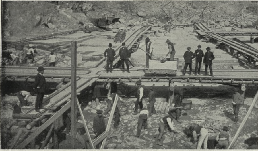
Fig. 18. Die Staumauer. Beginn der Maurerarbeiten am 5. April 1909. Rechter Teil.
