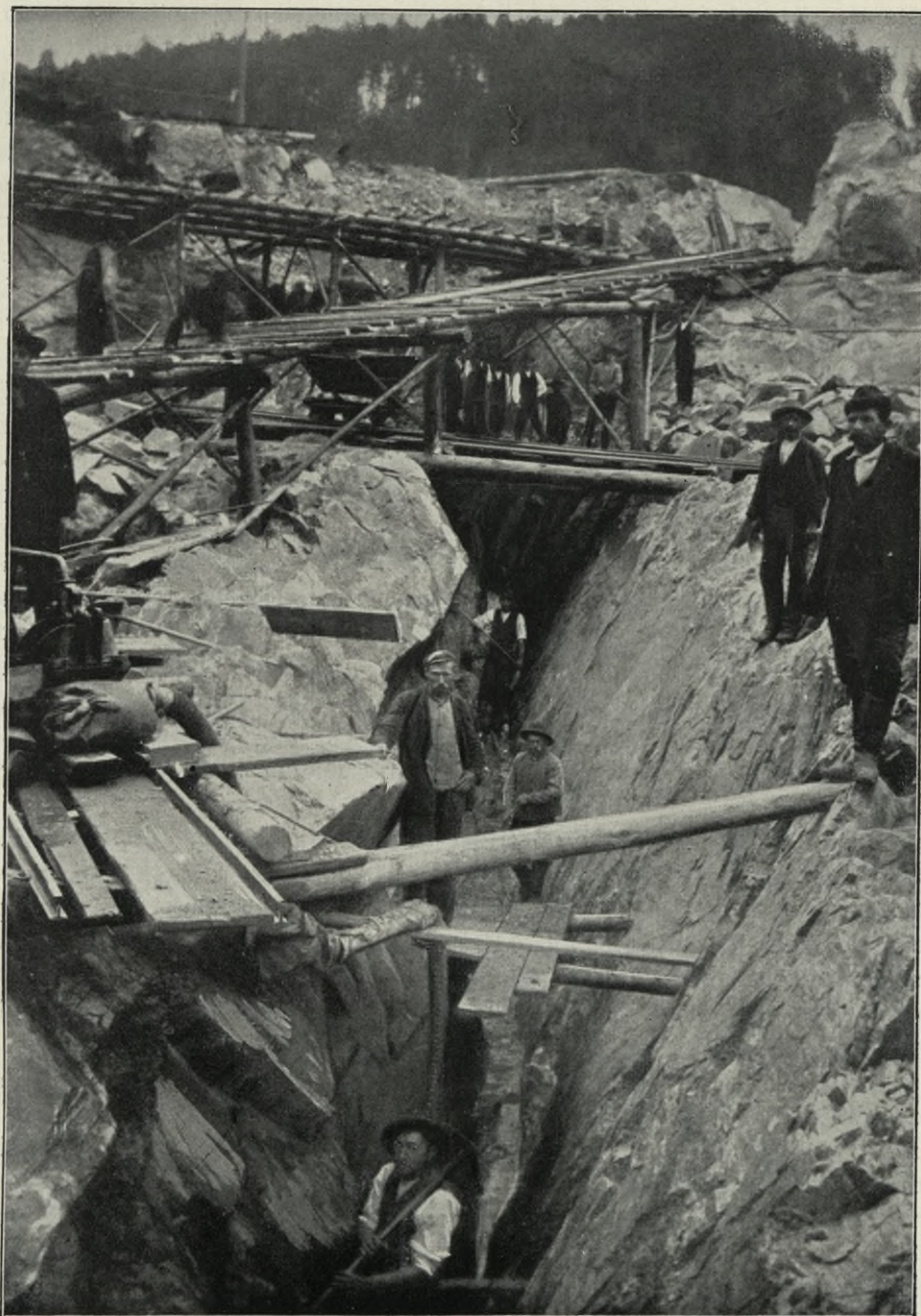
Fig. 13. Die Herrichtung der Fundamentsohle. Die Räumung von Diabas-Quergängen in der Baugrube der Staumauer. September/Oktober 1908.
