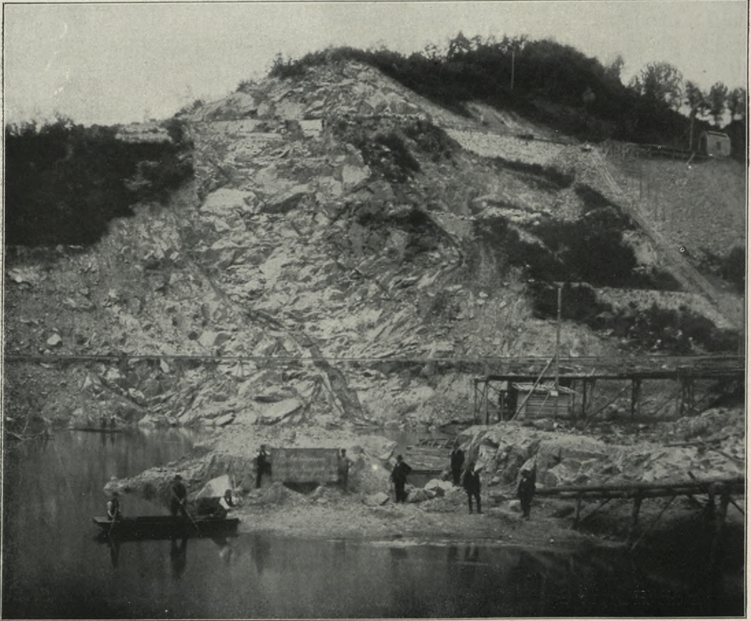
Fig. 17. Die Erd- und Felsarbeiten zur Freilegung der Baugrube der Sperrmauer. Überflutung der Baustelle durch den Einsturz des Holzbaus des Schieberschachtes in den Tunnel und Verstopfung des letzteren.
