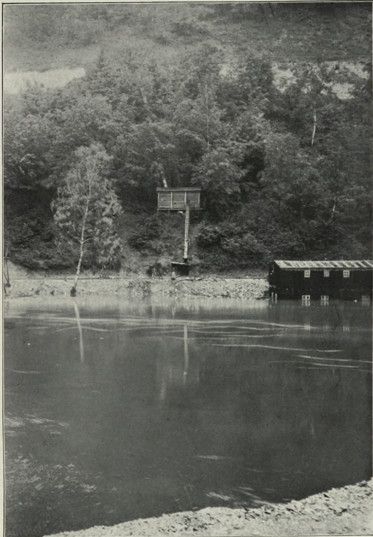
Fig. 22. Hochwasser am Bober am 2. Juli 1909. Partie oberhalb des Umleitungswehres.
