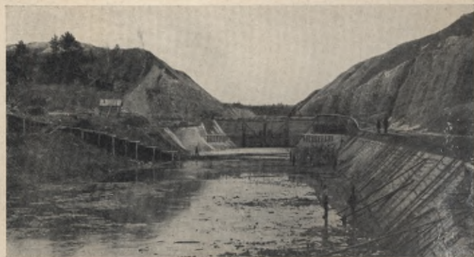
Tranchée au village Diéviatiny. Achèvement des travaux.
