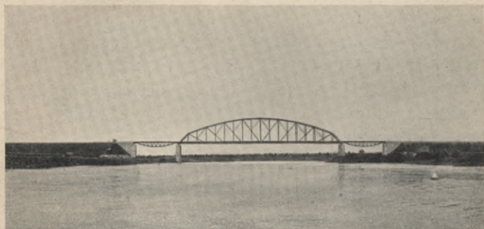
Pont de chemin de fer de la ligne S-Pétersbourg—Vologda, sur la riv. Cheksna.
