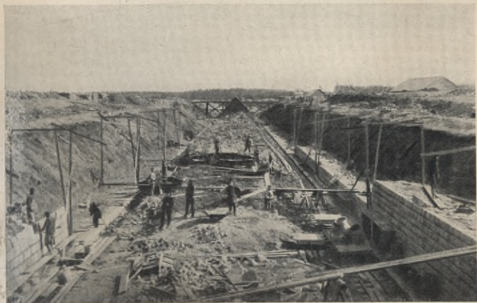
Construction d'une écluse en pierre sur la riv. Cheksna.
