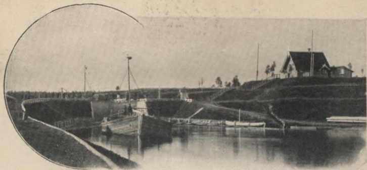
Ecluse S-t Alexandre dans le Nouveau Canal Marie. Station Téléphonique.
