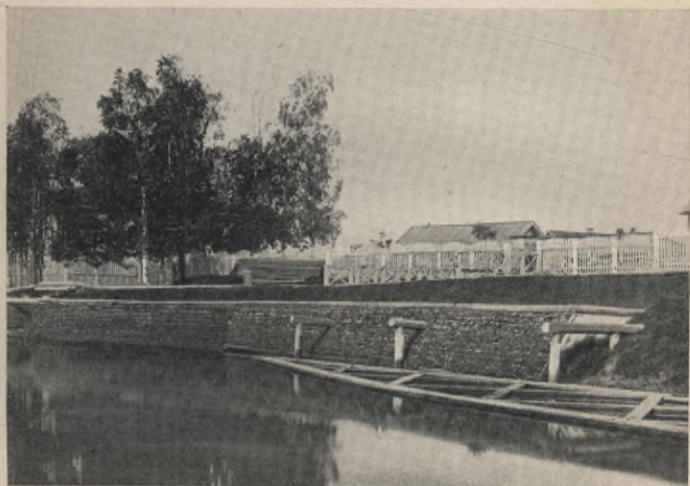
Type de soutènement de rives.
