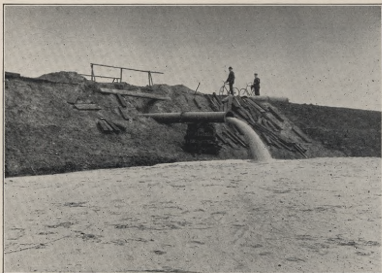
Saugspülbagger in Tätigkeit, Ausmündung des Spülrohrs mit Schüttkegel.
