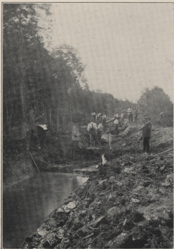
Gefangene bei Erd- und Rodungsarbeiten.
