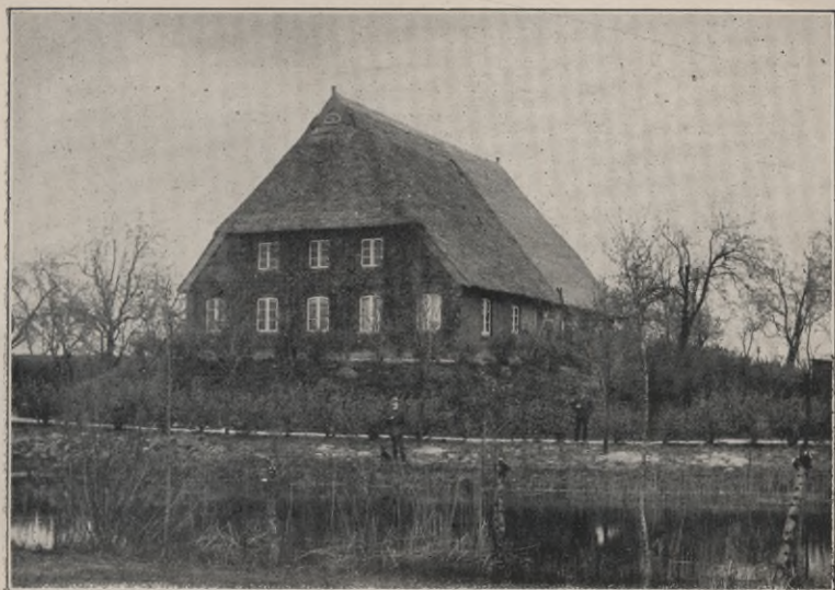
Haus auf hoher Wurt zu Laßrönne. Davor die alte Ilmenaumündung als Brack, das jetzt zugespritzt wird.
