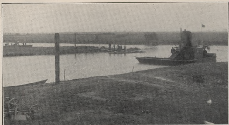
Baggerungen im Außentief der Pumpstation bei Laßrönne.
