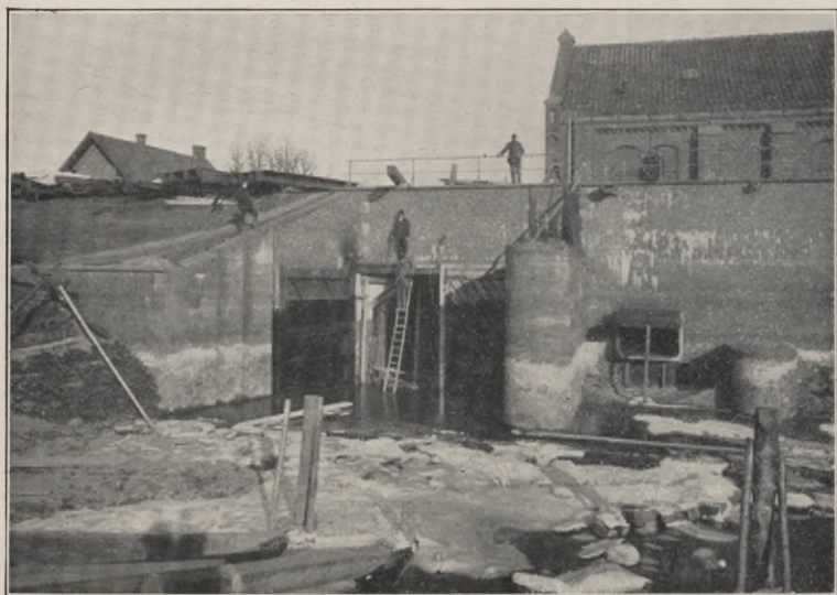
Instandsetzung des hölzernen Außentores. Auslauf des Kreisels.
