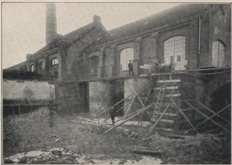
Trockengelegte Pumpstation binnen. Links neue Ufermauer. Einläufe der Pumpenkammern.
