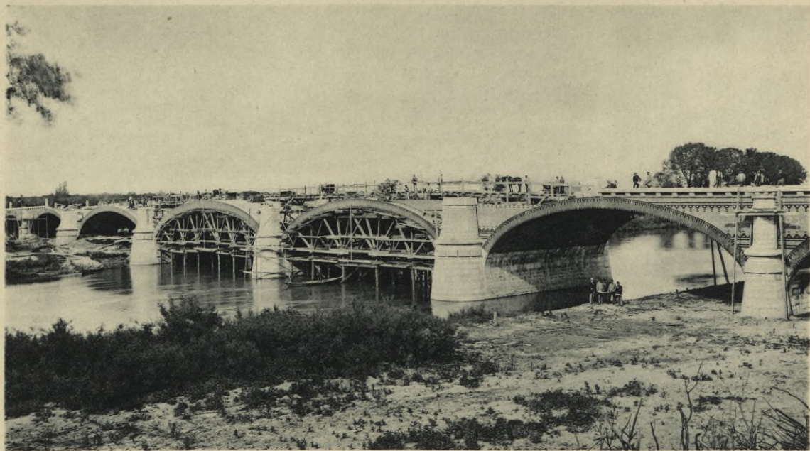
Breslau. Alte Oder. Gröschelbrücke im Bau.
