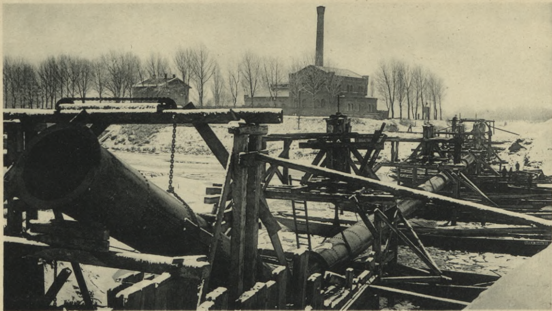
Breslau, Grossschiffahrtsweg, Verlegen des Dückers in der unteren alten Oder.
