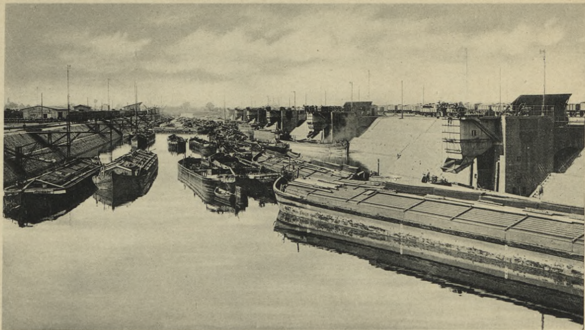
Kosel. Umschlaghafen im Betriebe.
