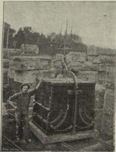
klappen angreifen, sind, wie aus den Fig. ersichtlich, durch ringförmige Blechstreifen geschlossen, welche sich mit den Bodenklappen bewegen. Um die Bodenklappen auch dann geschlossen zu halten, wenn der Kasten oben aufgestellt wird, also nicht an dem Bügel hängt, kann der Bügel in der hohen Stellung der Fig. 206 durch einen Stift, der in Fig. 207 hängend dargestellt ist, in der oberen Führungshülse festgestellt werden.
