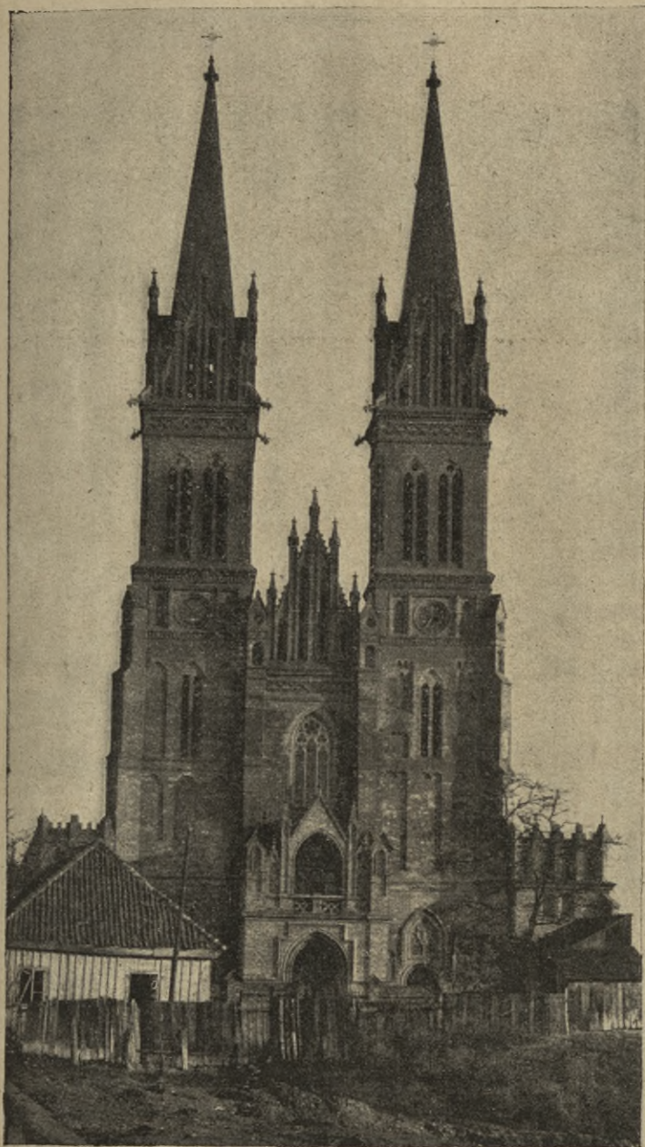
Katedra kujawska (włocławska) po przebudowaniu.
