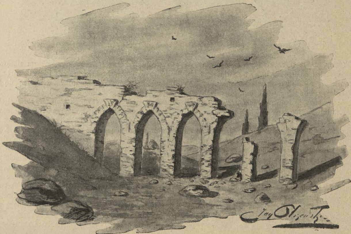
Ruiny mostu, łączącego zamek z kościołem, w Będzinie.
