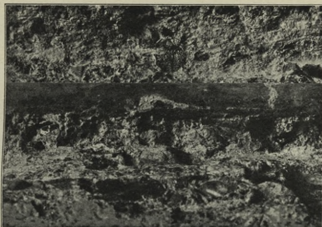
Abb. 283. Freigelegtes äußeres Eisen der Platte 85 bei Riß 10. Der festgestellte Rostansatz der Stärke 2 befindet sich etwa 6 cm vom Riß 10 entfernt.
