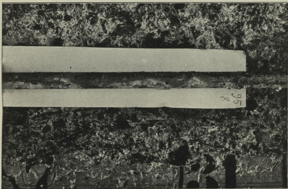
Abb. 284. Freigelegtes Eisen der Platte 95 zwischen Riß 7 und 30. Das mit Walzhaut eingebettete Eisen weist Rostansatz der Stärke 3 und 4 auf.
