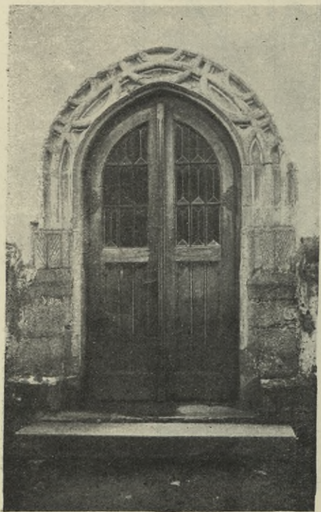
Obr. 44. Dolní Dvořiště. Farní kostel. Západní portál. — Église paroissiale. Portail occidental.
