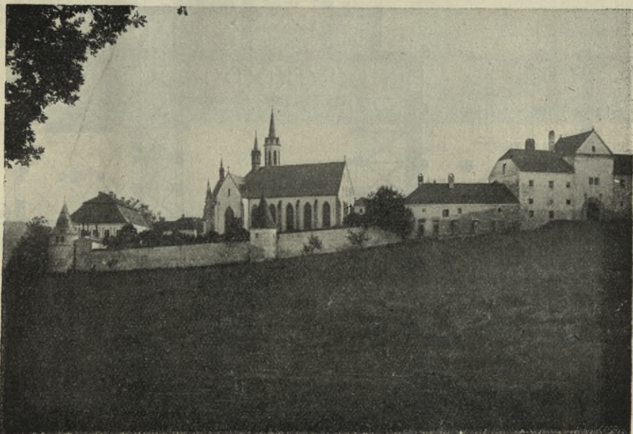
Obr. 357. Vyšší Brod. Pohled na klášter od severu. — Vue du monastère prise du nord.
