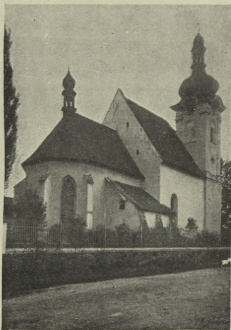
Obr. 72. Horní Dvořiště. Severní průčelí farního kostela. — Église paroissiale. Façade nord.
