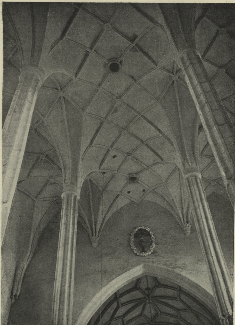
Obr. 55. Dolní Dvořiště. Pohled na klenby farního kostela. — Vue des travées de l'église paroissiale.
