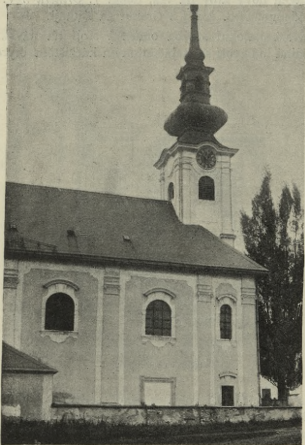
Obr. 231. Omlenička. Farní kostel. Pohled od severu. — Église paroissiale. Vue du nord.
