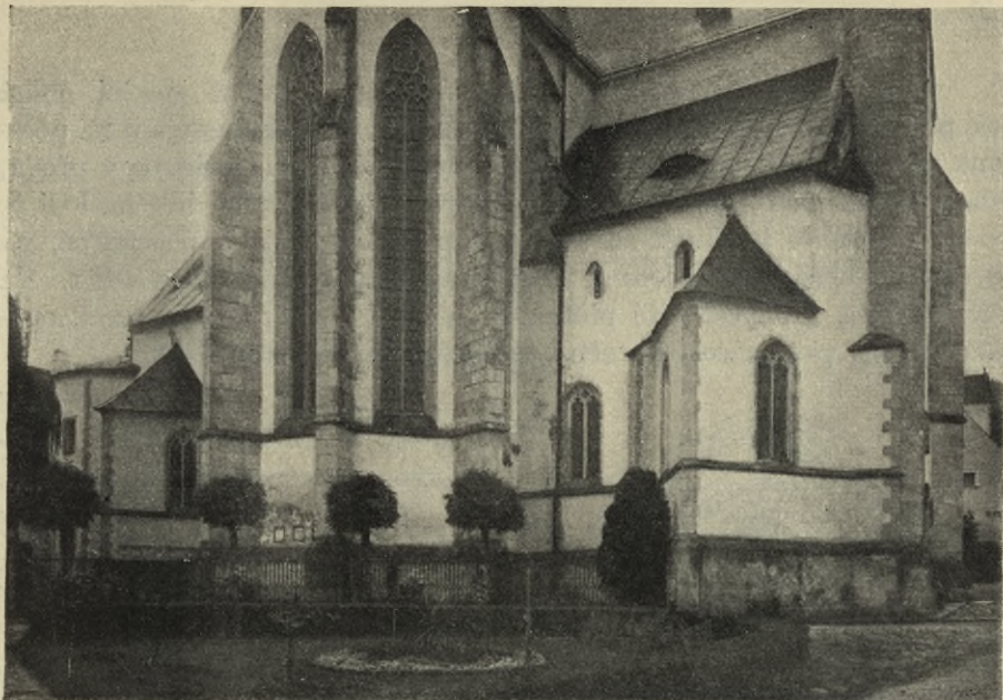
Obr. 359. Vyšší Brod. Východní průčelí klášterního kostela. — Façade sud de l'église collégiale.
