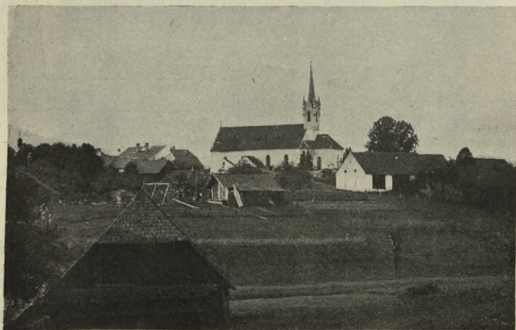
Obr. 347. Vyšší Brod. Pohled na farní kostel od jihu. — Vue de l'église paroissiale du sud.
