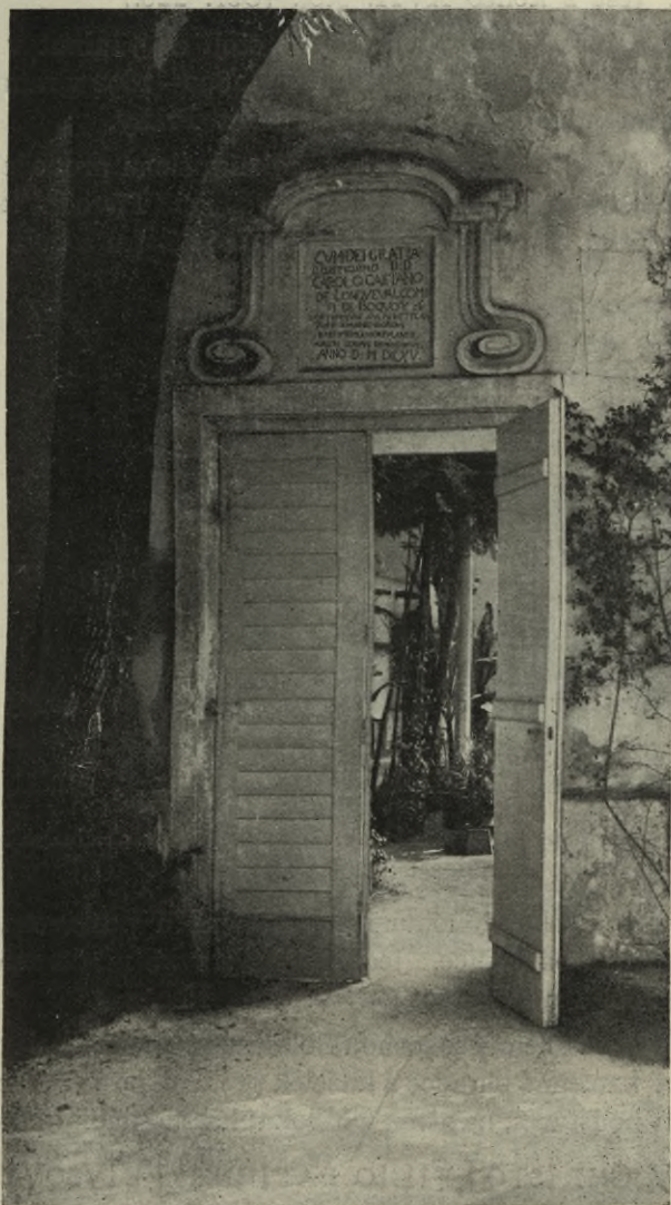
Obr. 225. Nové Hrady. Zámek. Vchod do skleníku. — Palais. Porte de la serre.
