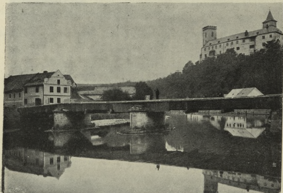
Obr. 288. Rožmberk. Most přes Vltavu a pohled na jižní průčelí hradu. — Pont sur la „Vltava“ et vue de la façade sud du château.
