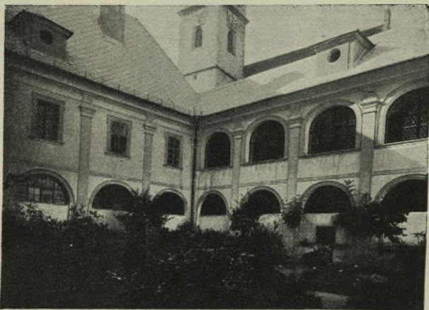
Obr. 191. Nové Hradce. Klášter Servitů. Dvůr klášterní. — Convent des Servites. Cloître.
