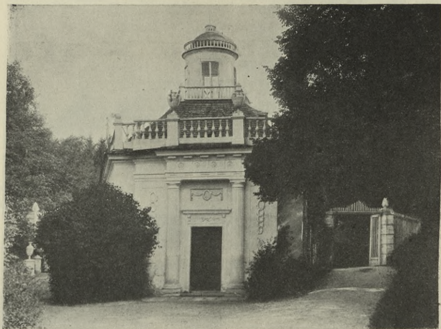
Obr. 338. Údolí. Tereziánské údolí. Zadní průčelí lázeňského domu. — Vallée de Thérèse. Façade posté- rieure du bain.
