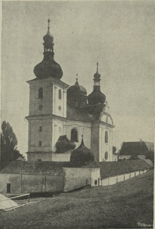
Obr. 28. Dobrá Voda. Zadní průčelí poutního a farního kostela. — Façade postérieure de l'église paroissiale de pèlerinage.
