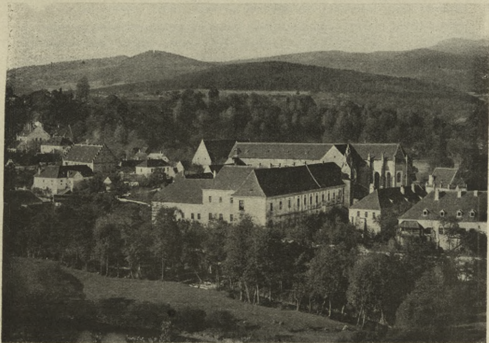
Obr. 141. Zlatá Koruna. Celkový pohled od východu.
