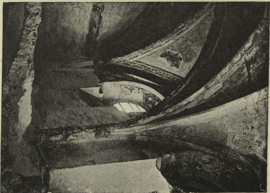
Obr. 215. Zlatá Koruna. Z posledních oprav kaple Andělů Strážných.
