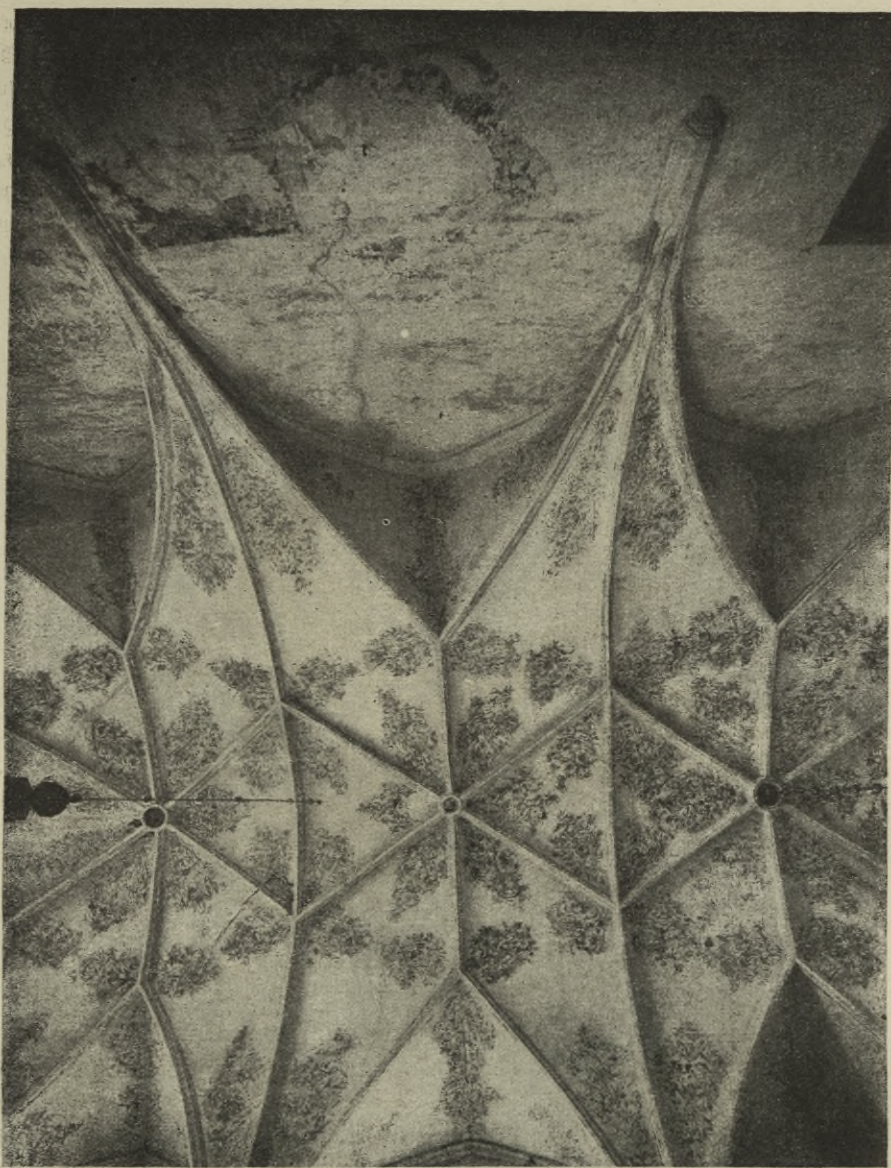
Obr. 89. Kájov. Kostel: odkryté malby klenbové v presbytáři.
