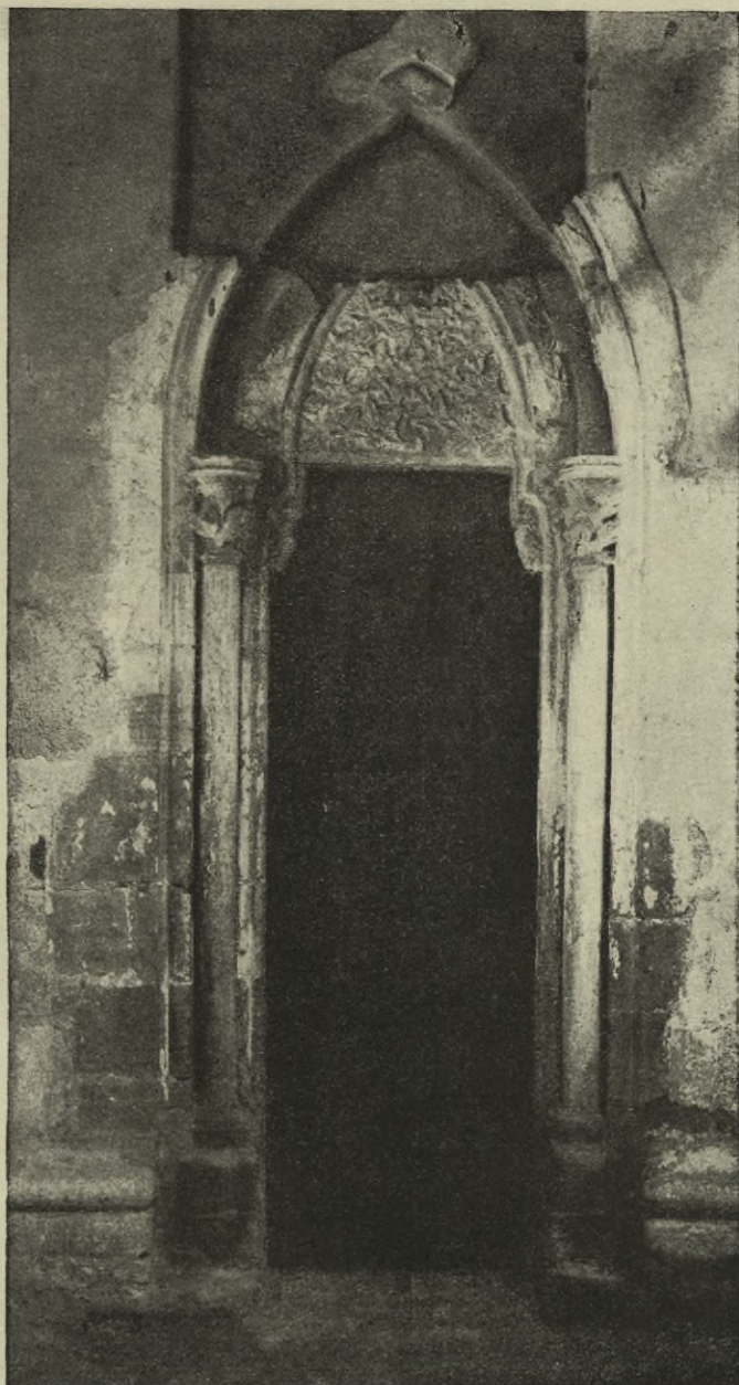
Obr. 206. Zlatá Koruna. Portál kaple Andělů Strážných.
