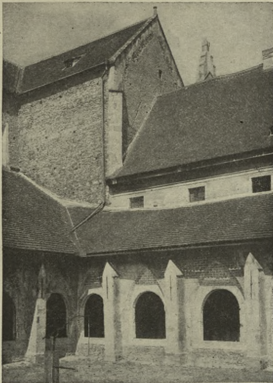
Obr. 178. Zlatá Koruna. Severozápadní část křížové chodby z rajske zahrady po opravě.
