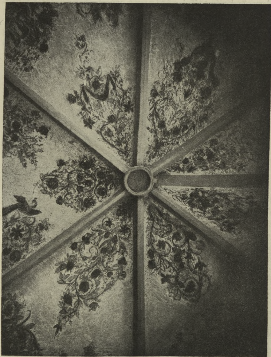
Obr. 91. Kájov. Malby klenbové v presbytáři.
