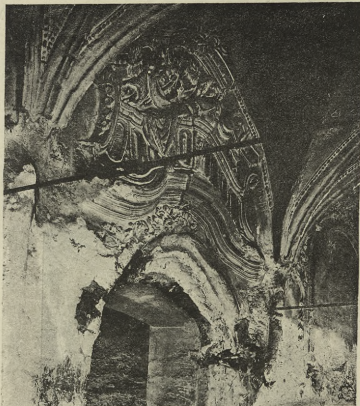
Obr. 179. Zlatá Koruna. Štuková výplň nad vchodem do refektáře.
