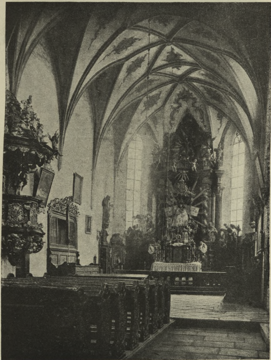
Obr. 99. Kájov. Kostel: presbytář před opravou.
