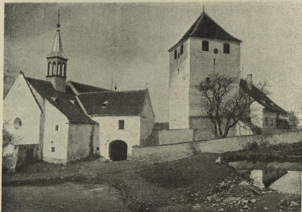
Obr. 301. Slavkov. Kostel od severovýchodu před poslední přestavbou.
