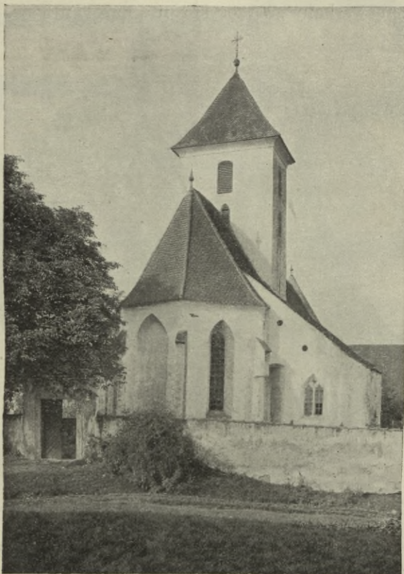
Obr. 27. Černice. Kostel od východu.
