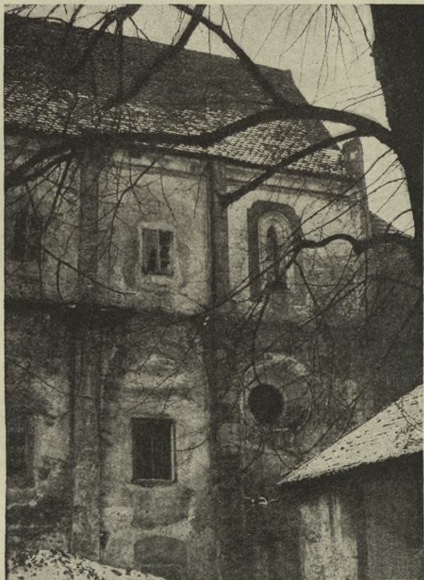
Obr. 210. Zlatá Koruna. Z posledních oprav kaple Andělů Strážných.
