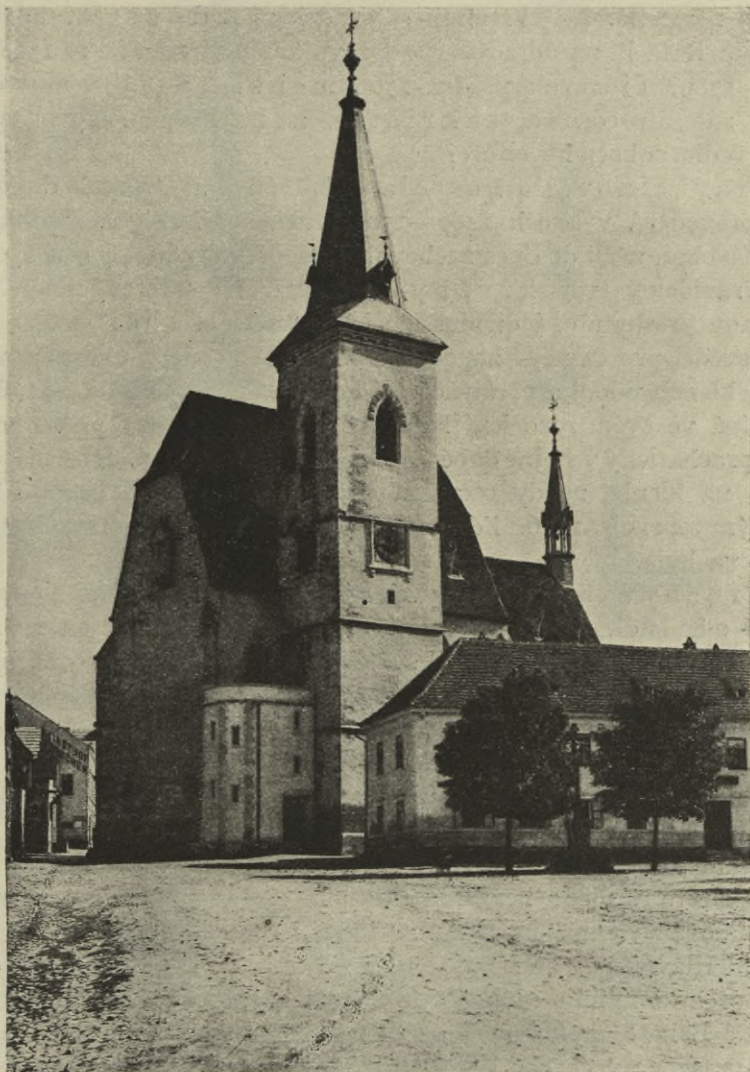
Obr. 67. Chvalšín. Kostel, pohled od jihozápadu.
