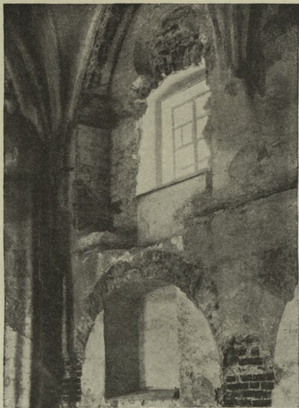
Obr. 213. Zlatá Koruna. Z posledních oprav kaple Andělů Strážných.
