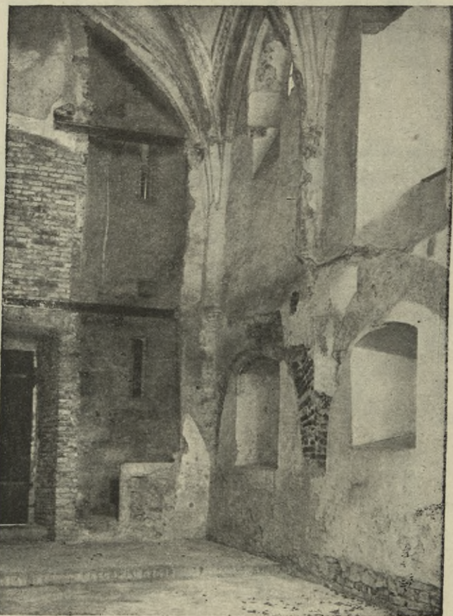
Obr. 205. Zlatá Koruňa. Odkryté původní schodiště do 2. patra kaple Andělů Strážných.
