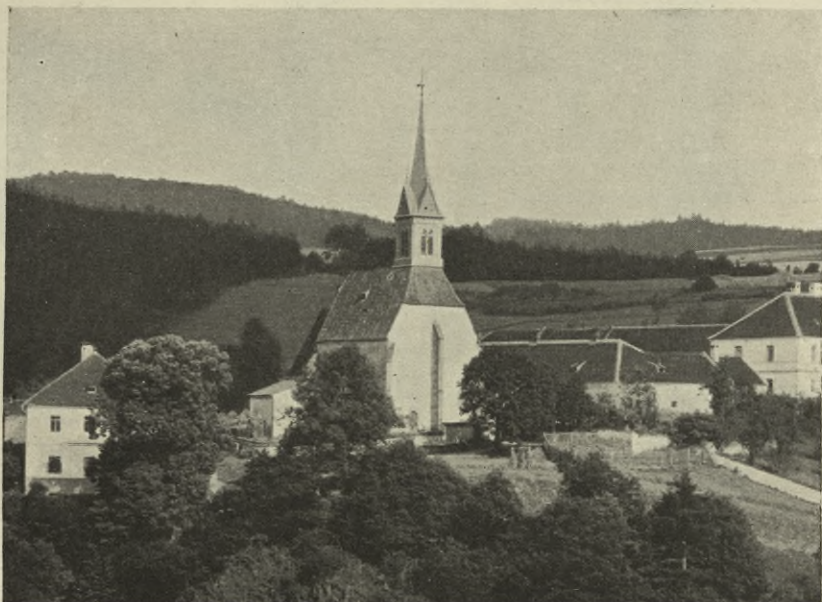
Obr. 369. Zatoň. Kostel se školou a farou od severozápadu.
