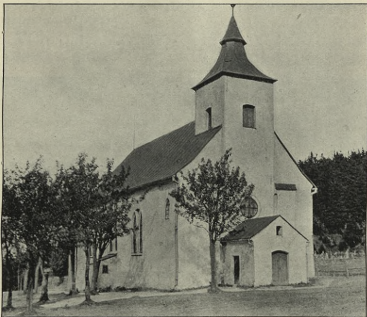
Obr. 115. Seifen. Farní kostel. Pohled od jihozápadu.
