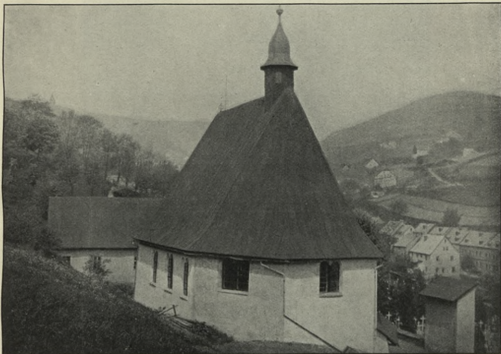
Obr. 42. Jáchymov. Špitální kostel. Pohled od jihu.
