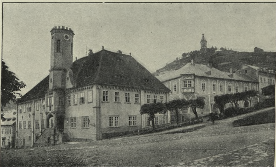
Obr. 71. Jáchymov. Radnice. Stav před přestavbou r. 1902.
