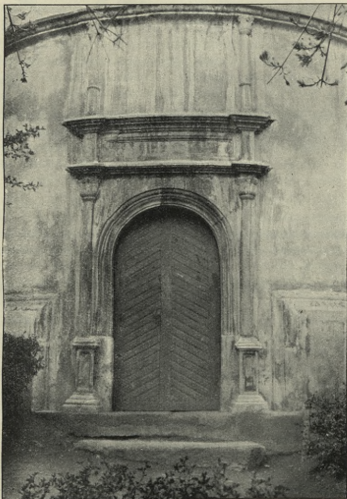
Obr. 36. Jáchymov, Děk. kostel. Portál do věže.
