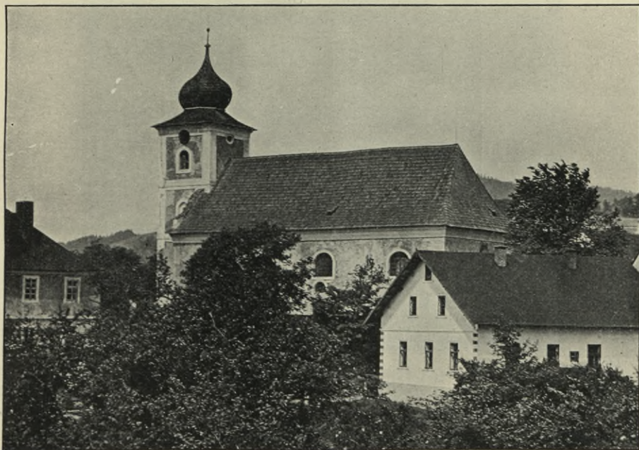
Obr. 105. Schönwald. Farní kostel. Pohled od východu.
