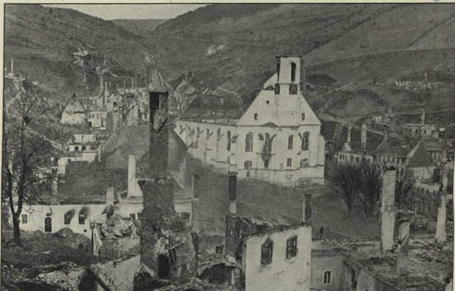
Obr. 31. Jáchymov. Děk. kostel po požáru 1873.
