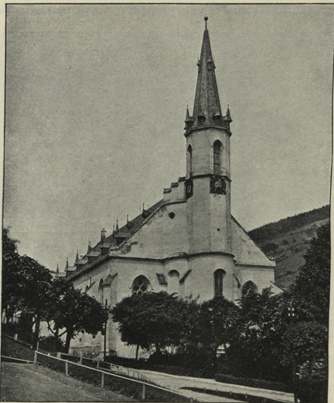
Obr. 33. Jáchymov. Děk. kostel. Pohled od jihozápadu. Detail.
