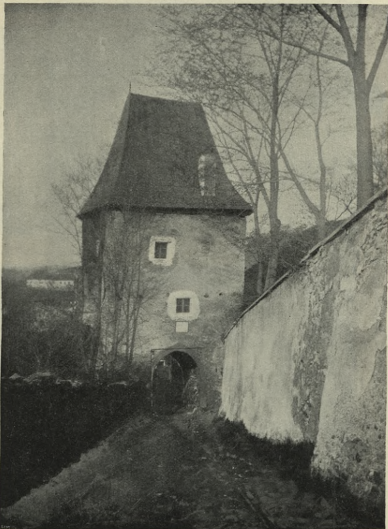
Obr. 339. Vimperk. Městská brána pod hradem.
