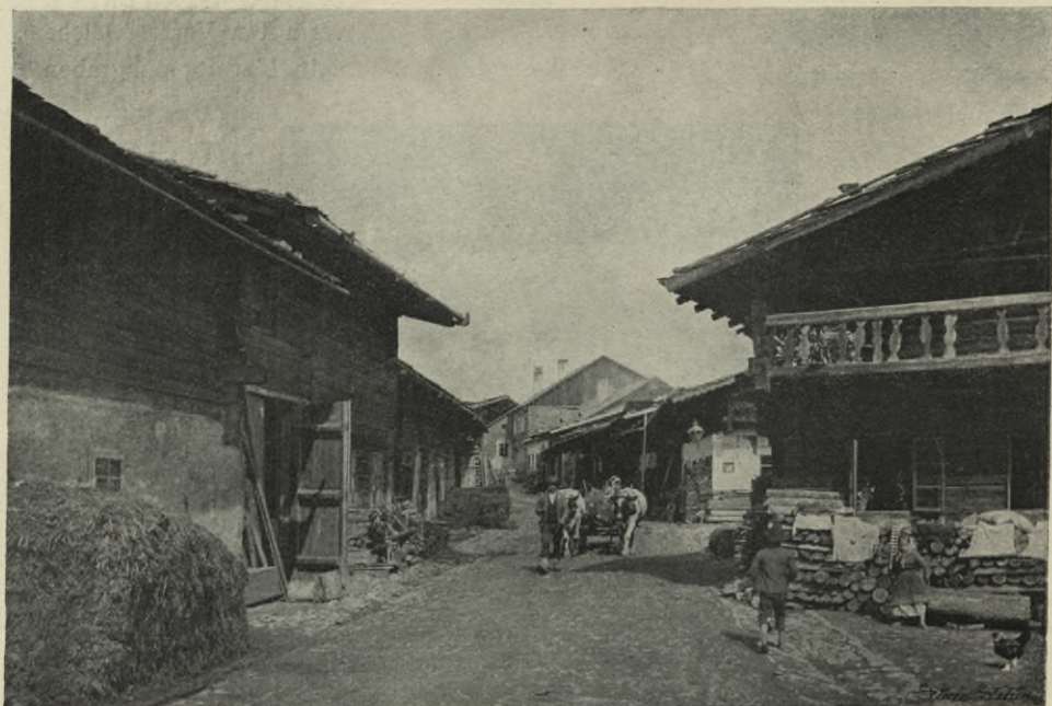
Obr. 397. Volary. Dřevěné stavby v Lichtavské ulici.
