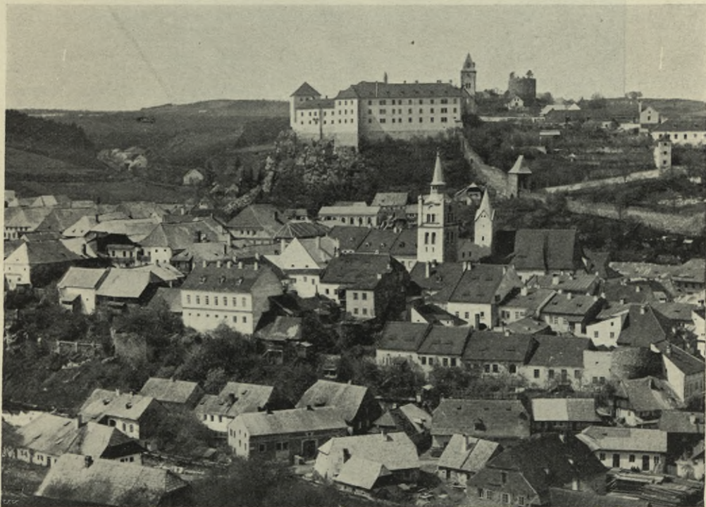
Obr. 335. Vimperk před požárem 1904.
