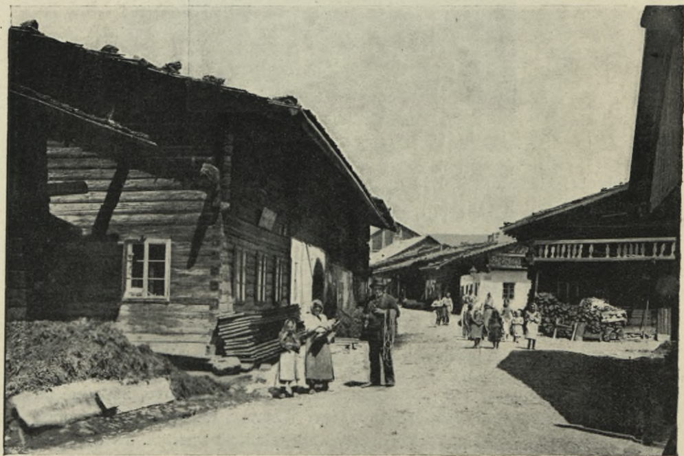
Obr. 398. Volary. Dřevěné stavby v Lichtavské ulici.
