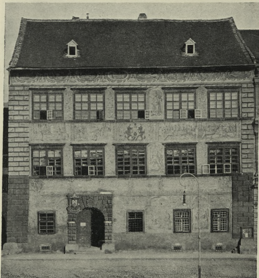
Obr. 266. Prachatice. Stará radnice po opravě.
