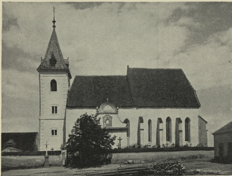
Obr. 145. Němčice. Kostel. Jižní pohled.
