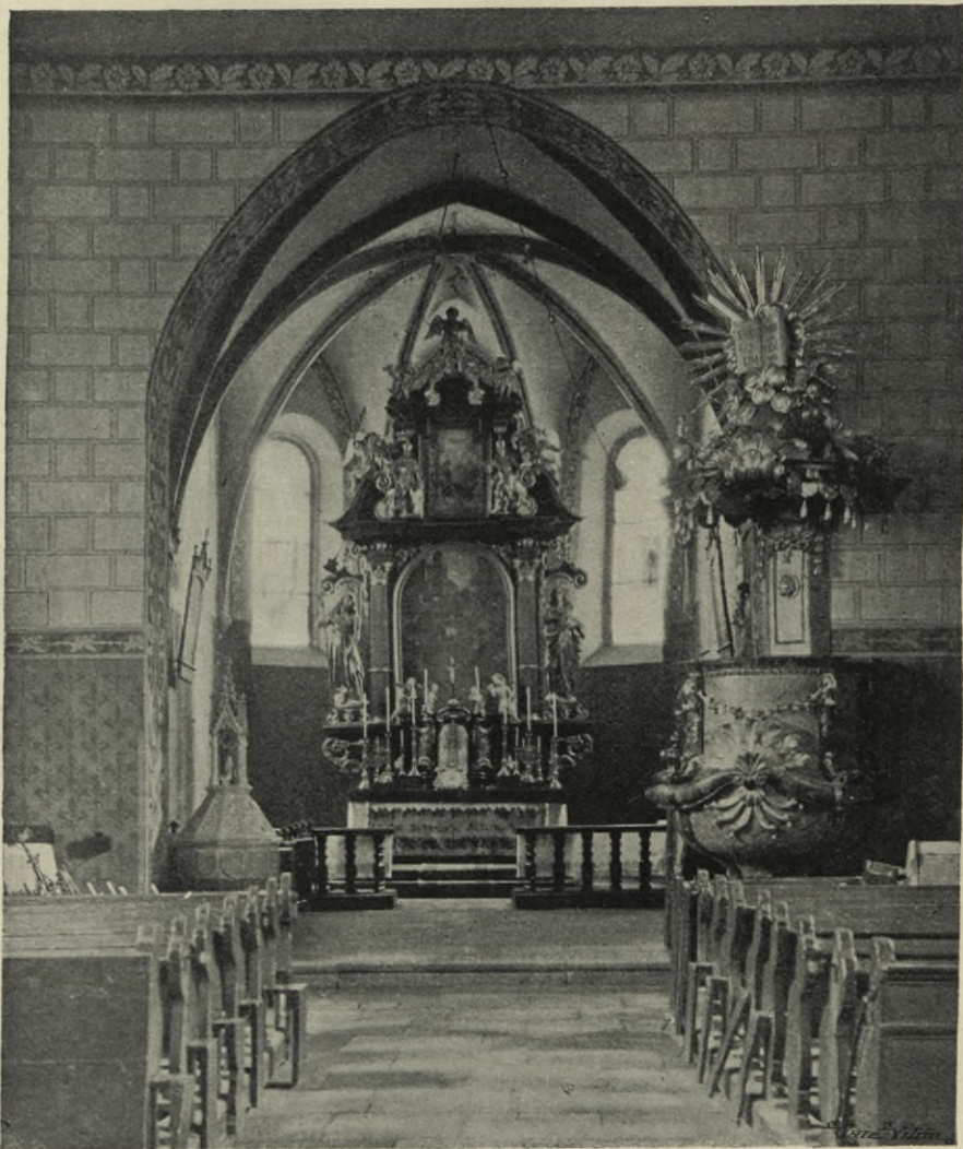
Obr. 413. Zbitiny, Kostel: pohled vnitřní.
