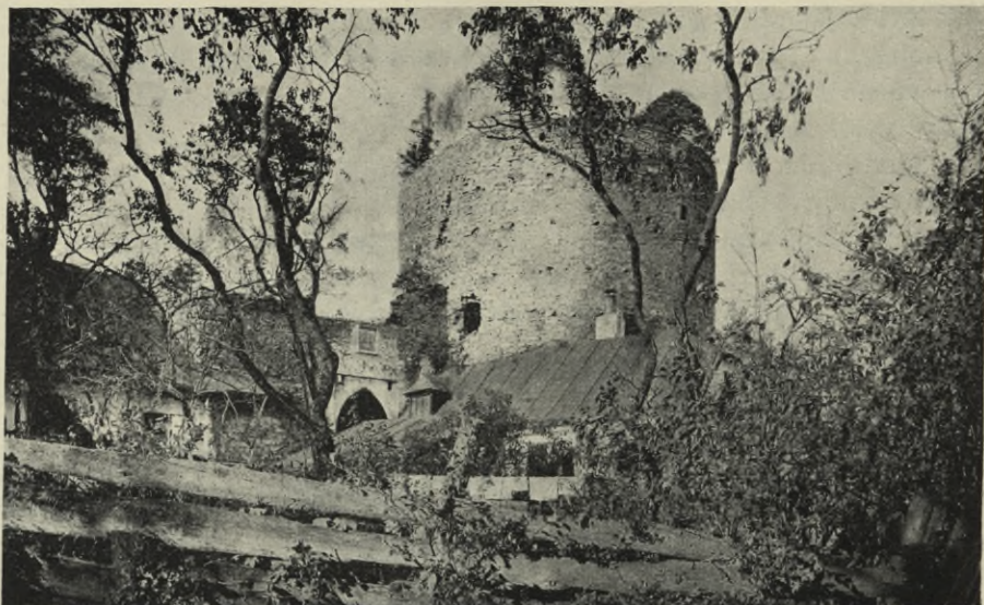
Obr. 374. Vimperk. Zámek. Bašta Hrádek-Haselburg.
