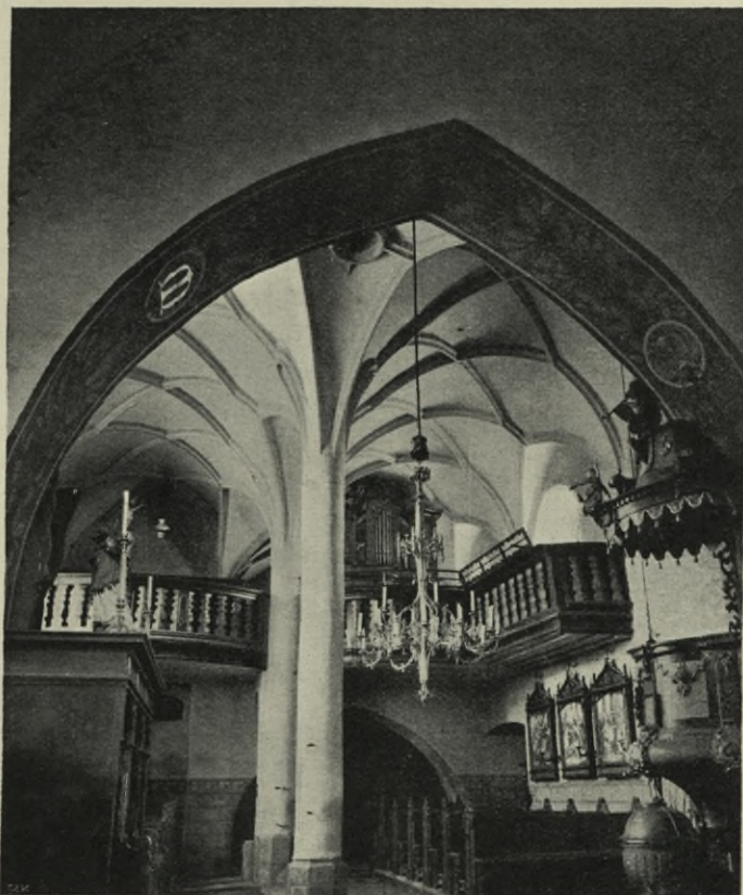
Obr. 406. Záblatí. Kostel. Pohled do lodi.
