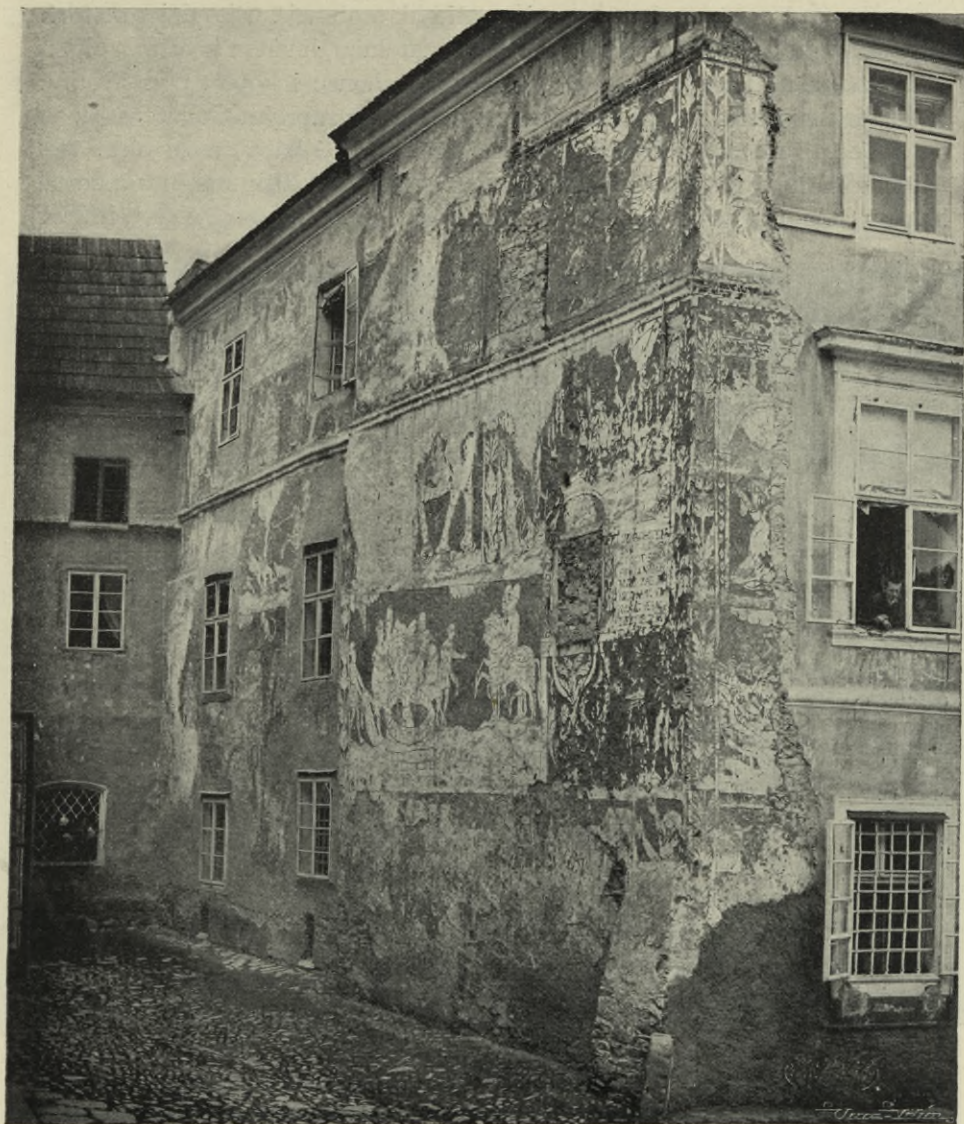
Obr. 28r. Prachatice. Knížecí Schwarzenberský dům č. 169 po opravě.
