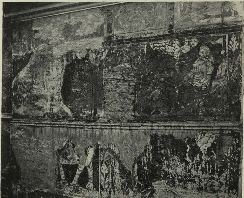
Obr. 284. Prachatice. Knižecí Schwarzenberský dům č. 169 po opravě.
