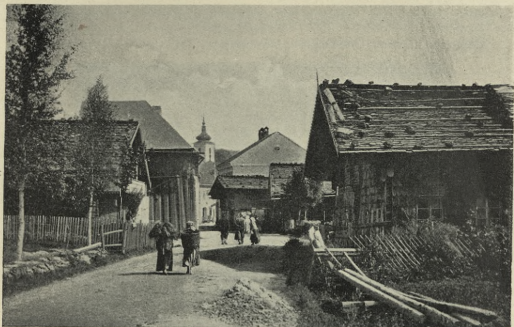
Obr. 399. Volary. Dřevěné stavby v Nádražní ulici.
