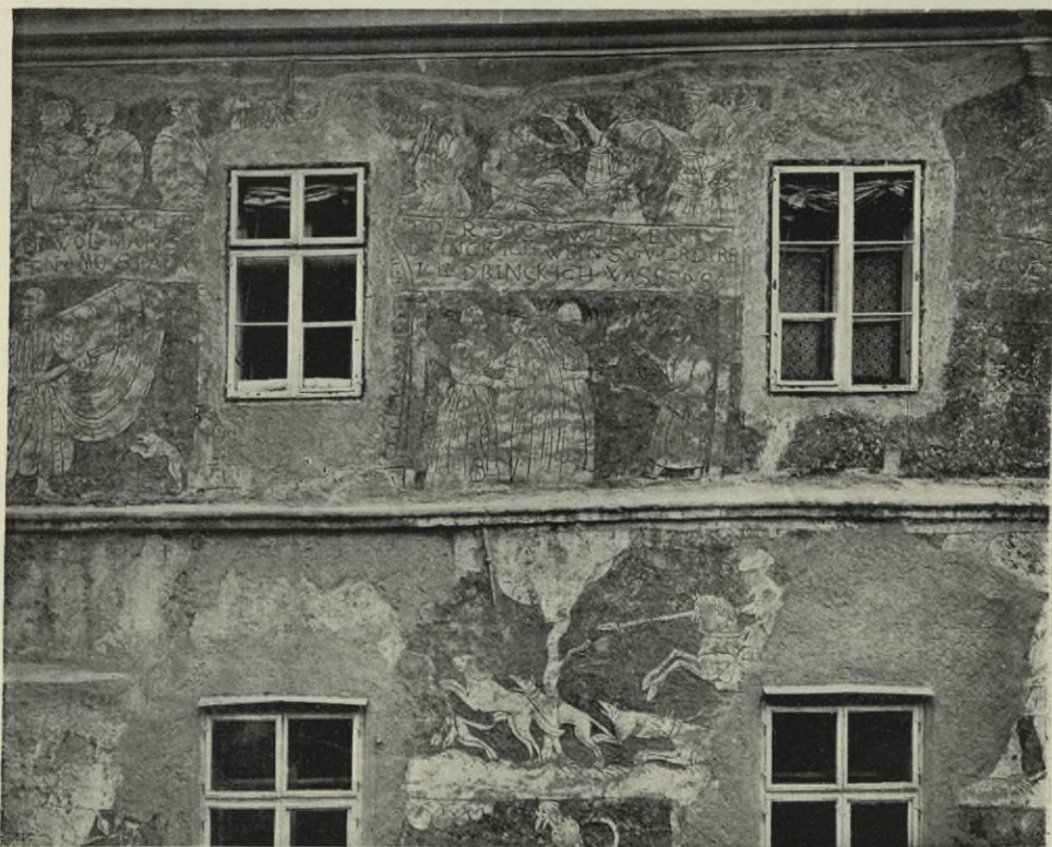
Obr. 282. Prachatice. Knížecí Schwarzenberský dům 169 po opravě.
