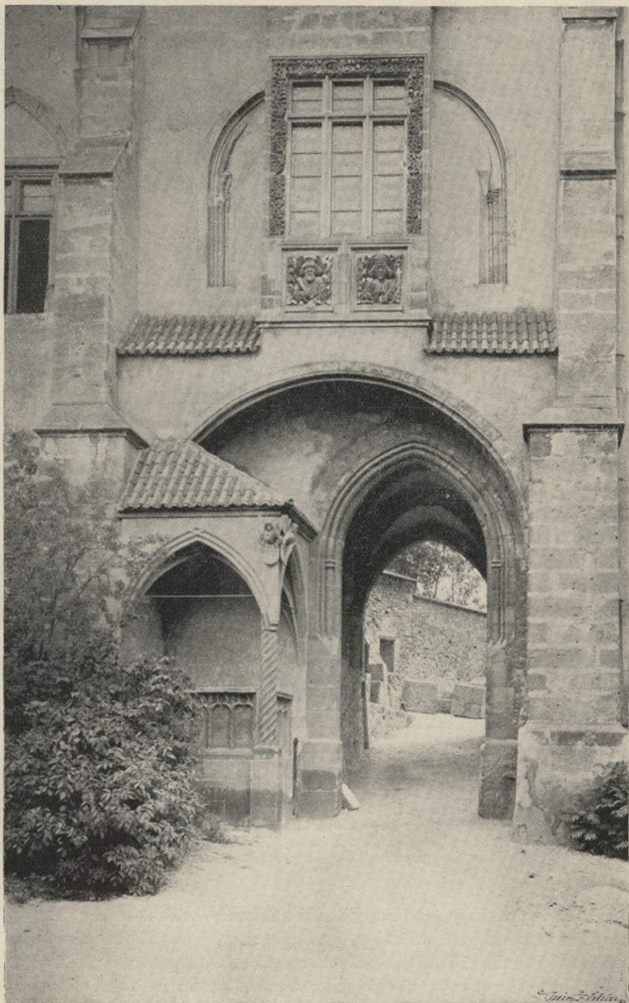
Obr. 27. Detail průčelí hradu s přízemní loggií, obloukem průjezdu do zadního dvora a arkýřem. 4
