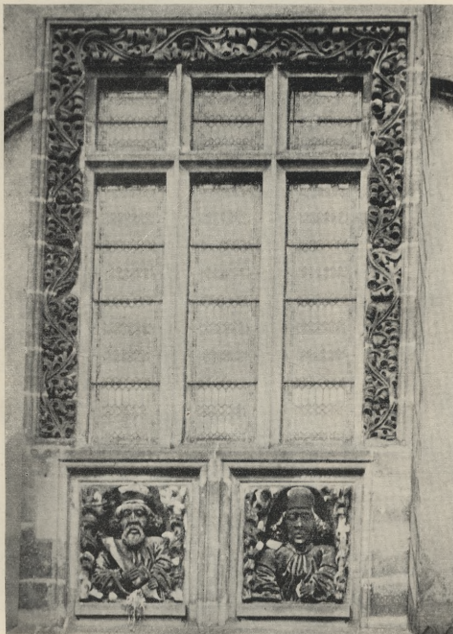
Obr. 31. Okno arkýře v I. patře paláce.
