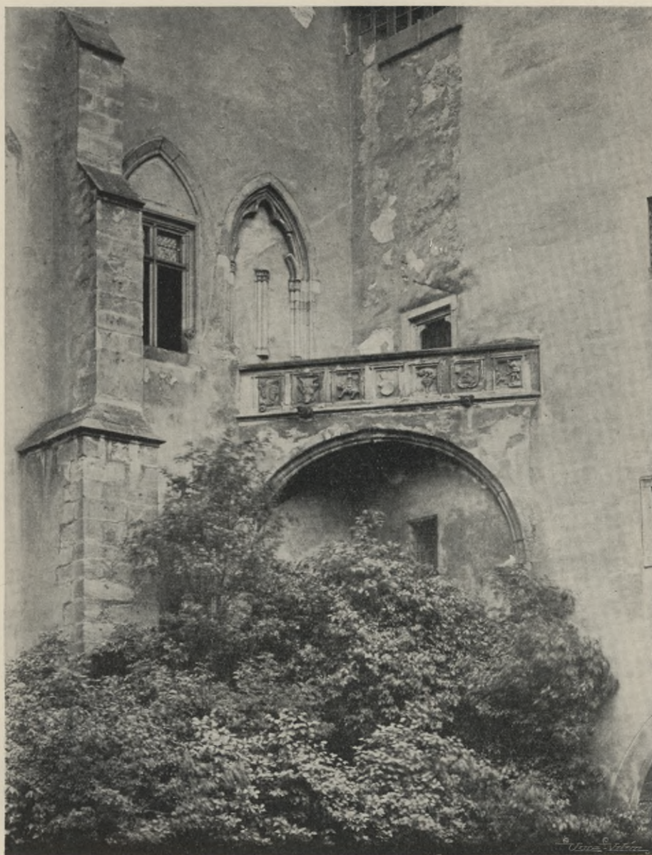
Obr. 17. Přejechod mezi věží vstupní a palácem v I. hradním dvoře.
