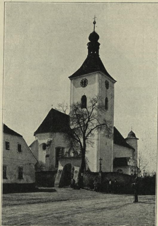
Obr. 85. Domašín, Farní kostel. Pohled.
