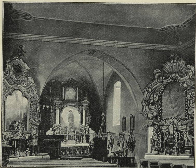
Obr. 334. Radošovice, Vnitřek kostela.
