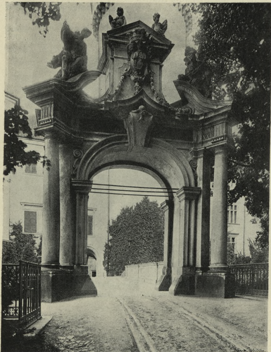
Obr. 167. Konopiště. Brána před mostem.
