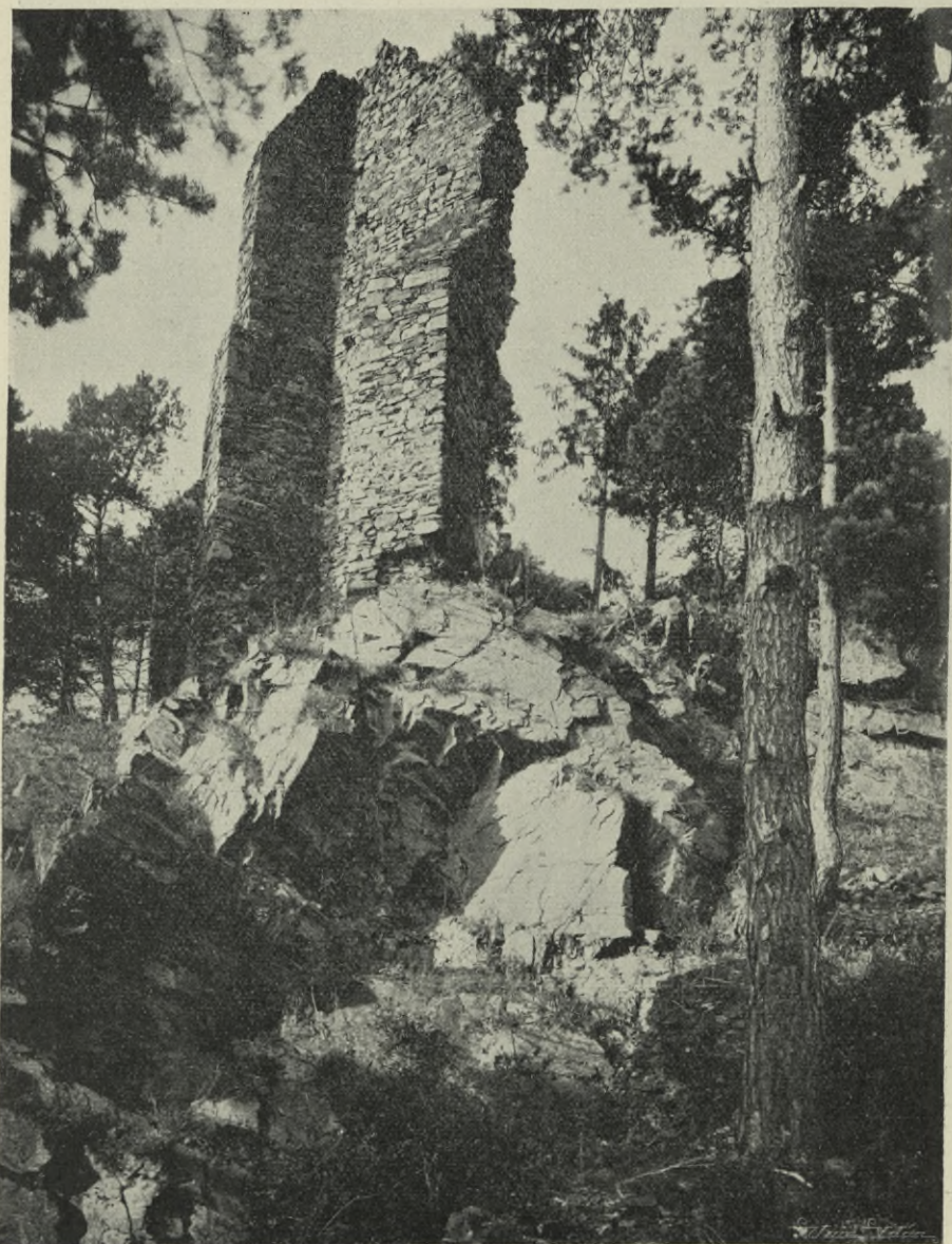
Obr. 185. Kostelec, Zbytek zdiva na straně západní.
