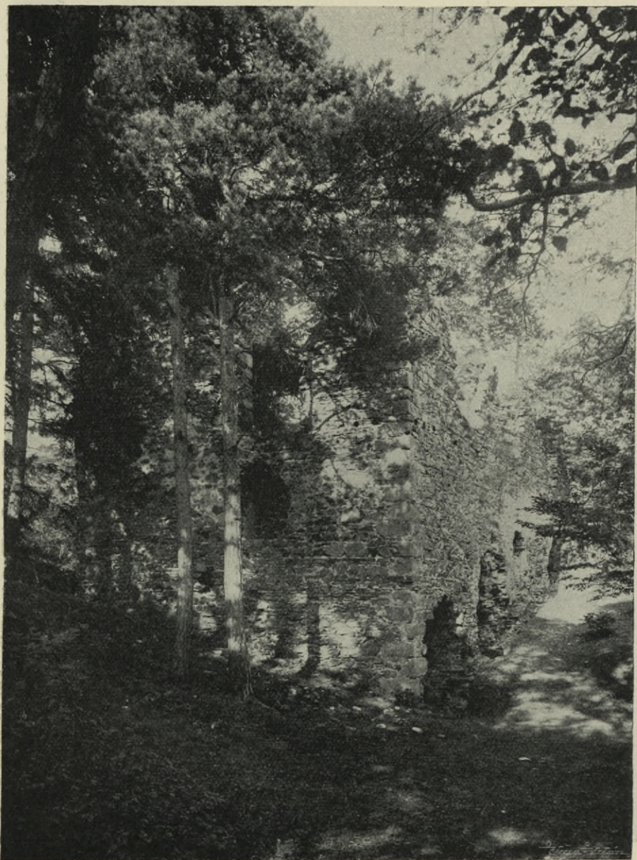
Obr. 184. Kostelec, Vnitřní budova hradní.
