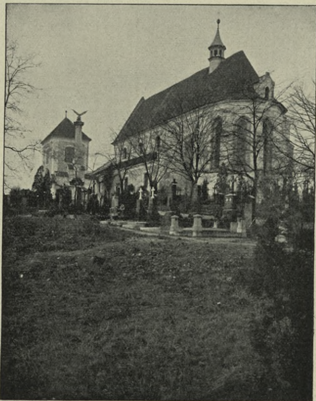
Obr. 30. Benešov. Děkanský kostel. Pohled od jihovýchodu.
