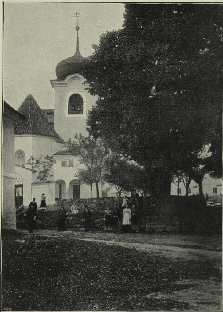
Obr. 322. Postupice. Kostel. Pohled od východu.
