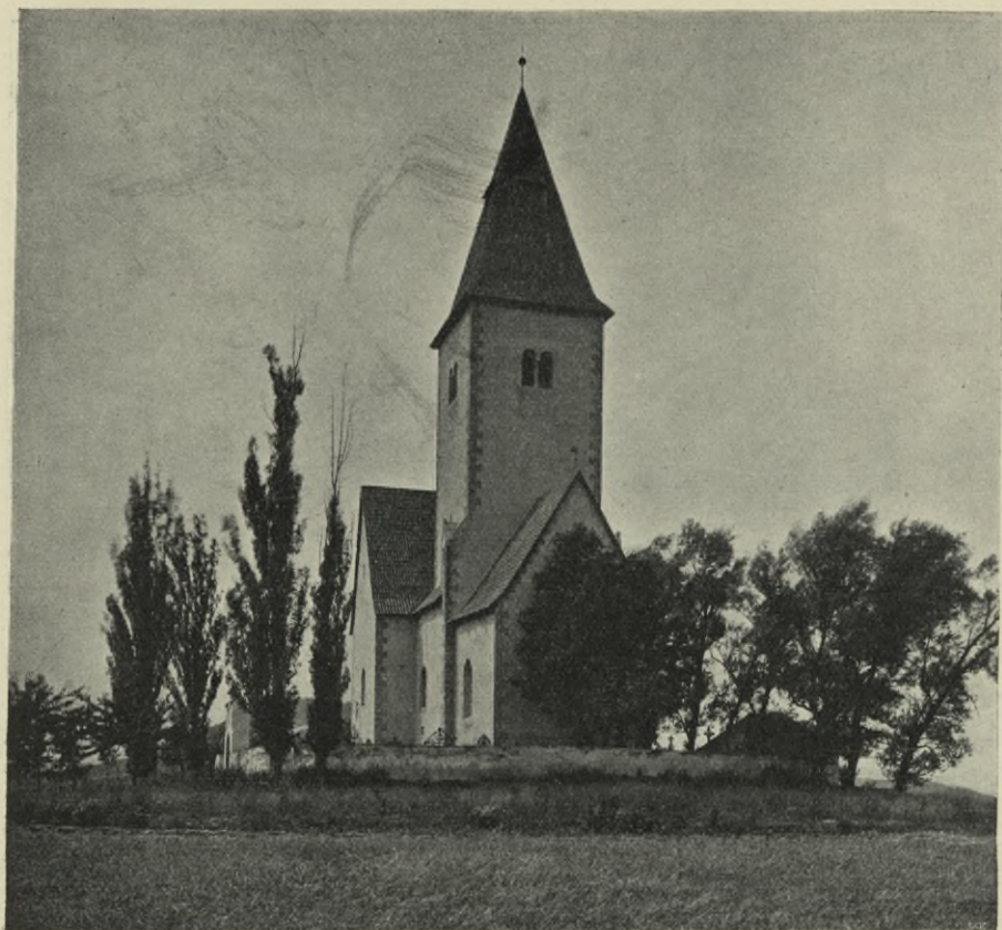
Obr. 122. Chvojno. Pohled na kostel.
