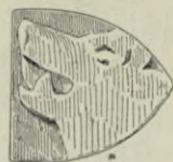
Obr. 248. Načeradec. Svorník v severní zdi kaple zazděné.
