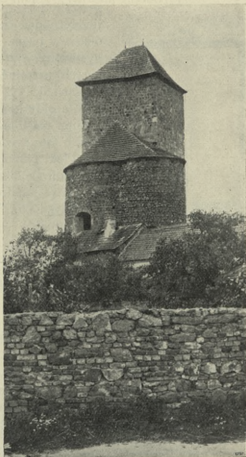
Obr. 368. Týnec nad Sázavou. Rotunda románská a zbytek bývalého hradu. Pohled se strany jihovýchodní.
