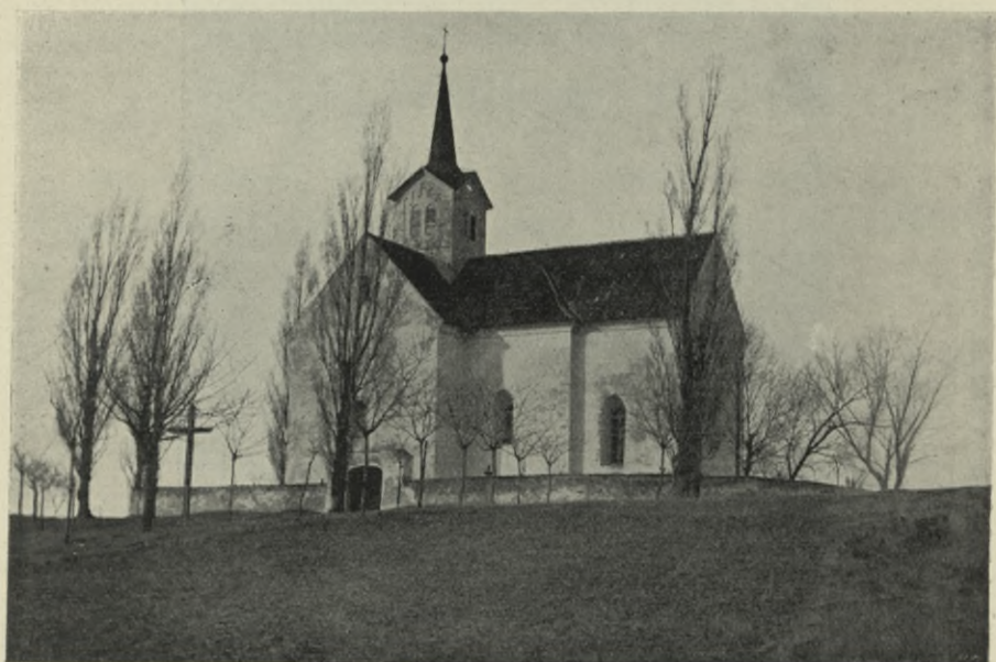
Obr. 121. Chvojno, Kostel před opravou.
