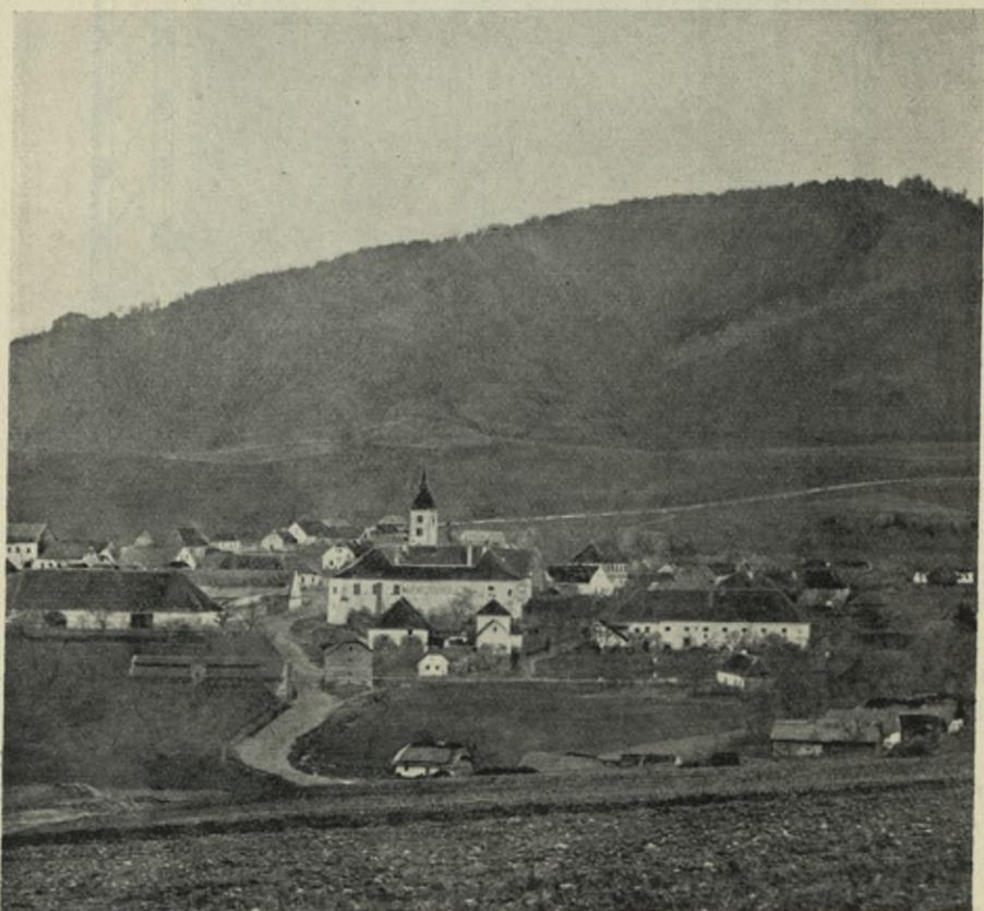
Obr. 226. Louňovice, Zámek, Pohled se strany severozápadní.
