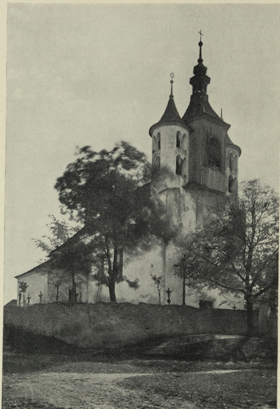
Obr. 148, Kendrac. Pohled na kostel.
