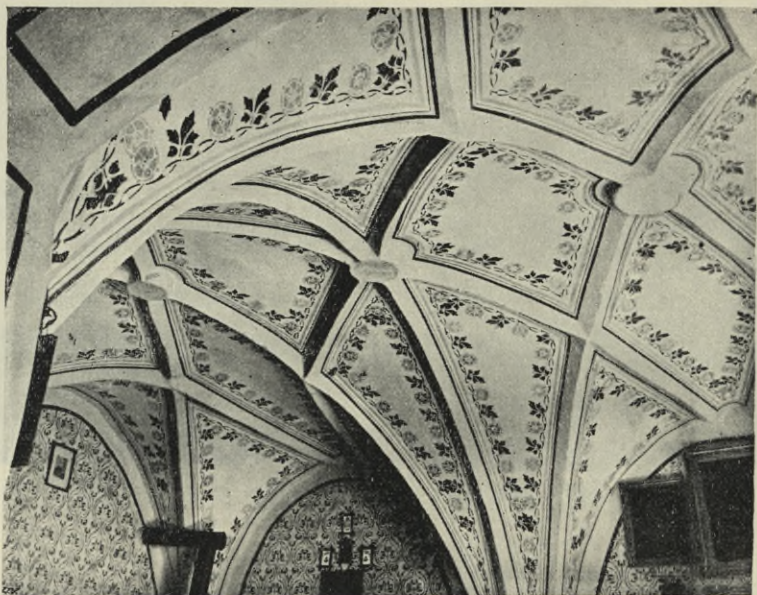
Obr. 279. Písek. Dům čp. 5. v Rybářské ulici. Klenba v přízemí.
