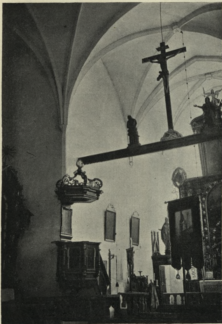
Obr. 359. Velká Blánice. Kostel. Pohled do presbytáře.
