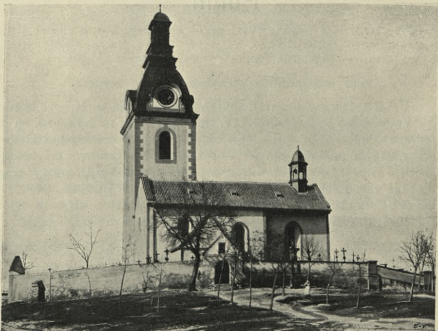
Obr. 322. Putim. Kostel. Pohled od jihu.
