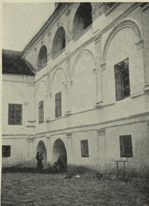
Obr. 115. Křešovice. Zámek. Nádvoří arkády.
