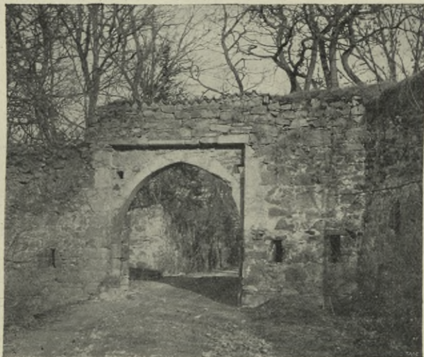
Obr. 416. Zvíkov. Dolejší brána. Pohled od severozápadu.
