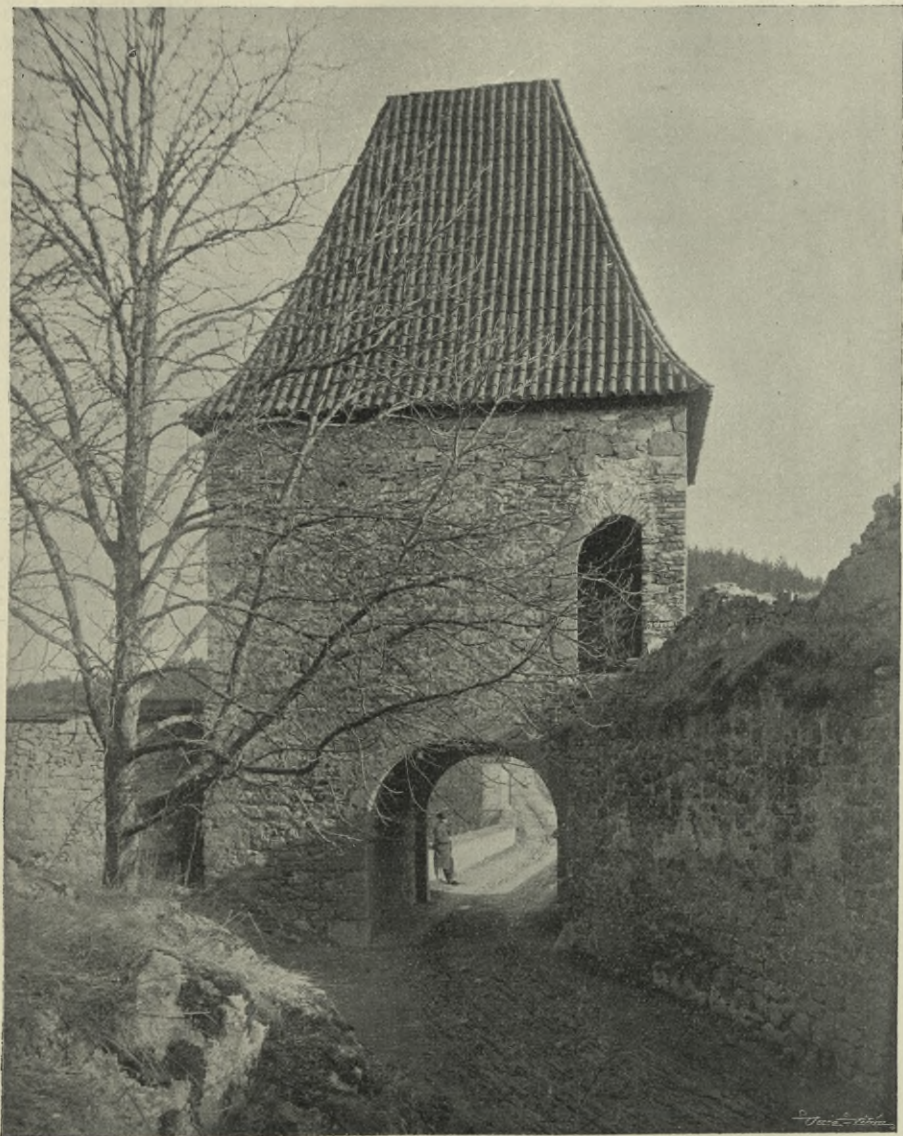
Obr. 409. Zvíkov. Horní brána. Vnitřní strana a průhled na most. Pohled od hlásné věže.
