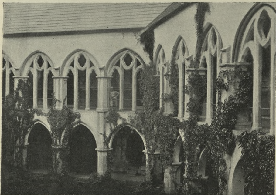
Obr. 431. Zvíkov, Vlastní palác. Arkády nádvoří (restaurované). Pohled z jižních arkád.
