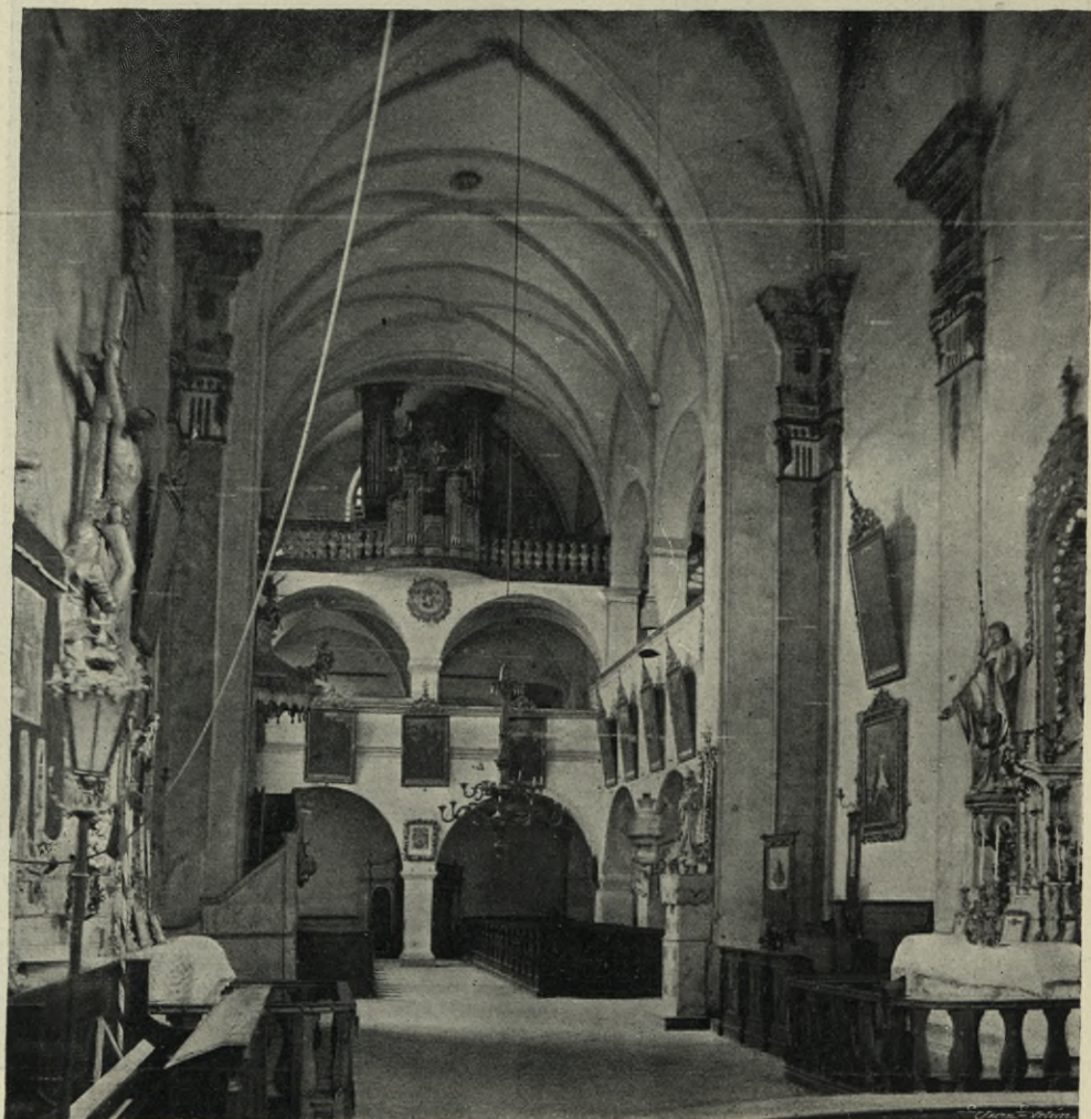
Obr. 381. Vodňany, Děk. kostel. Pohled do vnitřku ke kruchtě. Stav před regotisací.
