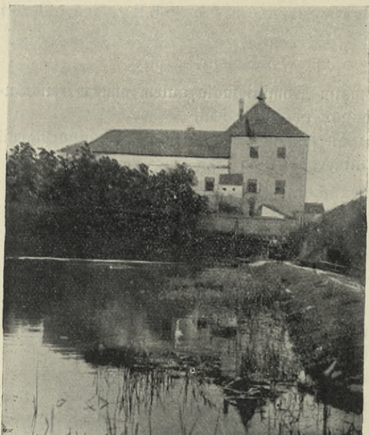
Obr. 113. Křešovice. Zámek. Pohled.
