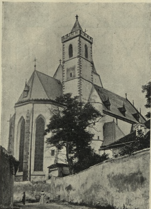
Obr. 3. Bavorov. Kostel P. Marie. Pohled od severovýchodu.
