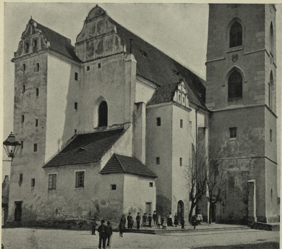
Obr. 378. Vodňany. Děk. kostel. Pohled od jihozápadu. Stav před regotisací.
