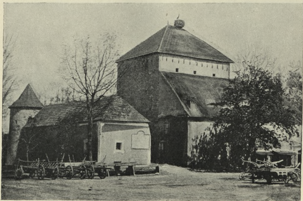
Obr. 89. Kestřany. Dolní tvrz. Pohled přední.
