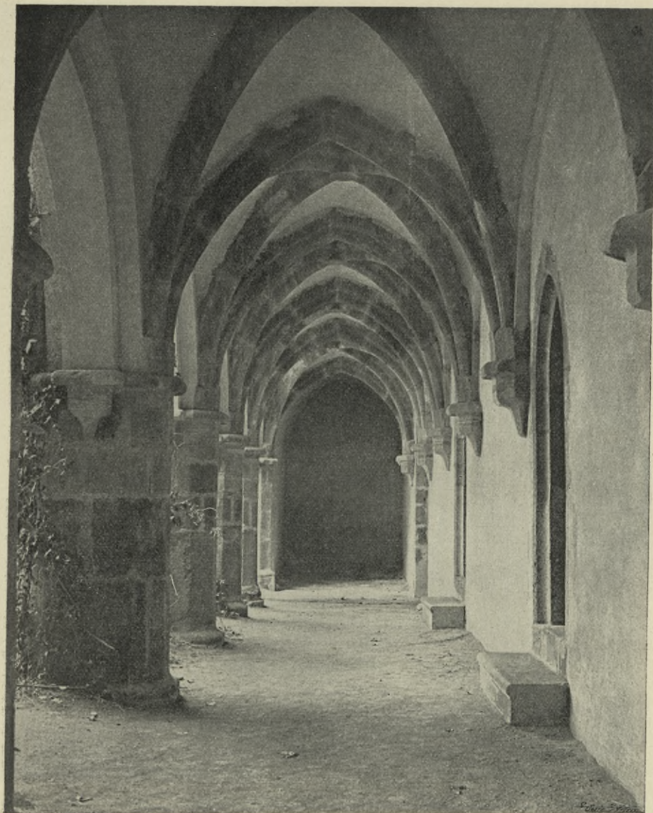
Obr. 433. Zvíkov, Arkády nádvoří v přízemí. Pohled západním měrem.
