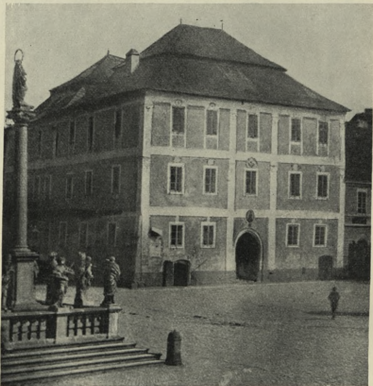
Obr. 282. Písek. Bývalý dům „U černého orla“.
