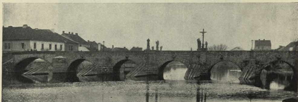
Obr. 192. Písek. Most. Pohled po vodě.
