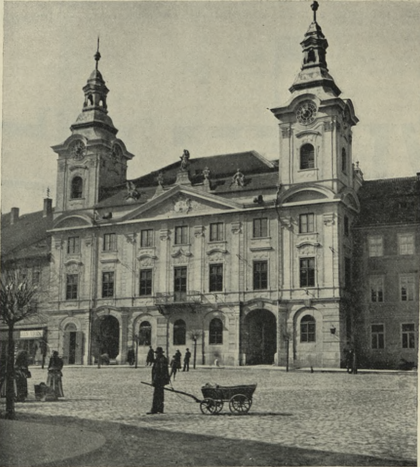
Obr. 267. Písek. Radnice. Hlavní průčelí.
