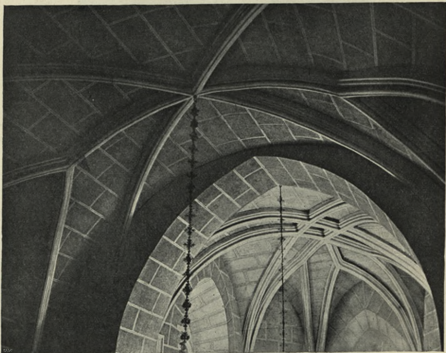
Obr. 167. Orlík. Zámek. Klenba kaple.
