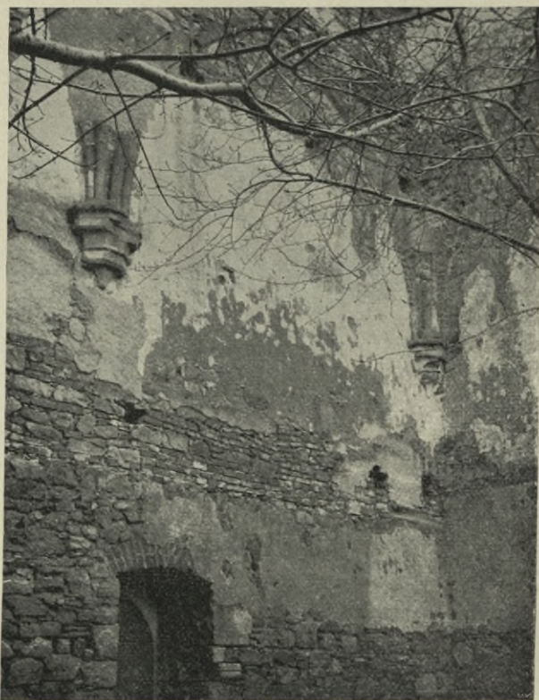
Obr. 447. Zvíkov. Vlastní palác. Zbytky t. zv. rytířské síně v severním traktu.
