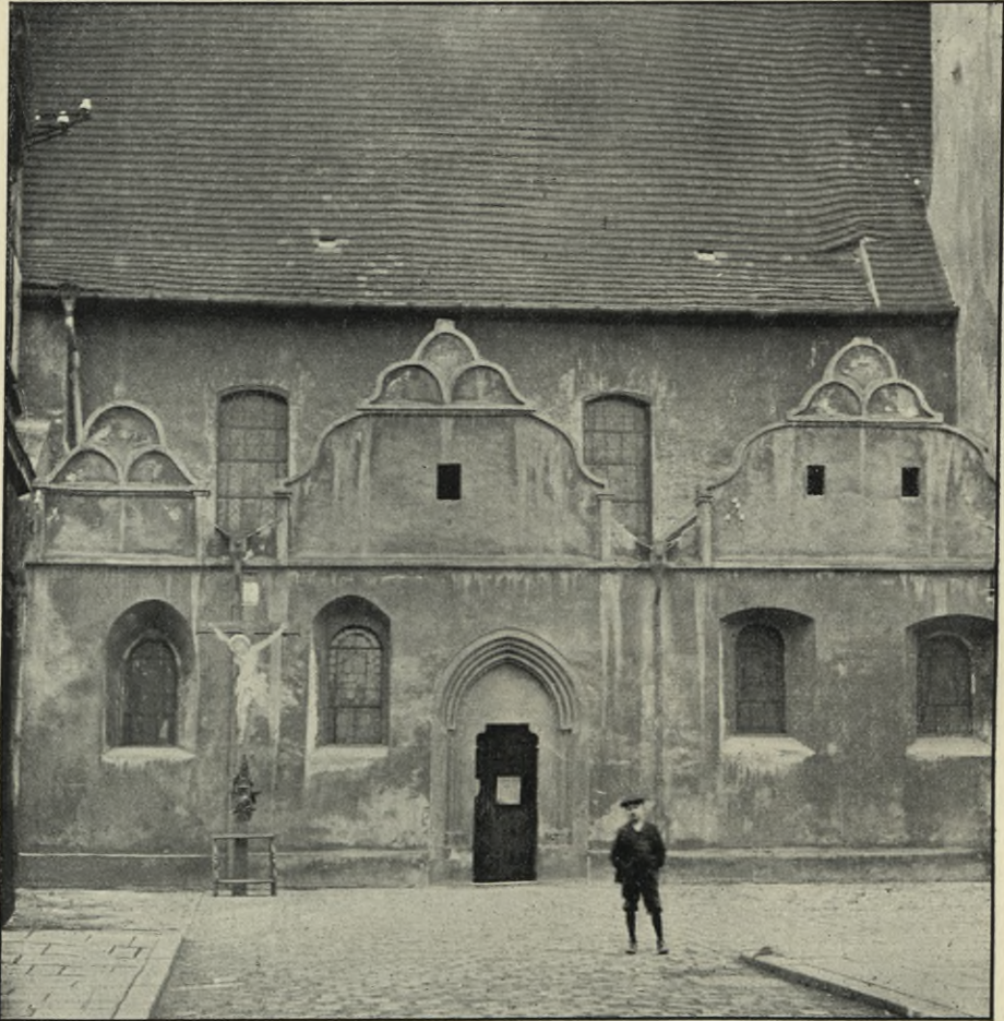
Obr. 231. Písek. Děk. kostel. Severní loď.
