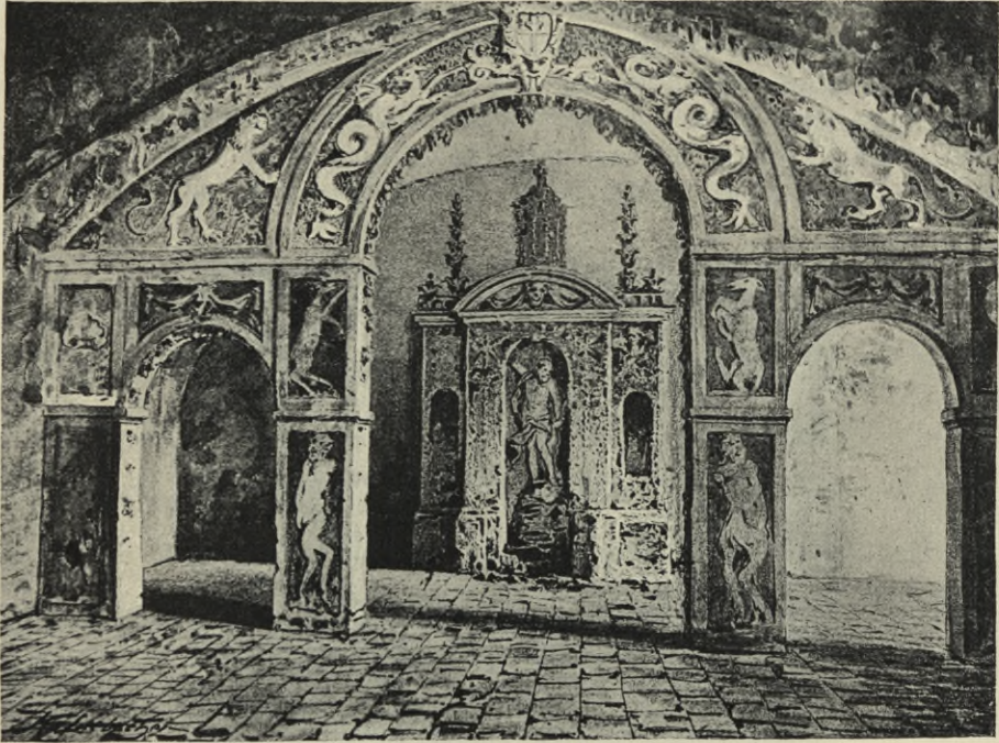
Obr. 97. Kestřany. Zámek. Salla terrena.
