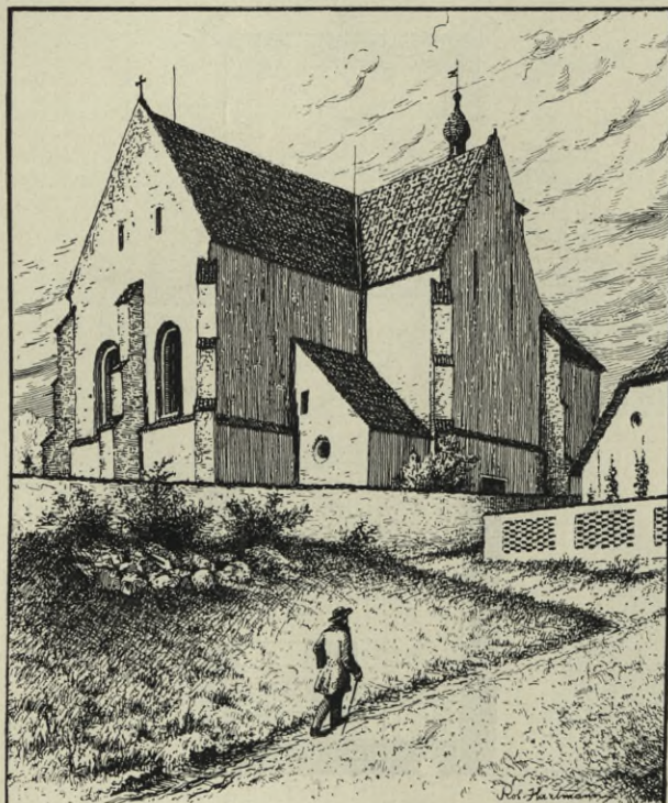
Obr. 357 Velká Blánice, Kostel. Pohled od jihovýchodu.
