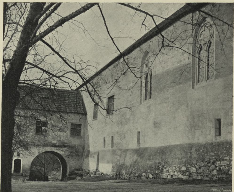
Obr. 412. Zvíkov, Vnitřní nádvoří. Pohled na západní trakt vlastního paláce a Novou bránu.
