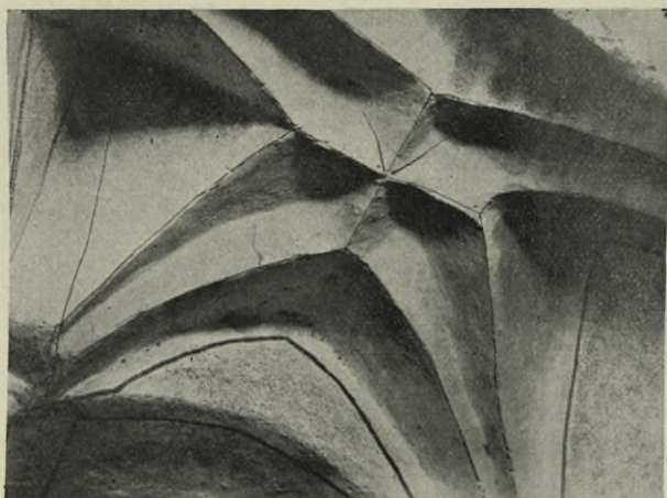
Obr. 272. Písek. Dům č. 10. Klenba v průjezdě.
