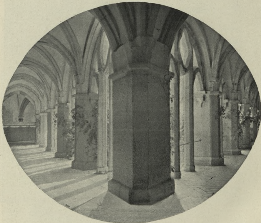
Obr. 434. Zvíkov. Arkády nádvoří v I. patře. Pohled do dvou ramen.
