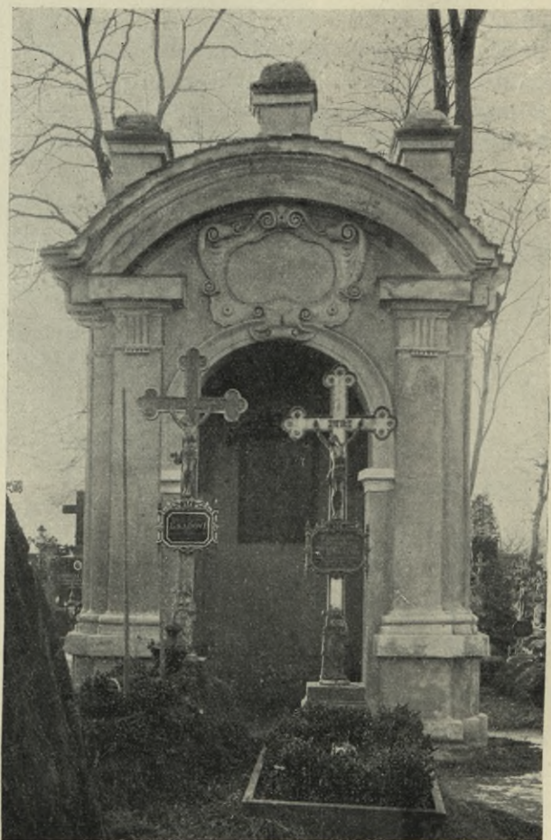
Obr. 260. Písek, Hřbitov. Kaple na západě.
