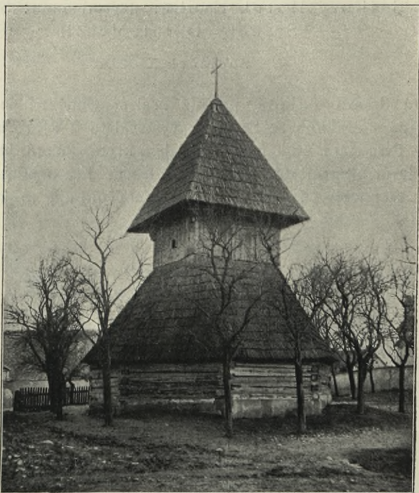
Obr. 307. Horní Stakory. Dřevěná zvonice.
