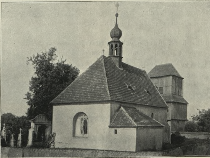
Obr. 124. Mečeříž. Kostel sv. Kříže. Pohled od severovýchodu.
