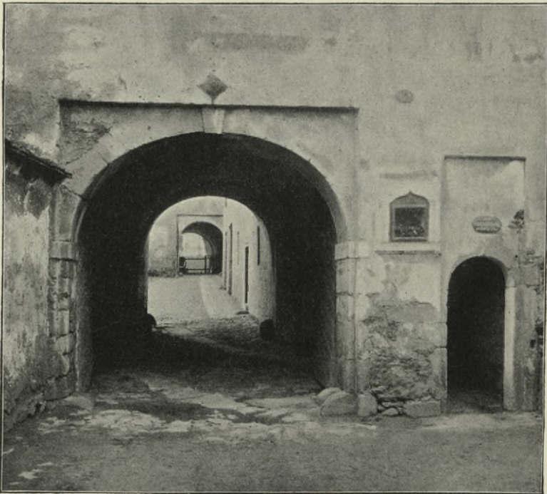
Obr. 394. Žirovnice. (Vjezd do zámku a fortna.)
