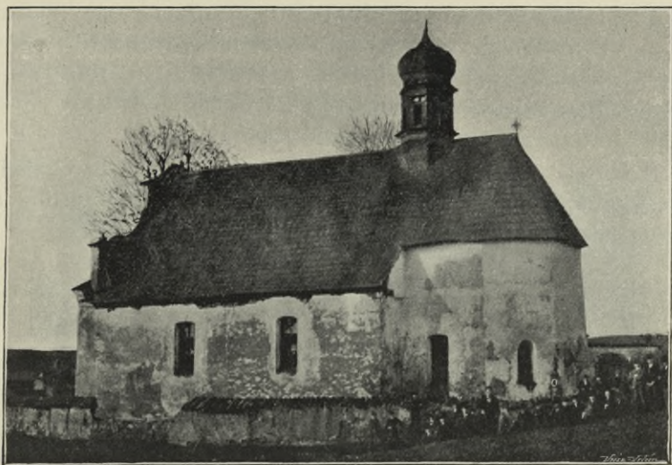
Obr. 261. Pelhřimov. Hřbitovní kaple Božího Těla.
