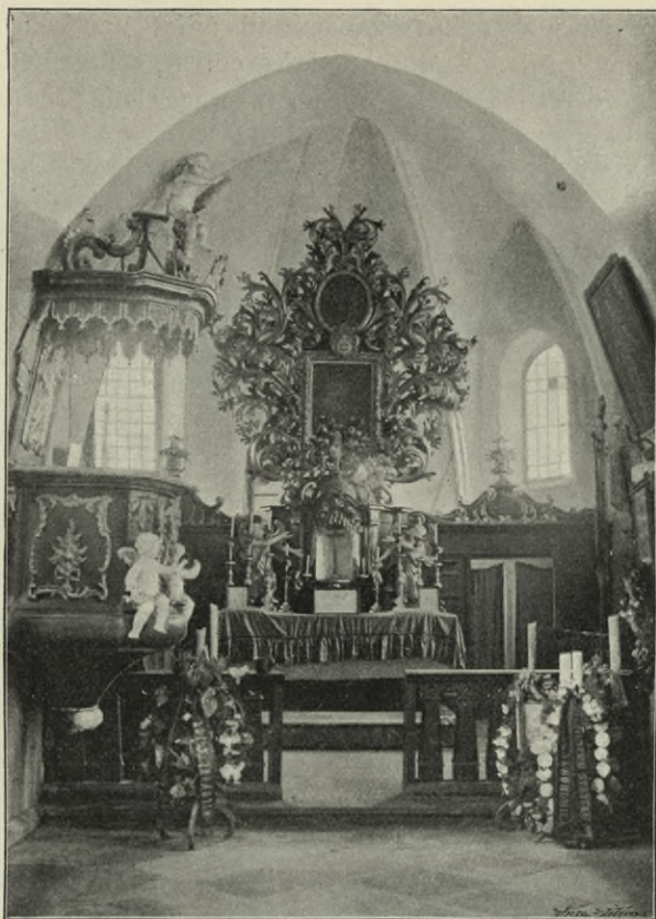
Obr. 357. Ústrašín. Pohled do presbytáře.
