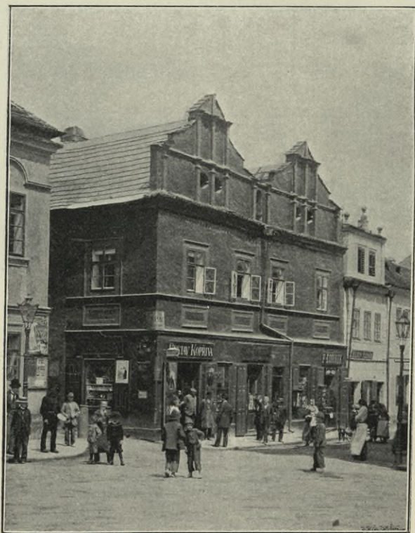
Obr. 206. Pelhřimov. Pohled na dům č. 62.
