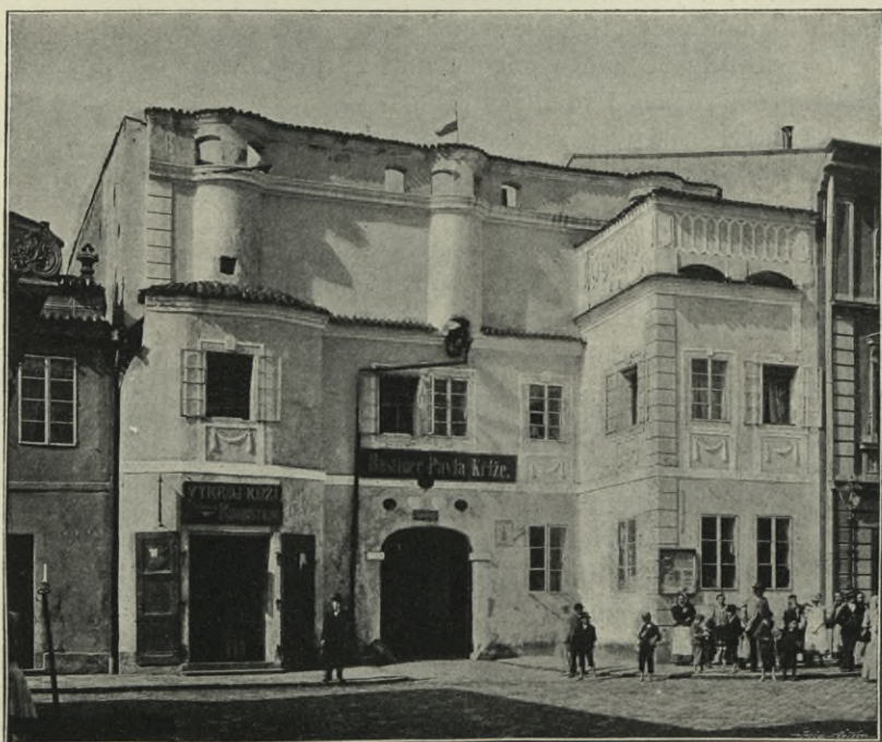
Obr. 201. Pelhřimov. Pohled na dům č. 17.
