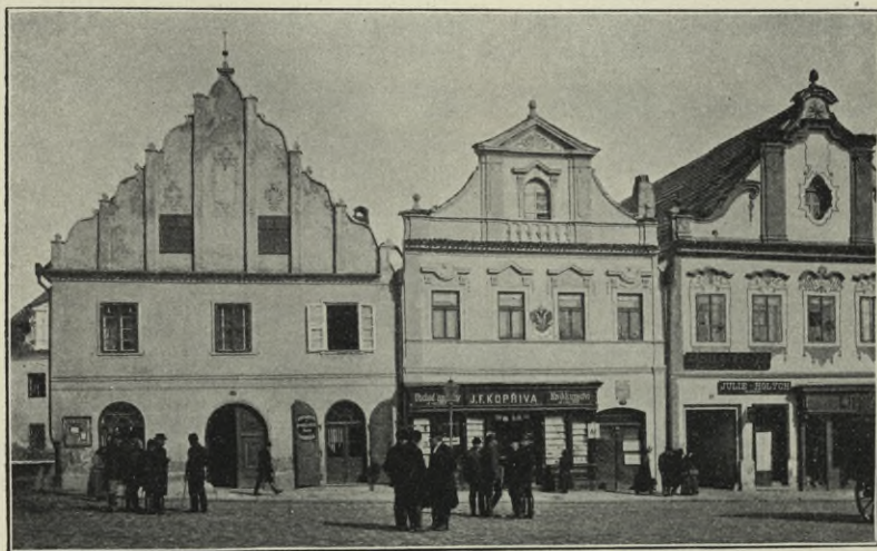
Obr. 204. Pelhřimov. Pohled na domy č. 6, 5, 4.
