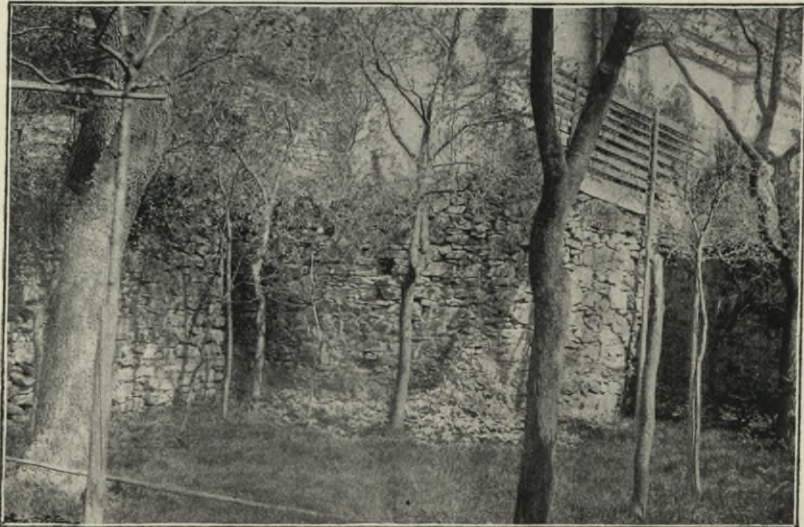
Obr. 189. Pelhřimov. Bašta v zahradě domu č. 33.
