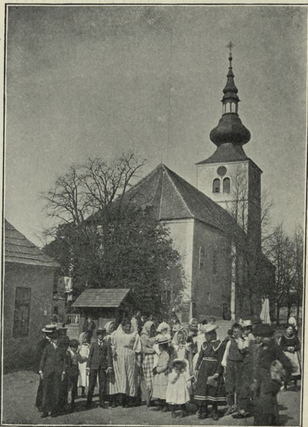
Obr. 96. Kamenice n. L. Kostel.
