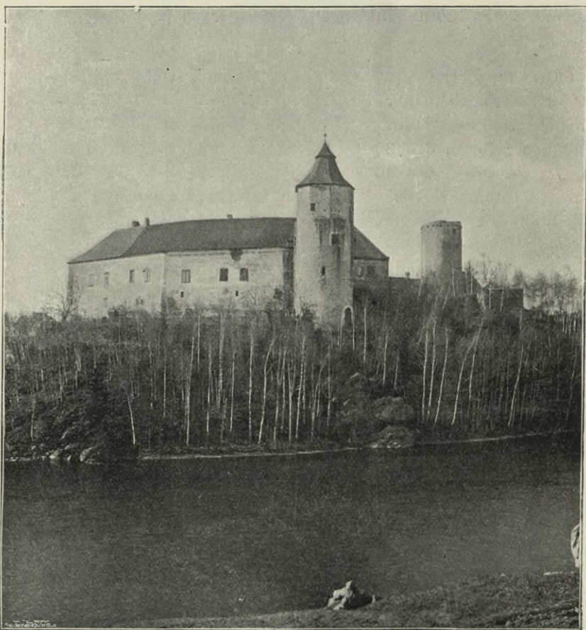
Obr. 392. Žirovnice. Pohled na zámek.
