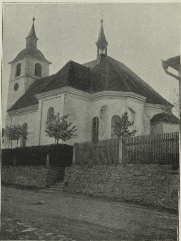
Obr. 295. Rychnov Nový. Pohled na kostel.
