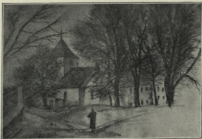
Obr. 76. Velká Chýška. Pohled na starý kostel.
