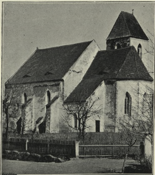
Obr. 43. Domažlice. Kostel »u Svatých« (před opravou věže).
