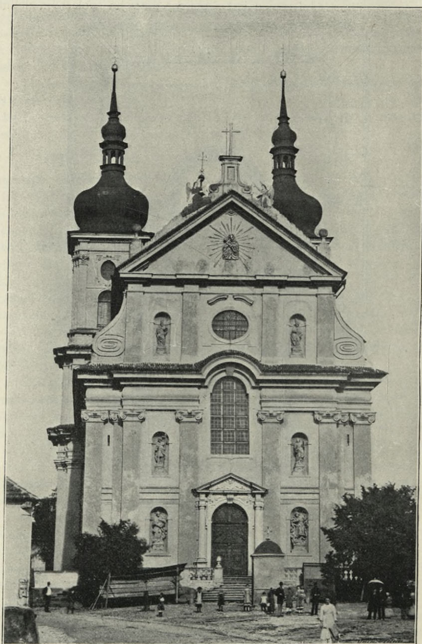
Obr. 78. St. Boleslav. Kostel P. Marie (průčelí).
