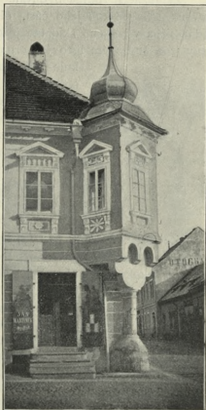
Obr. 192. Hradec J. Arkýř domu č. 69—II.
