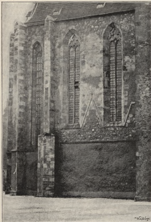
Obr. 22. Budějovice. Pohled na kůr klášterního chrámu od severu.
