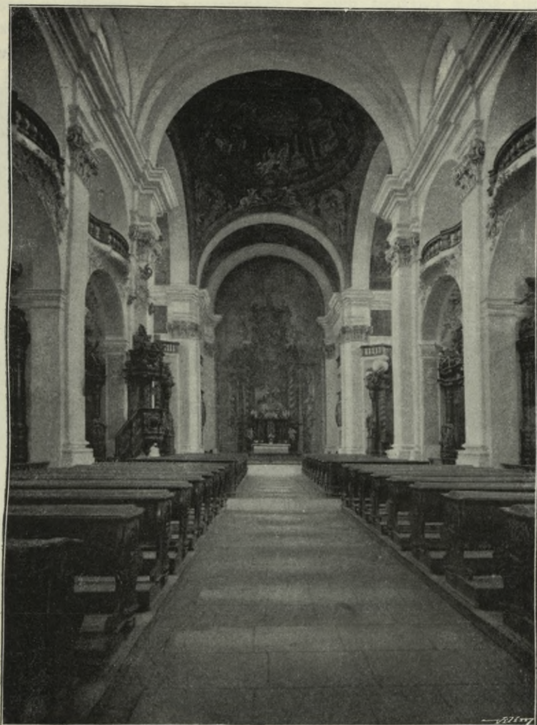
Obr. 47. Klatovy. Vnitřek jezuitského kostela.
