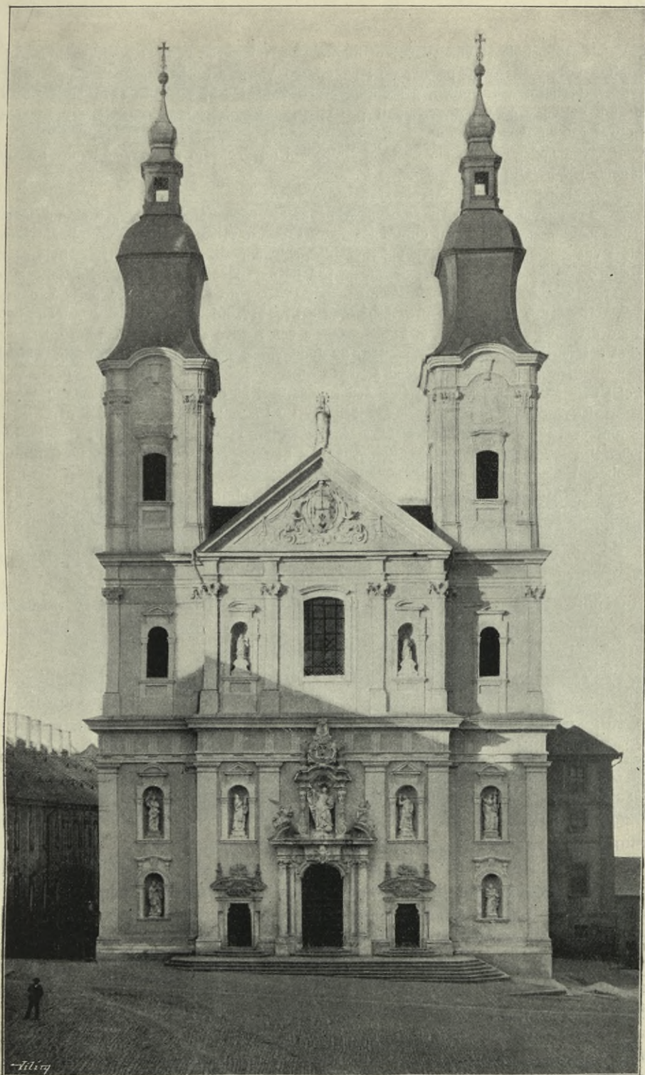
Obr. 43. Klatovy. Průčelí jesuitského kostela.
