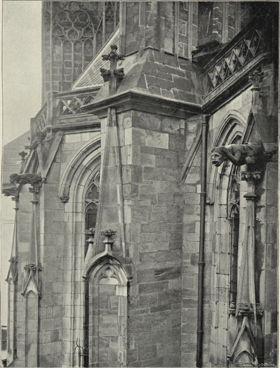
Obr. 18. Fiála na pilířích dělicích okružní kaple.
