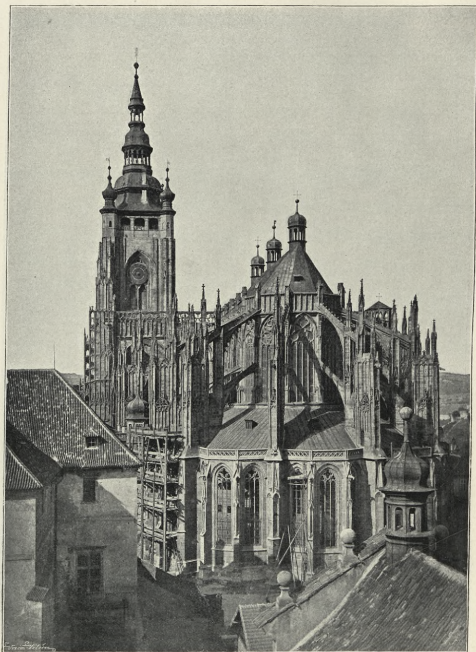
Obr. 19. Pohled na chrám od východu při počátcích opravy r. 1863.
