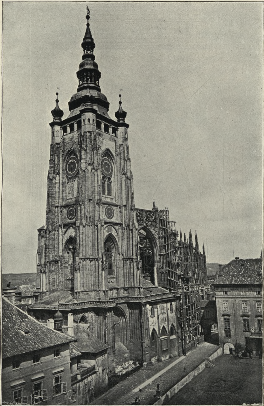
Obr. 102. Pohled na věž před opravou.
