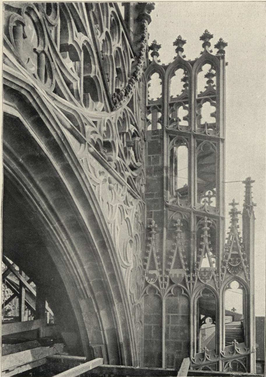
Obr. 95. Pohled na západní stranu jižního schodiště.
