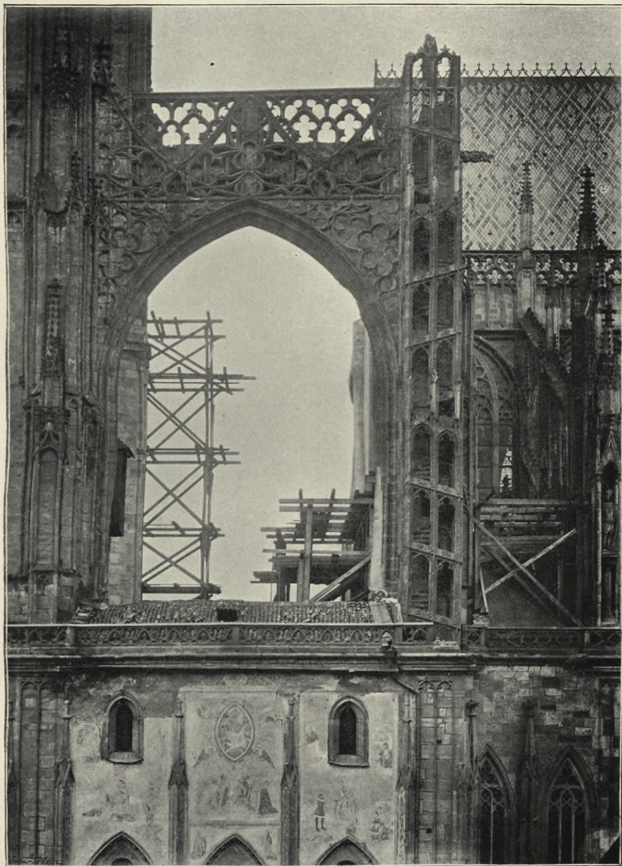
Obr. 93. Pohled na jižní průčelí křížové lodi (před restaurací).
