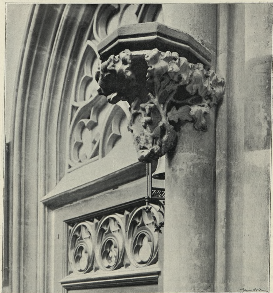
Obr. 159. Konsola na přístěnném pilíři u vchodu do sakristie. \frac{1}{10} skut. velikosti.
