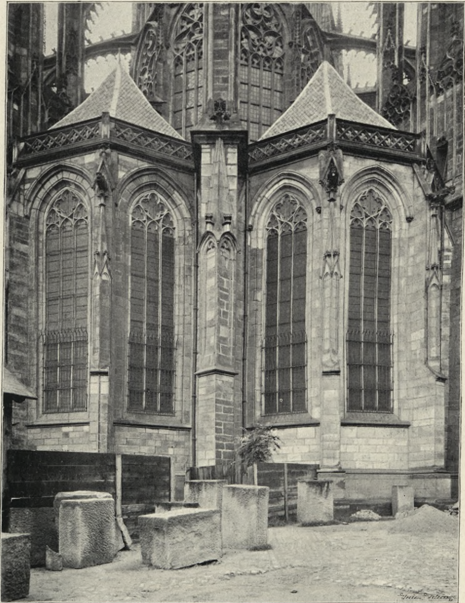
Obr. 17. Průčelí okružních kaplí.
