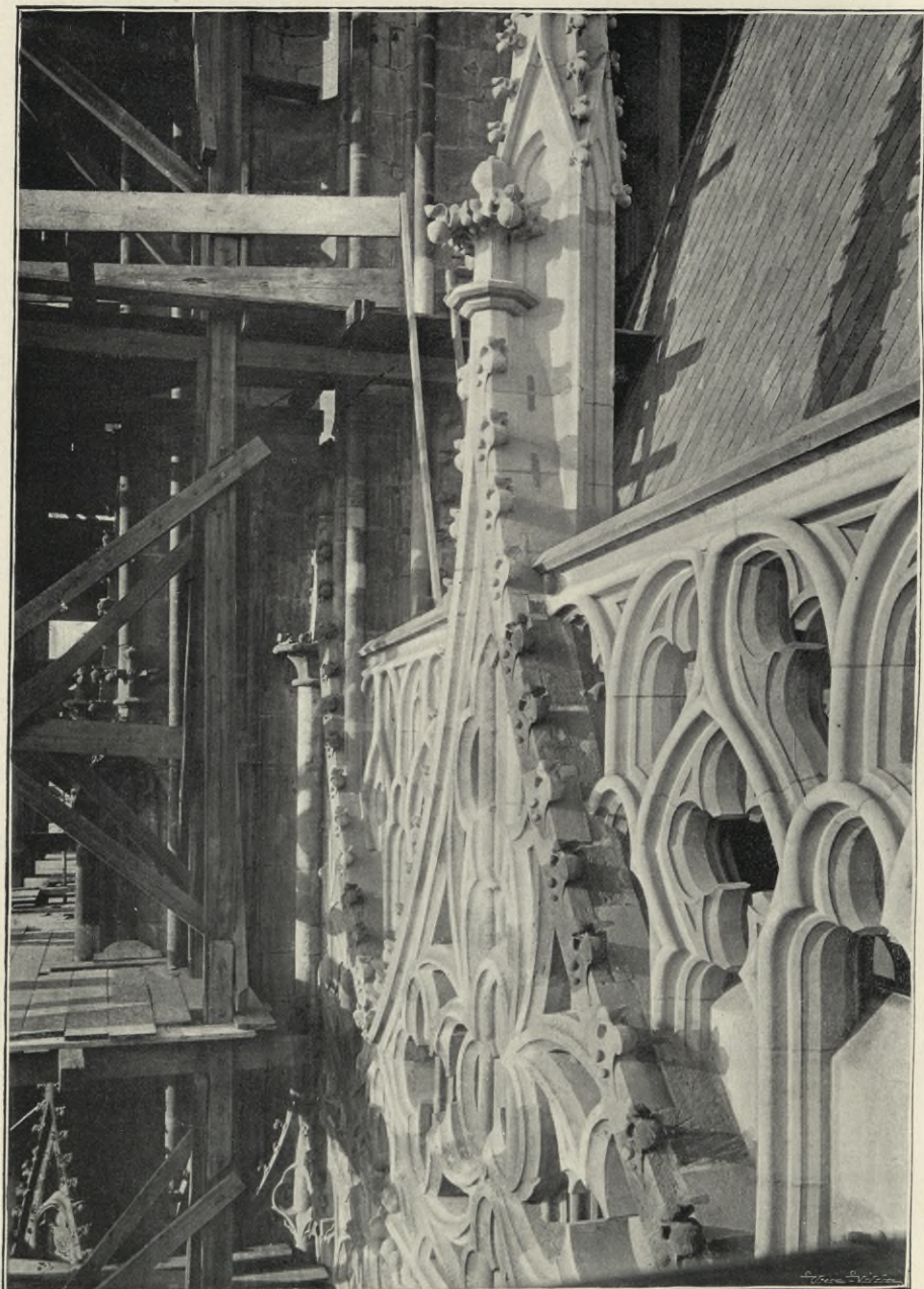
Obr. 94. Pohled na hořejší restaurovanou část jižního okna křížové lodi.
