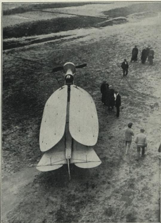
Abb. 8. Das Flugzeug des Franzosen Marcan-Mooren mit insektenartig zusammengeklappten Flügeln.
