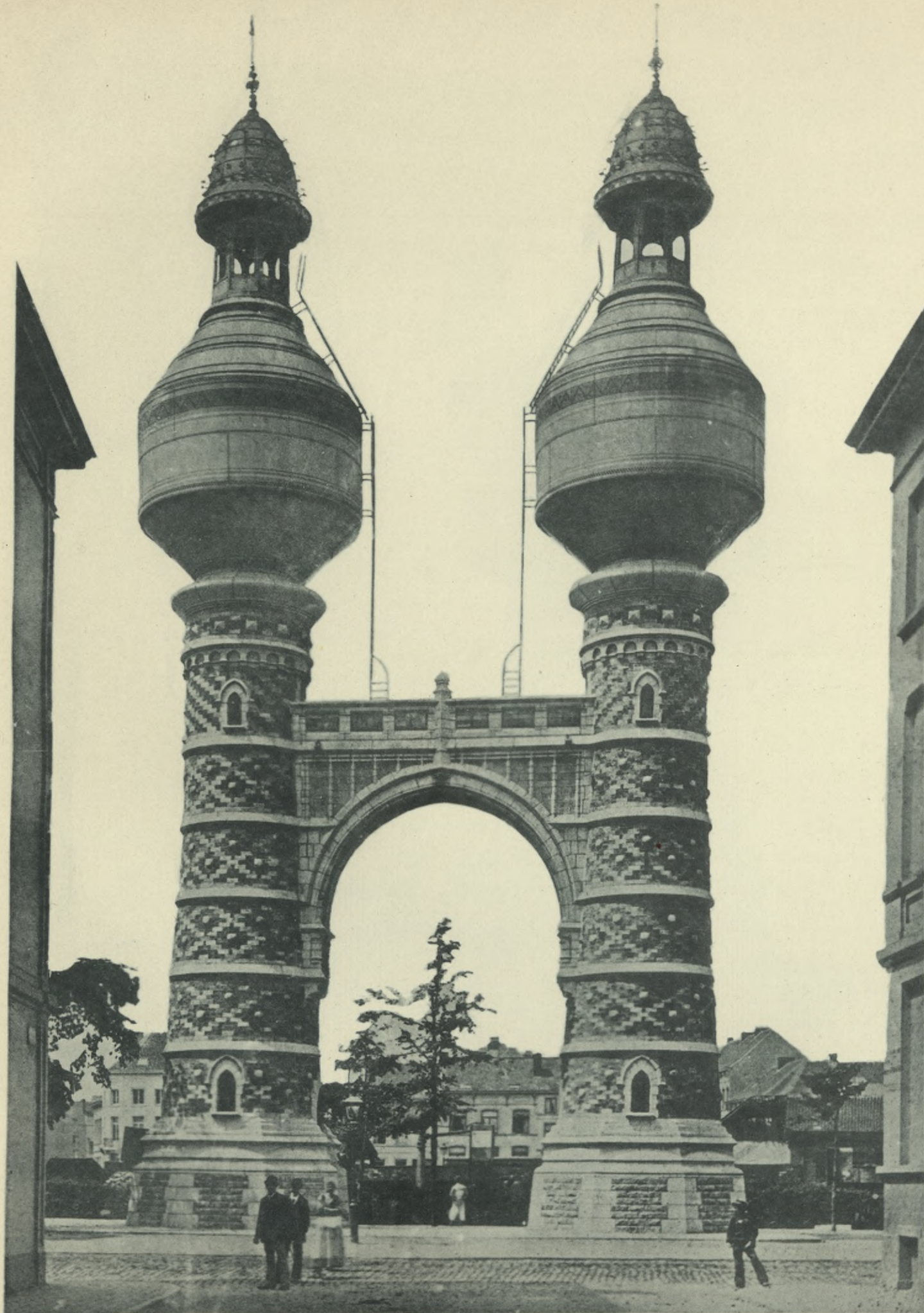
Doppel-Wasserthurm, 600 cbm Wasser fassend. Bahnhof Antwerpen (Est).
