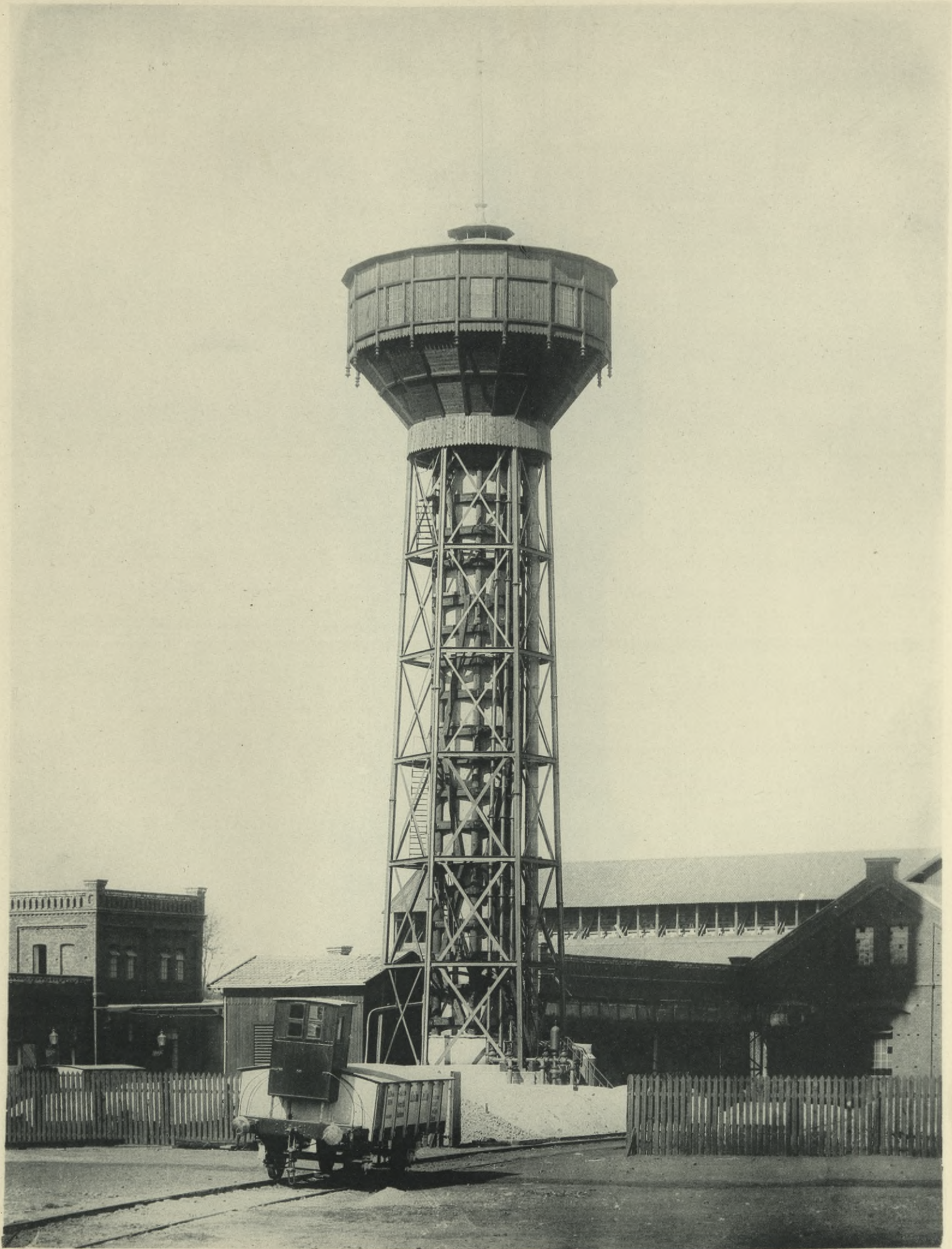
Absorptionsturm, 190 cbm, für Wilhelm Grillo in Oberhausen.
