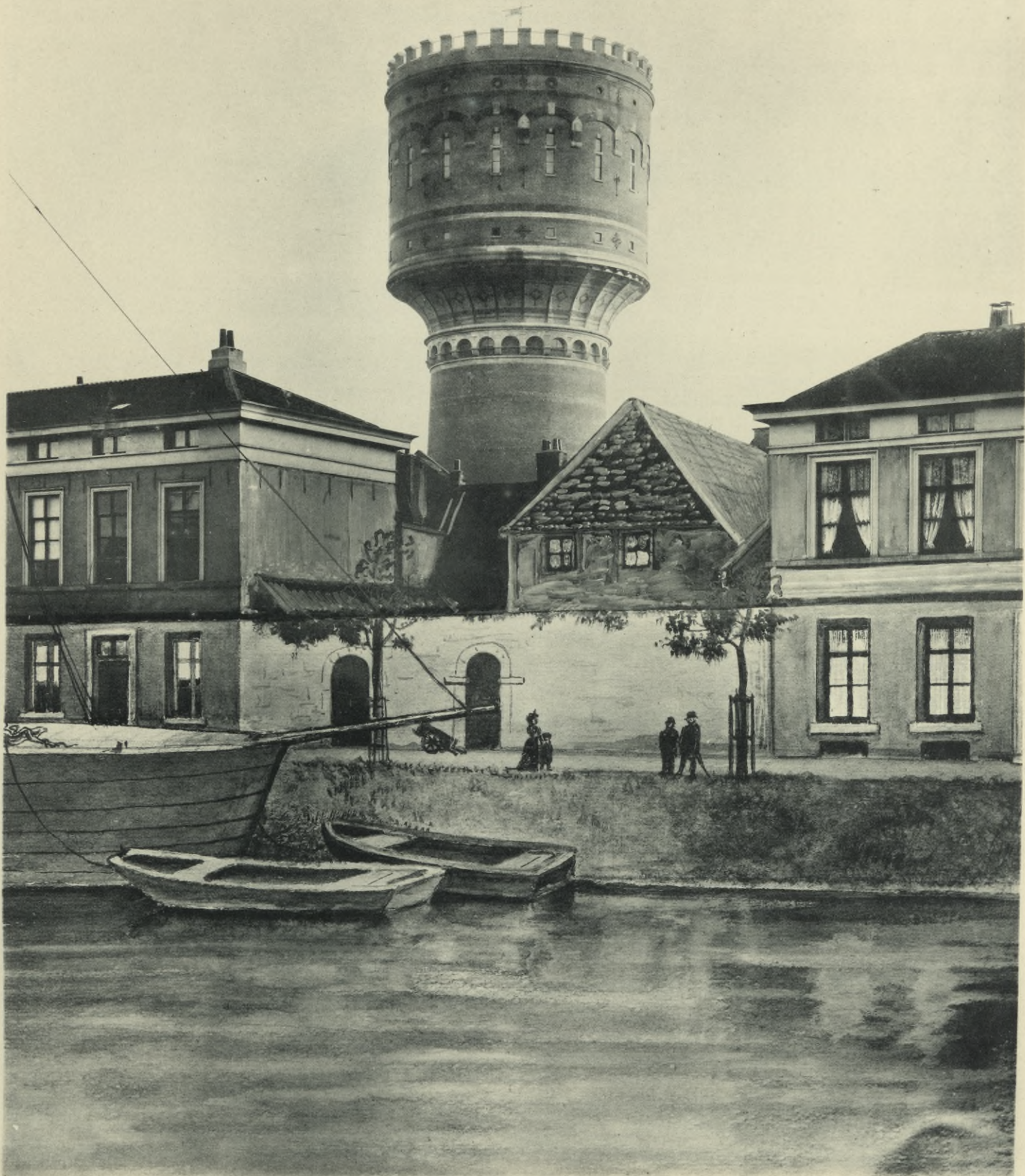
Wasserthurm, 1500 cbm, Utrecht (Holland).
