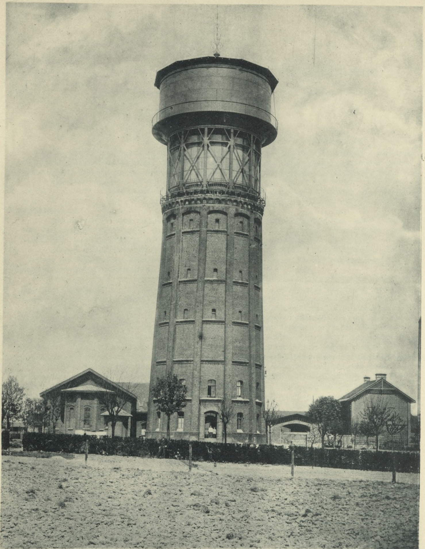
Wasserbehälter auf Eisenstütze, 800 cbm, aufgestellt über einen bestehenden von 400 cbm, für das Wasserwerk Mülheim-Deutz-Kalk (Rheinische Wasserwerks-Gesellschaft zu Bonn, Director Thomatzek).
