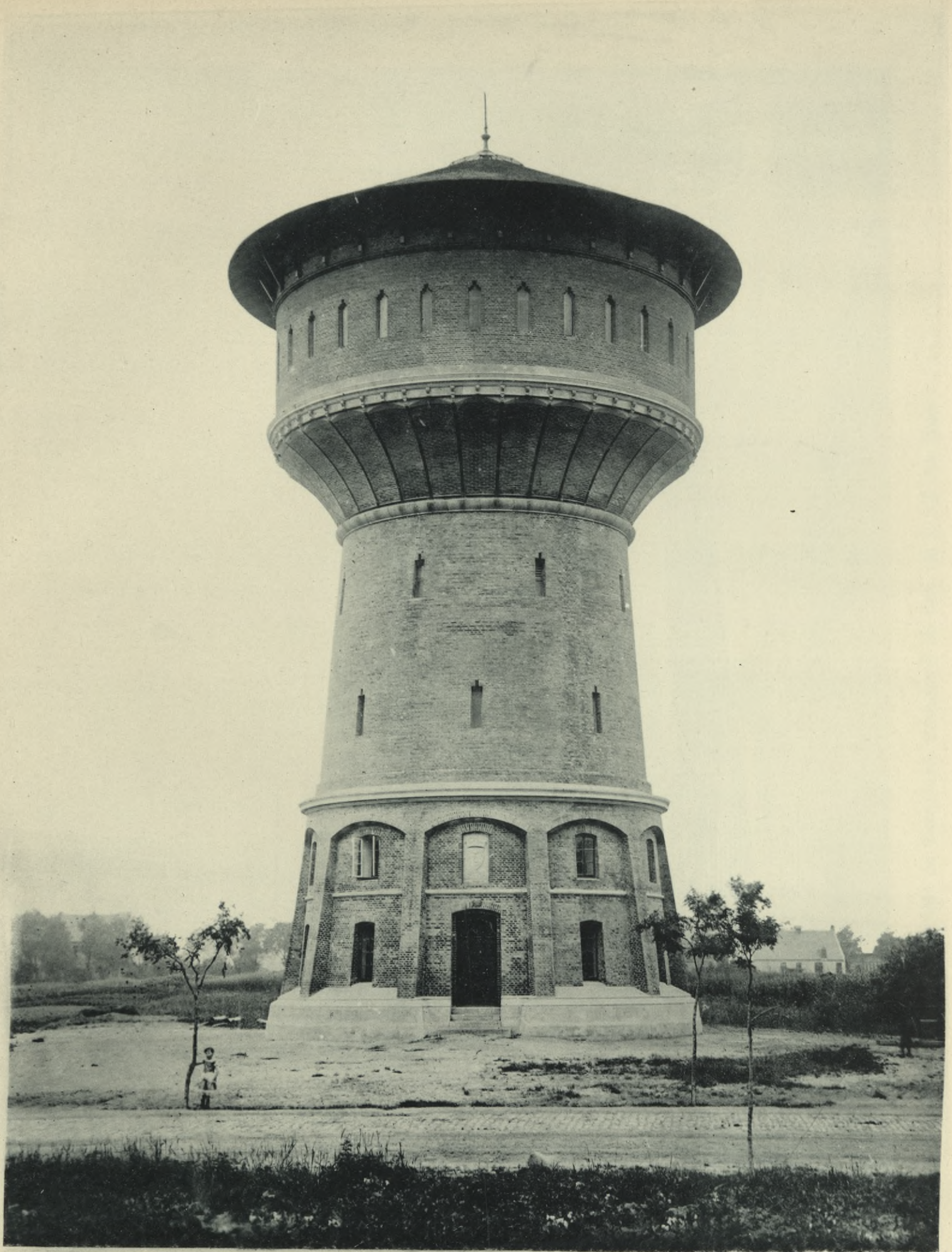
Wasserthurm Bremerhaven, 650 cbm. Ingenieur Walter Pfeffer in Halle a. d. S.
