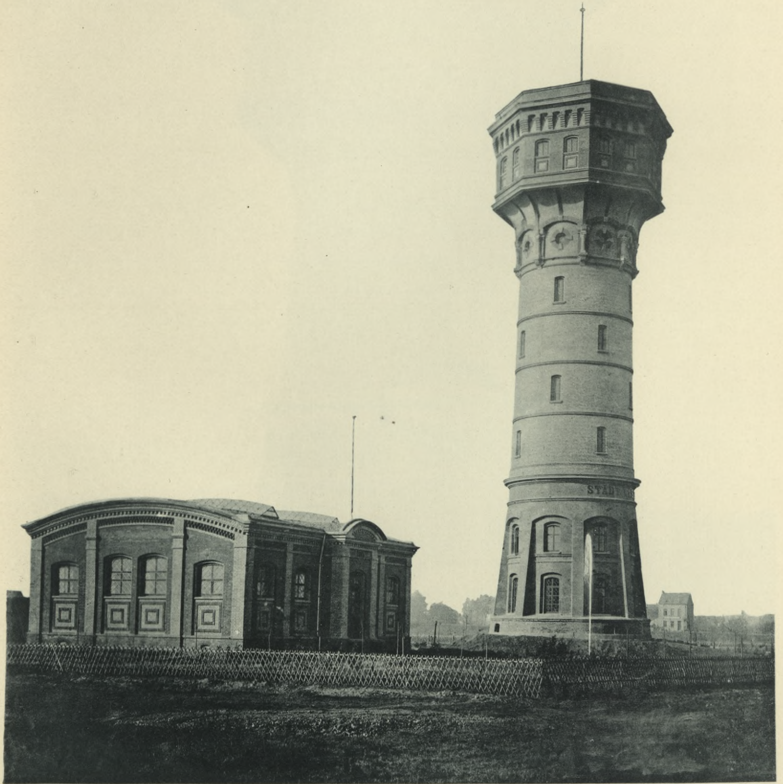
Wasserthurm Düren, 550 cbm.
