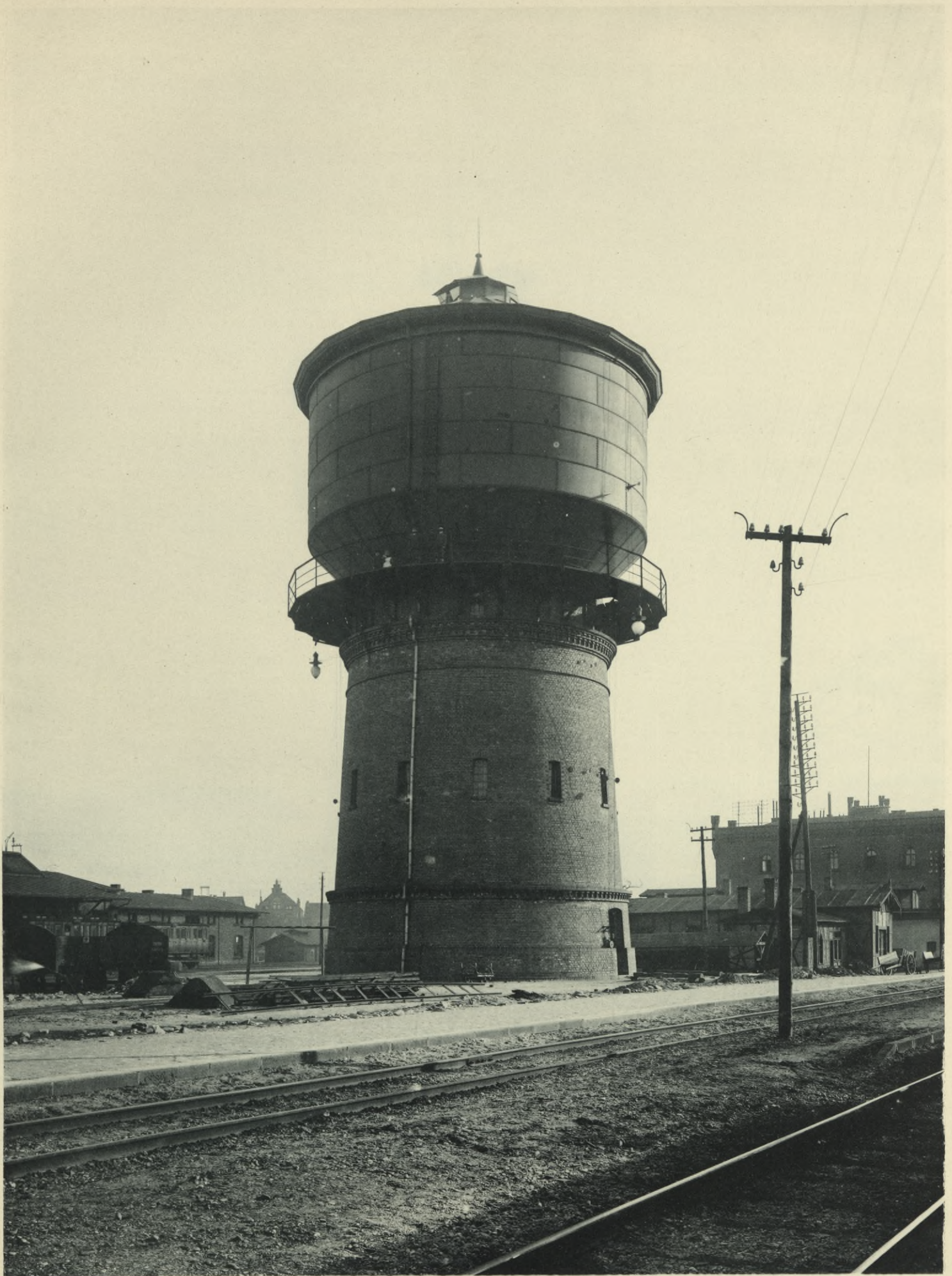
Wasserthurm Eisenbahnstation Hamm. Inhalt 800 cbm.
