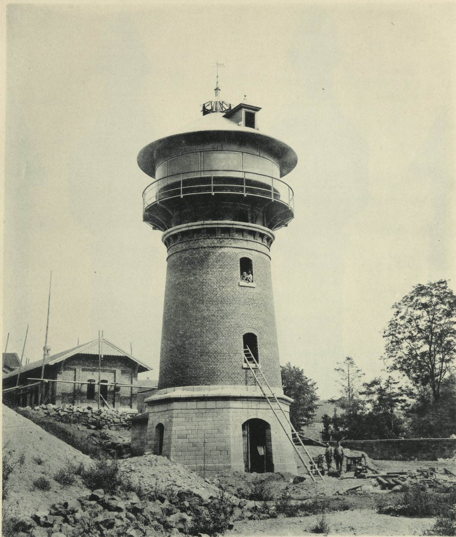
Wasserthurm von 100 cbm Inhalt in Völklingen.
