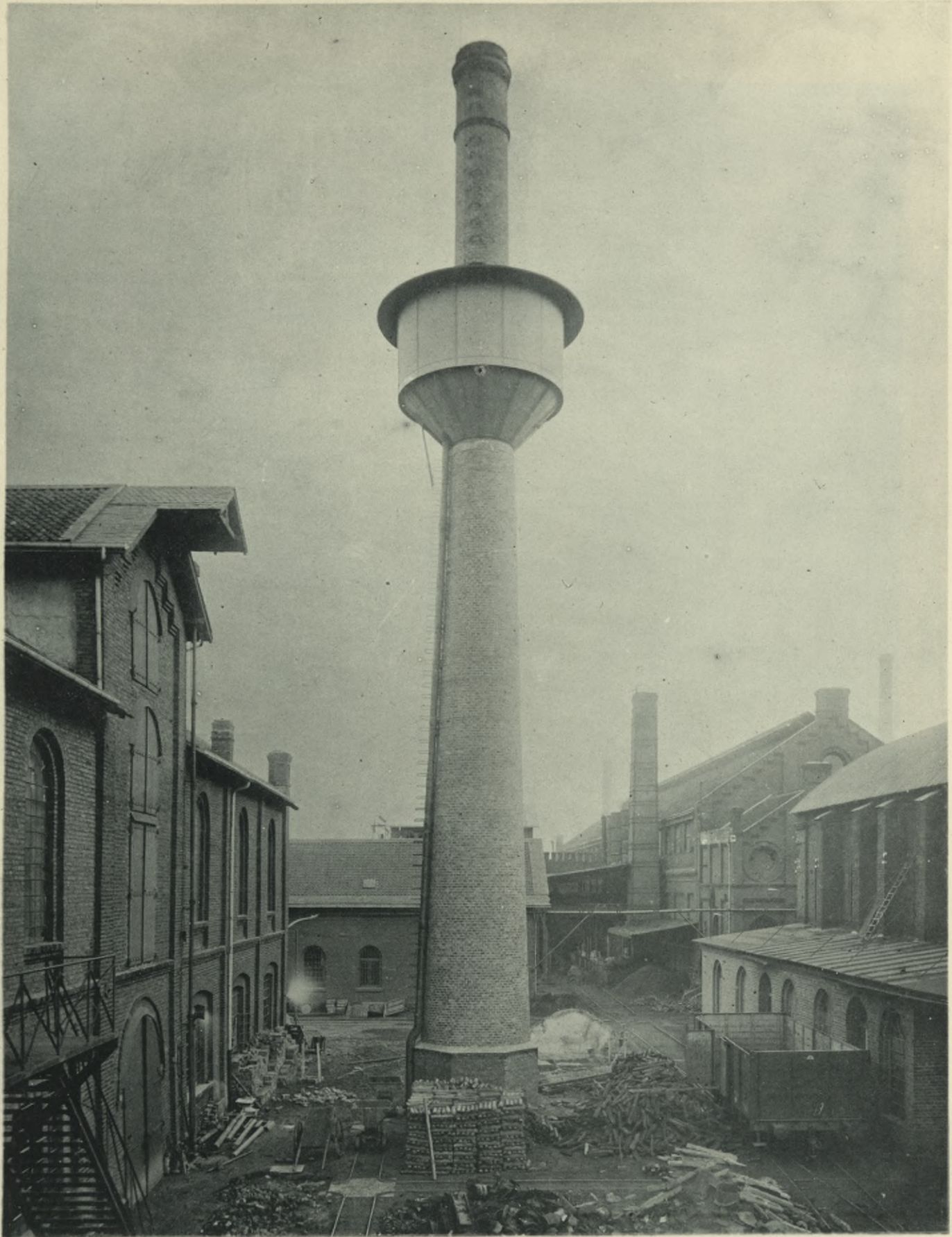
Kamin-Reservoir, 40 cbm Inhalt, von Haniel & Lueg in Düsseldorf, erbaut von G. Lütgen-Borgmann in Eschweiler und Berlin.
