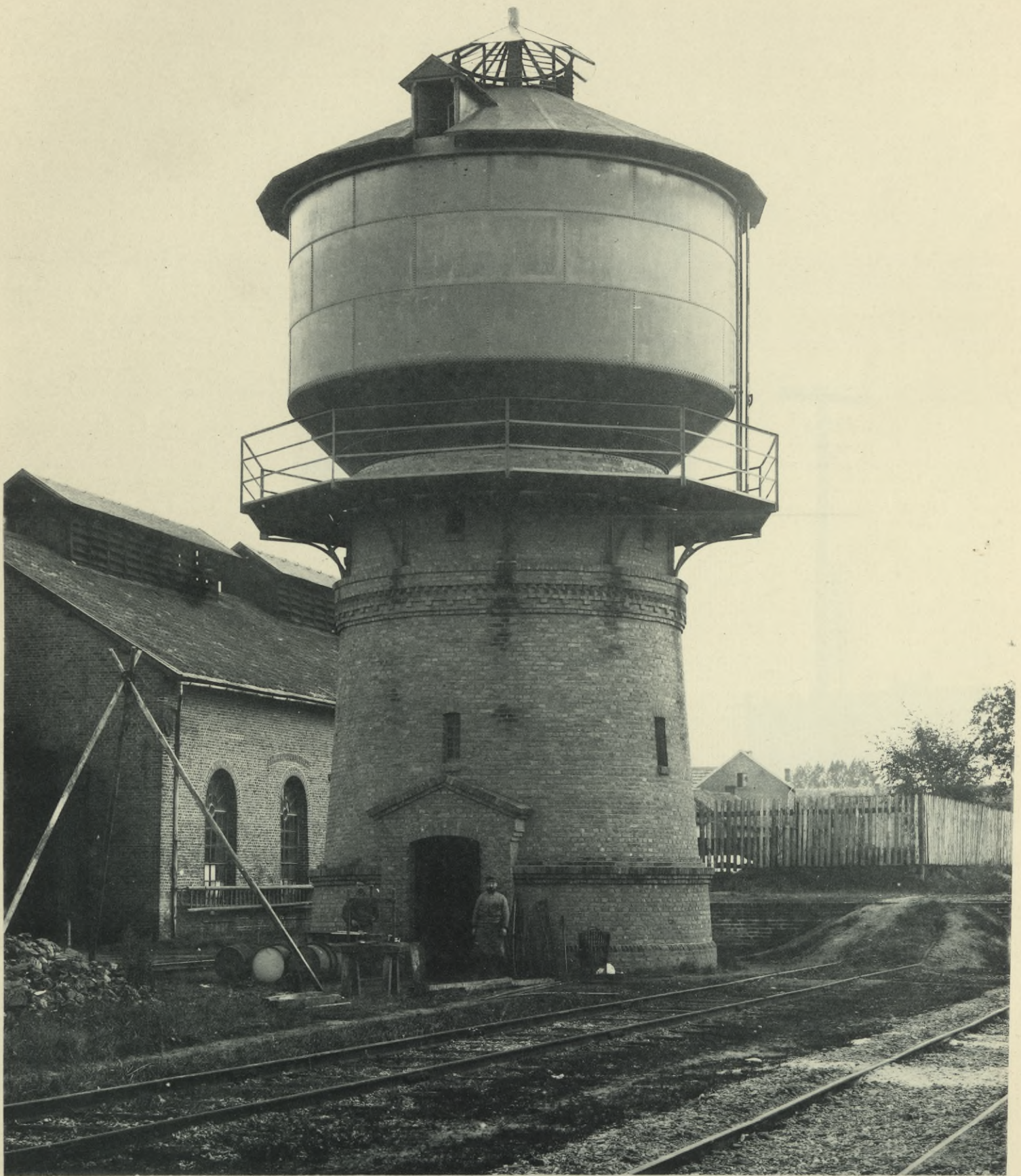
Wasserturm Eisenbahnstation Herzogenrath. Inhalt 200 cbm.
