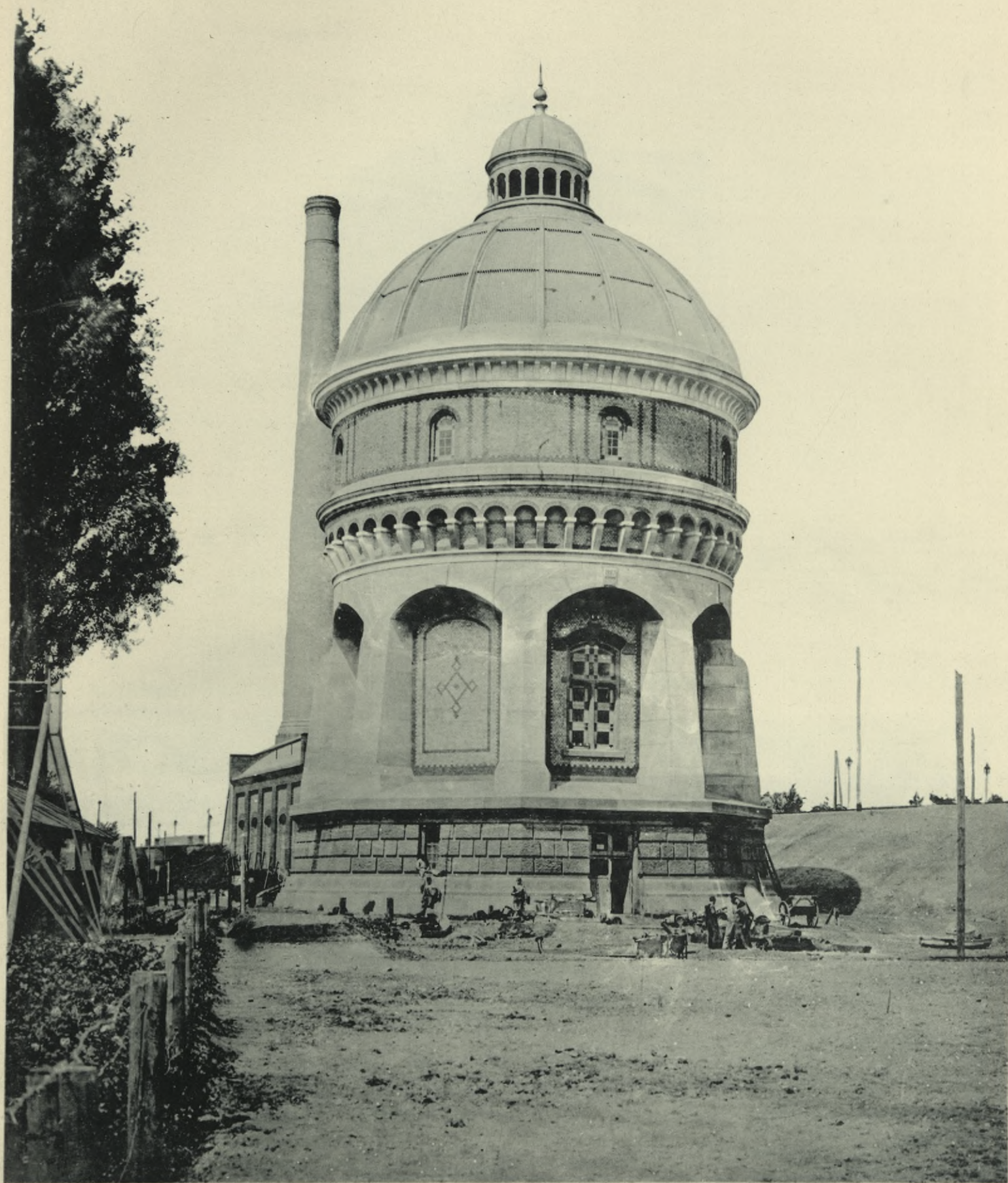
Wasserturm mit Doppelreservoir, 800 cbm.
