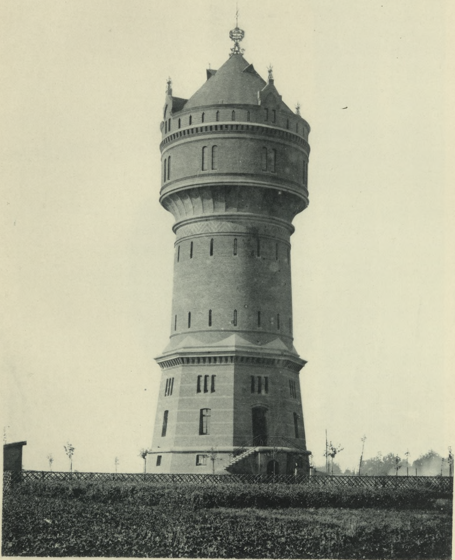
Wasserthurm Rheydt, 600 cbm. Entwurf von Intze und Clodius.
