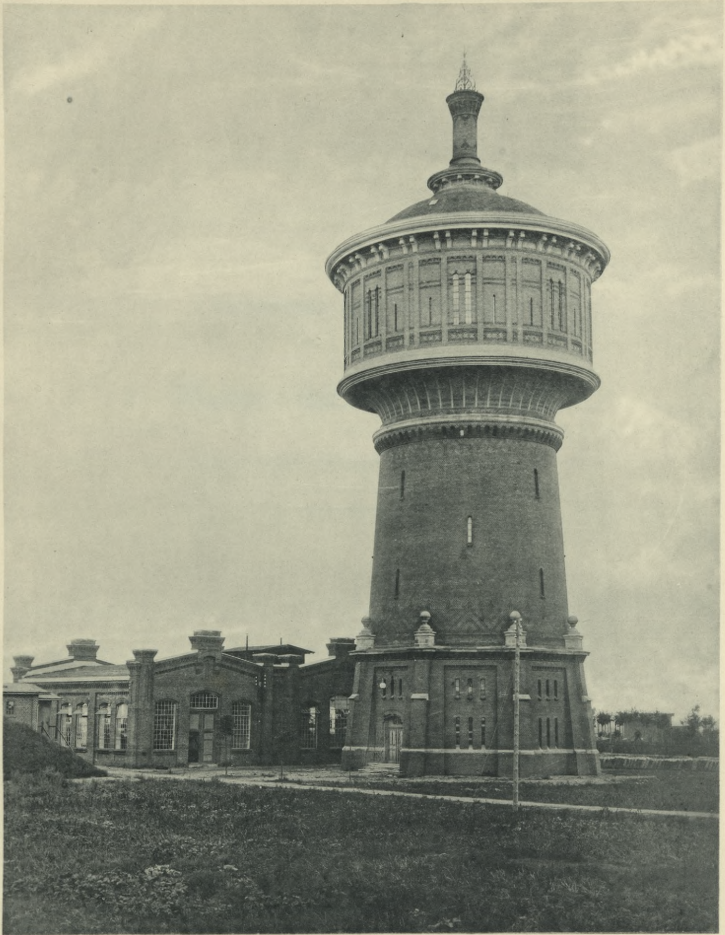
Wasserturm, 1000 cbm Wasser-Inhalt, Bahnhof Salbke bei Magdeburg.
