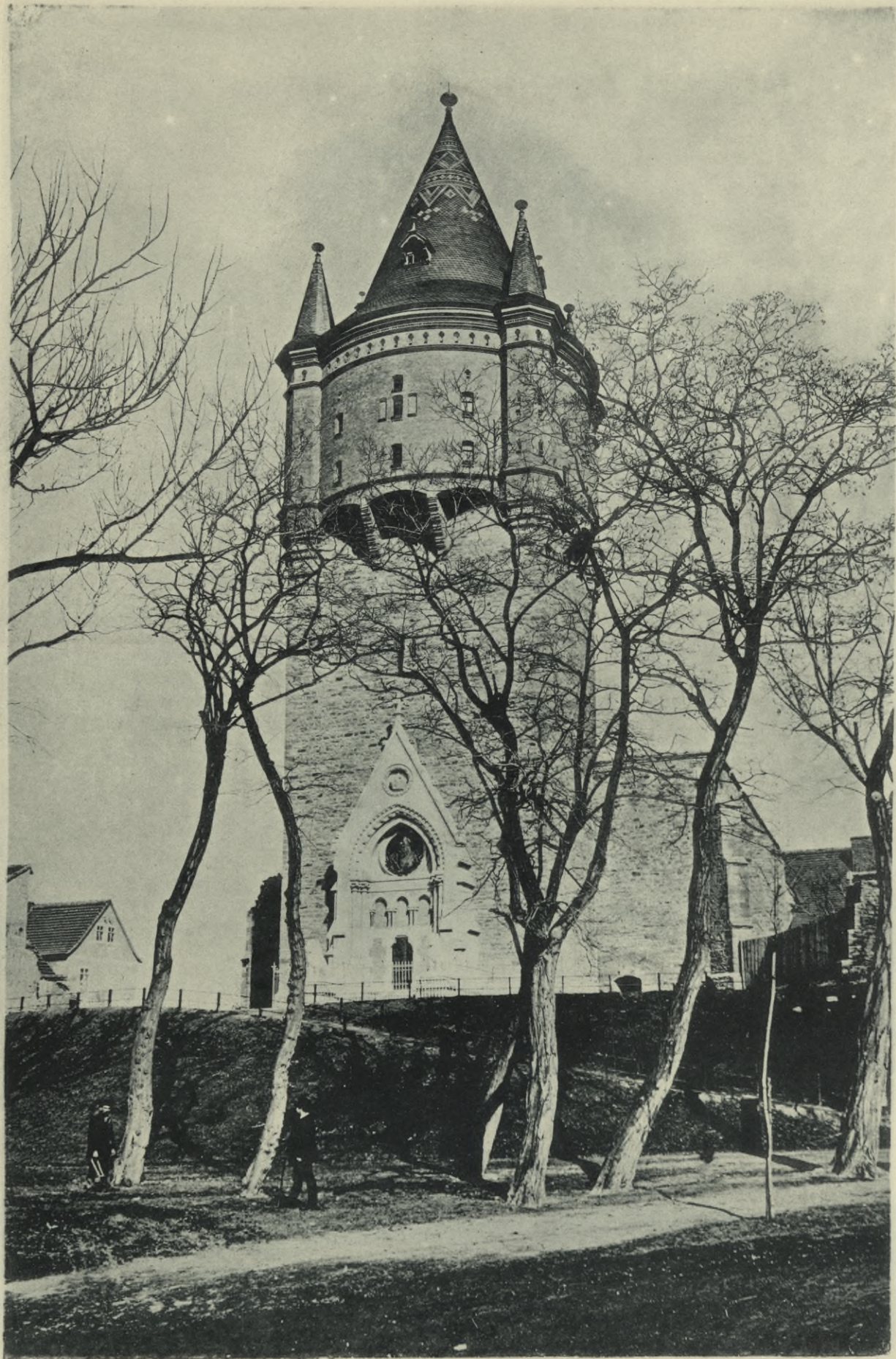
Wasserkwerk Merseburg, 850 cbm. Ingenieur Walter Pfeffer in Halle a. d. S.
