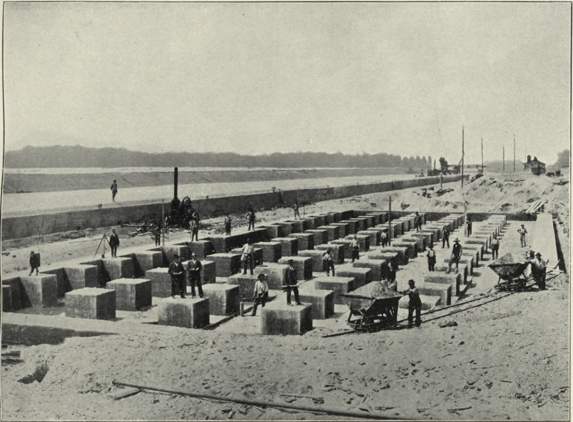
Mittelbecken und Gründung der Werfthalle.
