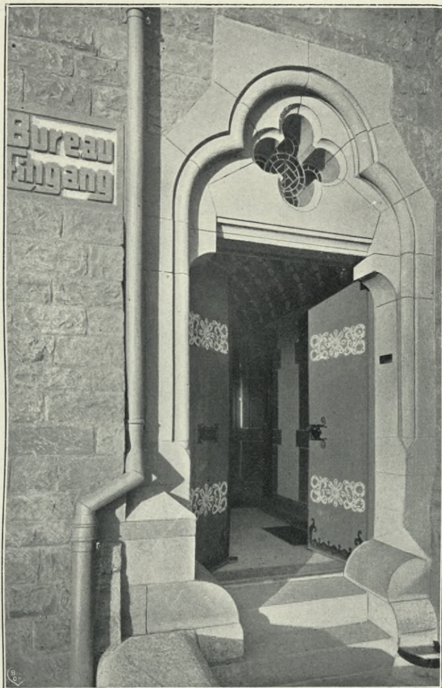
Verwaltungsbau. Eingang zu dem Hafenam.
