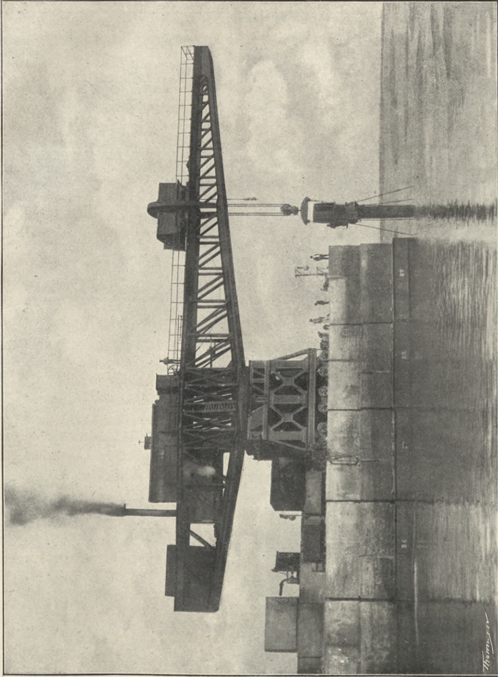
VISTA DE LA GRÚA «TITÁN» DE 60 T m . Y CAMPANA DE BUZO, EMPLEADAS EN LA CONSTRUCCIÓN DEL ROMPEOLAS
