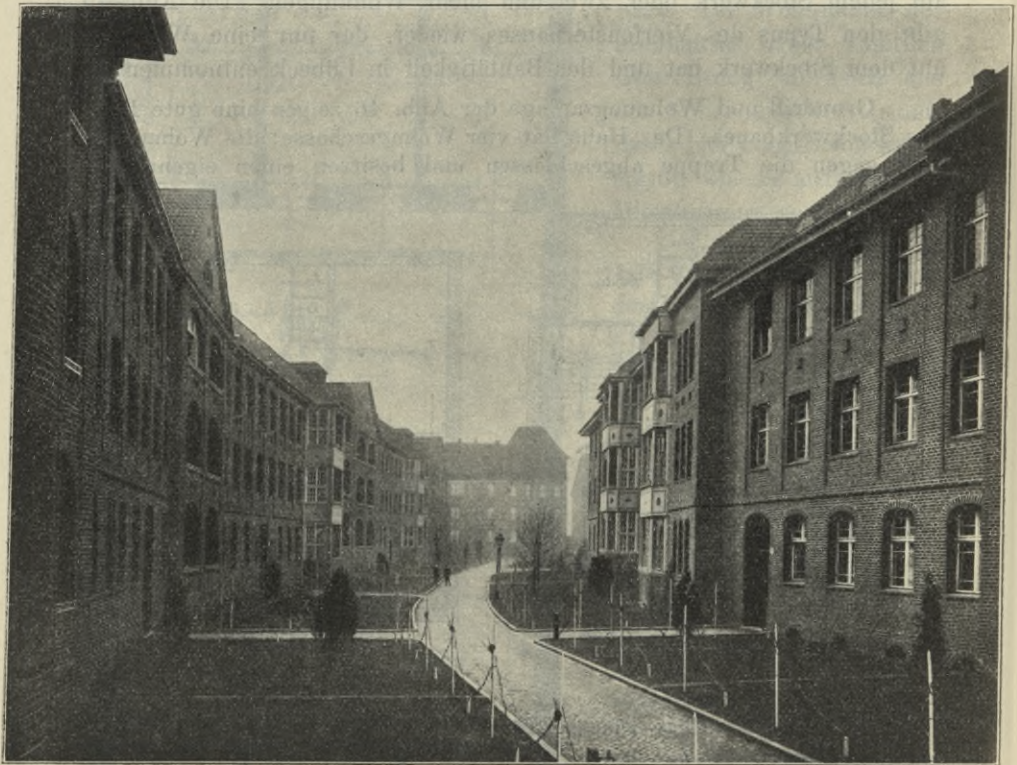
Abb. 47. Dreigeschossige Wohnhäuser (Reihenbau) in Berlin-Steglitz.
