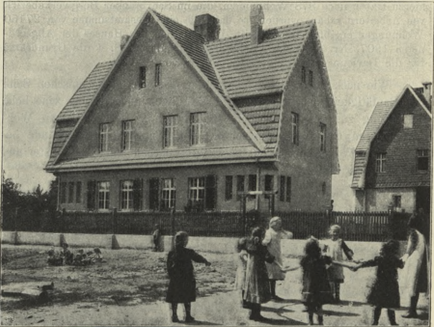
Abb. 75. Beamtenwohnhäuser im Eisenbahndirektionsbezirk Kassel.
