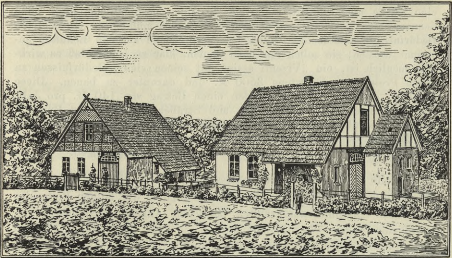
(Haus 1) (Haus 2) Abb. 111. Arbeiterhäuser in Bethel-Bielefeld.
