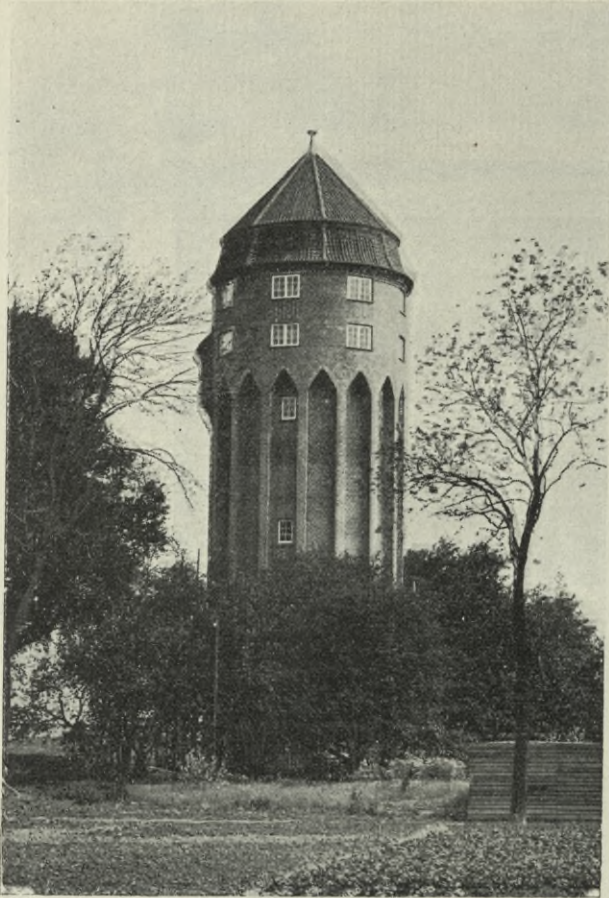
Wasserturm des Kaiserlichen Kanalammtes in Brunsbüttel. Entwurf von Regierungsbaumeister Klatt.
