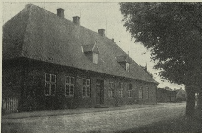
Altes Schulhaus in Schönwalde.
