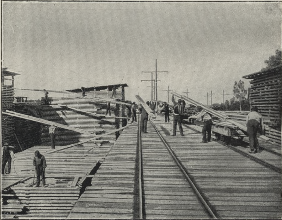
Abb. 25. Gleisanlage auf der Sägemühle.
