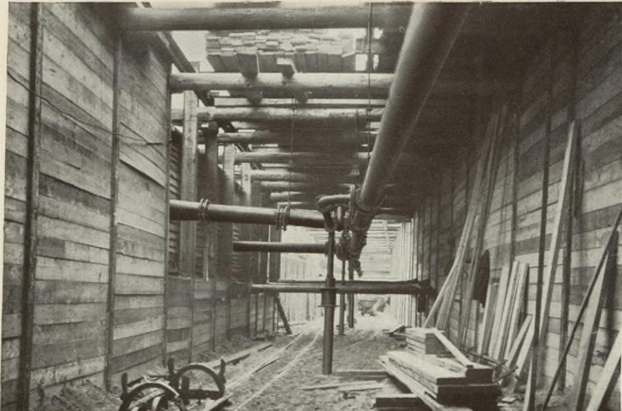
Leitungsanlage mit Anschluß an die Pumpstelle im Südtunnel am Auguste-
