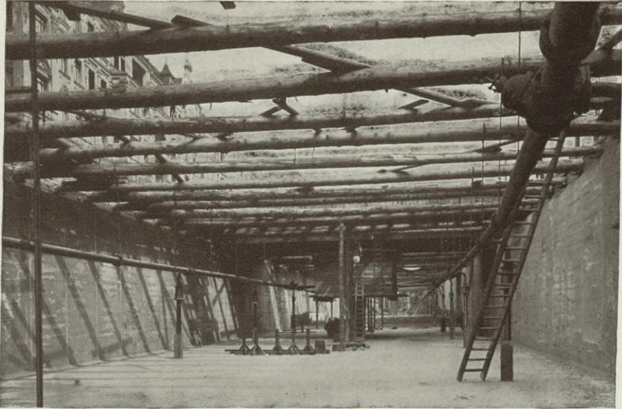
Zwei Saugleitungen in der Tunnelbaugrube am Hohenzollernplatz; in der Mitte die aufgehängte Pumpstelle
