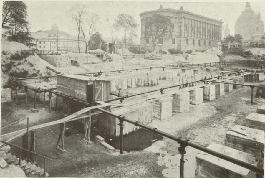
Anlage der Saugleitungen und des Maschinenschutzhauses für die Pumpen
