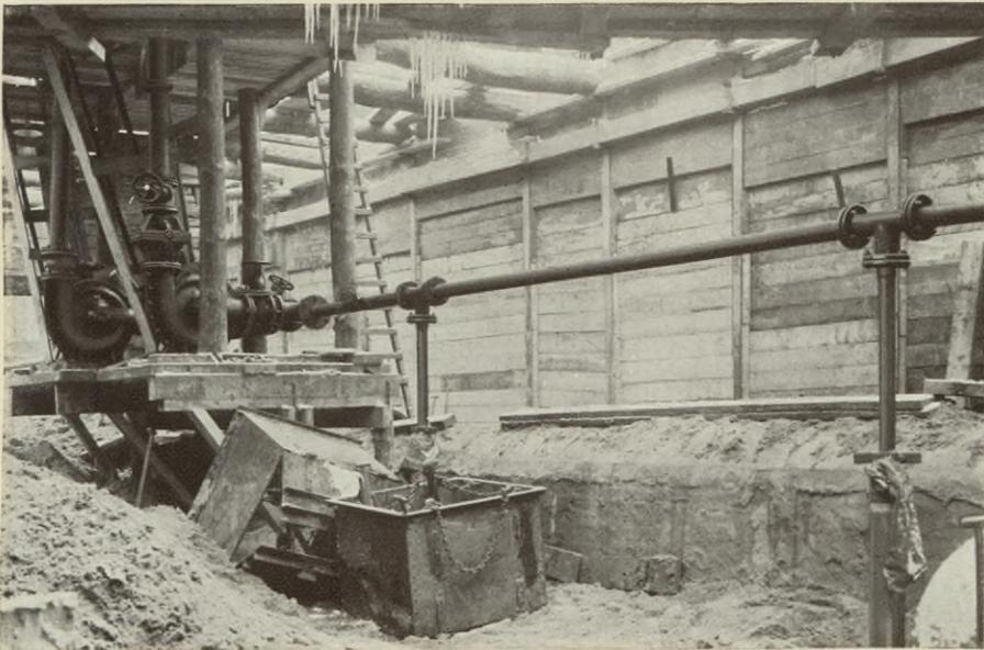
Dückerbaugrube am Hohenzollernplatz. Absenkung durch zwei Kreiselpumpen
