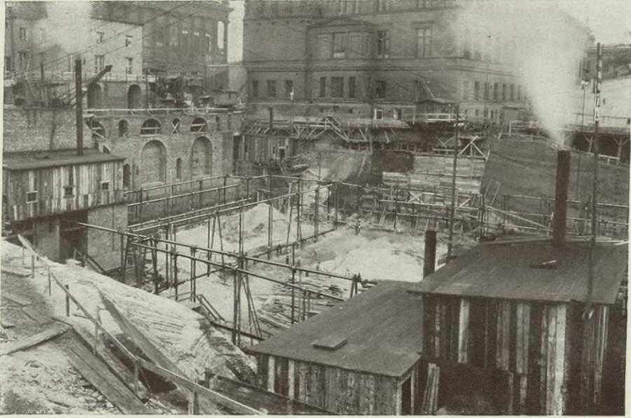
Absenkungsanlage für den zweiten Flügelbau am Kupfergraben
