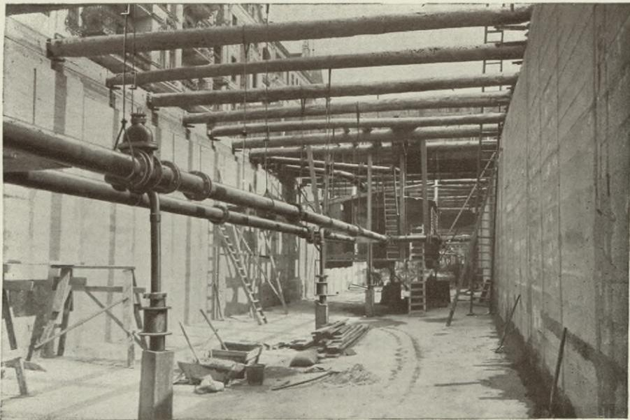
Tunnelbaugrube am Hohenzollerndamm. Im Vordergrund Aussparung in der Tunnelsohle zwecks Ziehens der Brunnen und nachträglicher Ausführung der Sohlendichtung.
