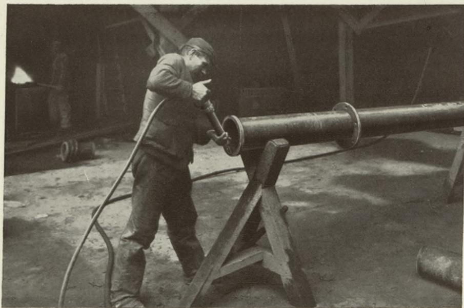
Herrichten der schmiedeeisernen Flanschenrohre und Aufziehen der Bordringe
