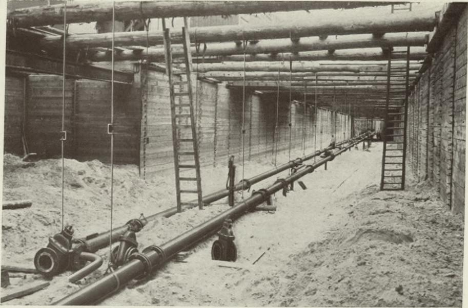
In der Verlegung begriffene Saugleitung in der Tunnelbaugrube
