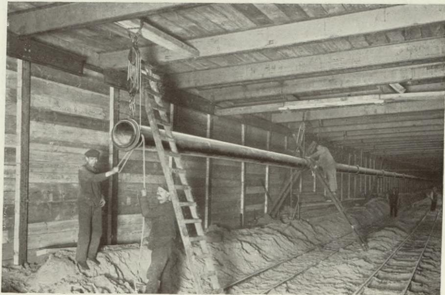
Verlegen der Abflußleitung in der Baugrube
