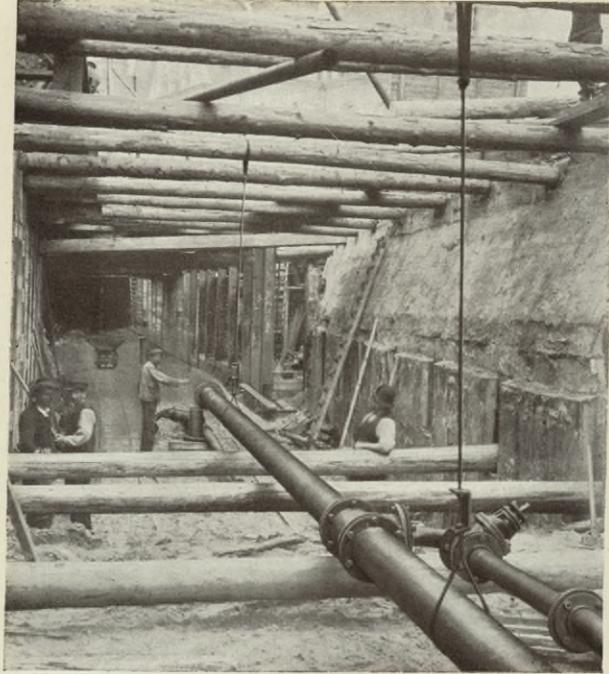
Aufstellung der Wasserhaltungsanlage im Südtunnel
