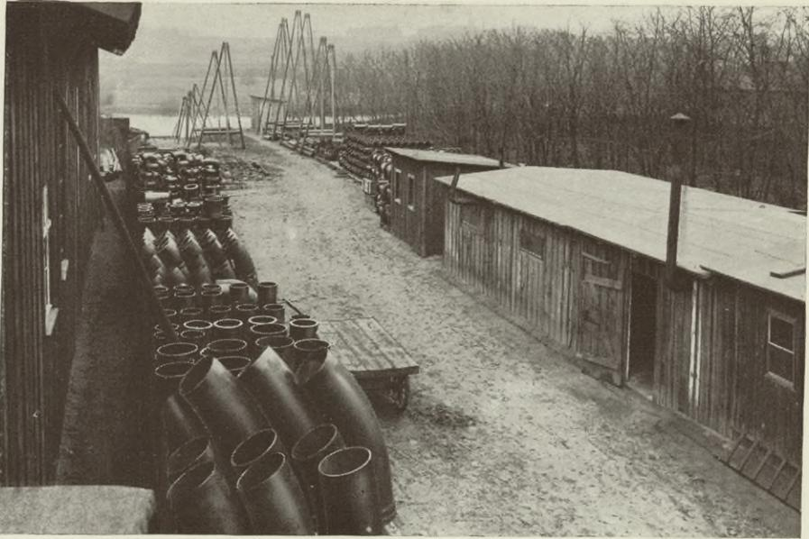
Lager der gußeisernen Formstücke; im Hintergrund Bohrgeräte
