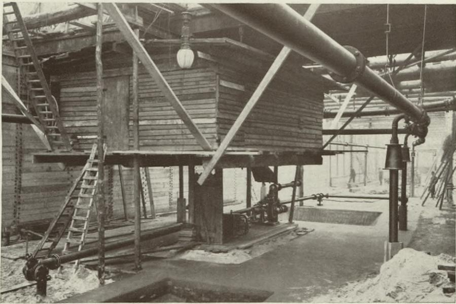
Maschinenanlage in der Tunnelbaugrube am Hohenzollernplatz mit kleiner örtlicher Absenkung für Pumpensümpfe
